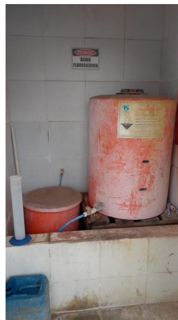
Foto 3.11 – Tanque de Ácido Fluossilícico
