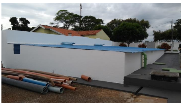
Foto 3.12 – Identificação do reservatório RSE01
