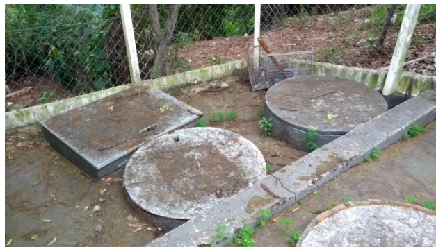
Foto 3.16 – Vista geral da EEE 4
