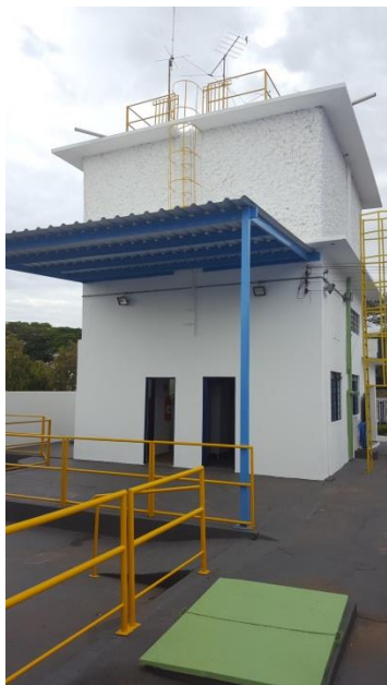
Foto 3.14 – Identificação do reservatório RE03
