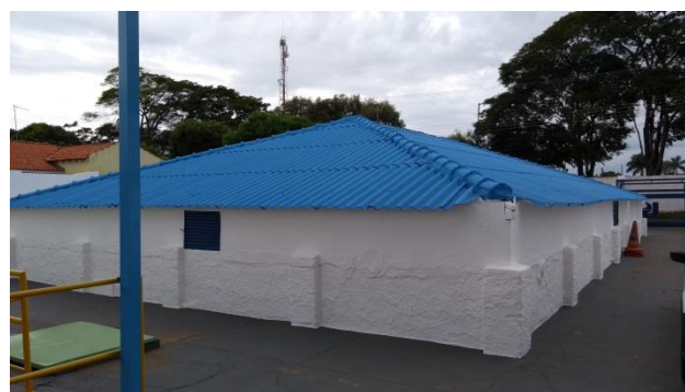
Foto 3.13 – Identificação do reservatório RSE02
