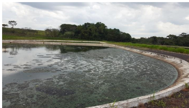
Foto 3.18 – Identificação da Lagoa Anaeróbia
