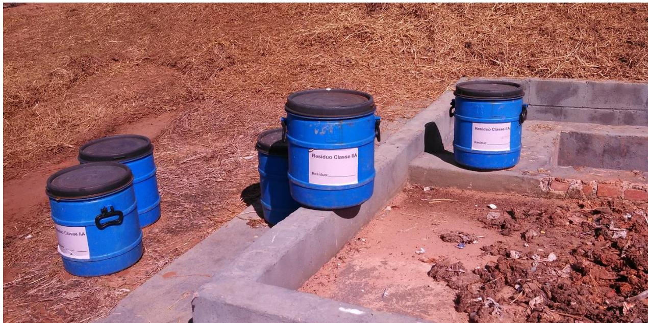
Imagem 45 – lodo originado do esgoto sendo secado e acondicionado em tambores.
