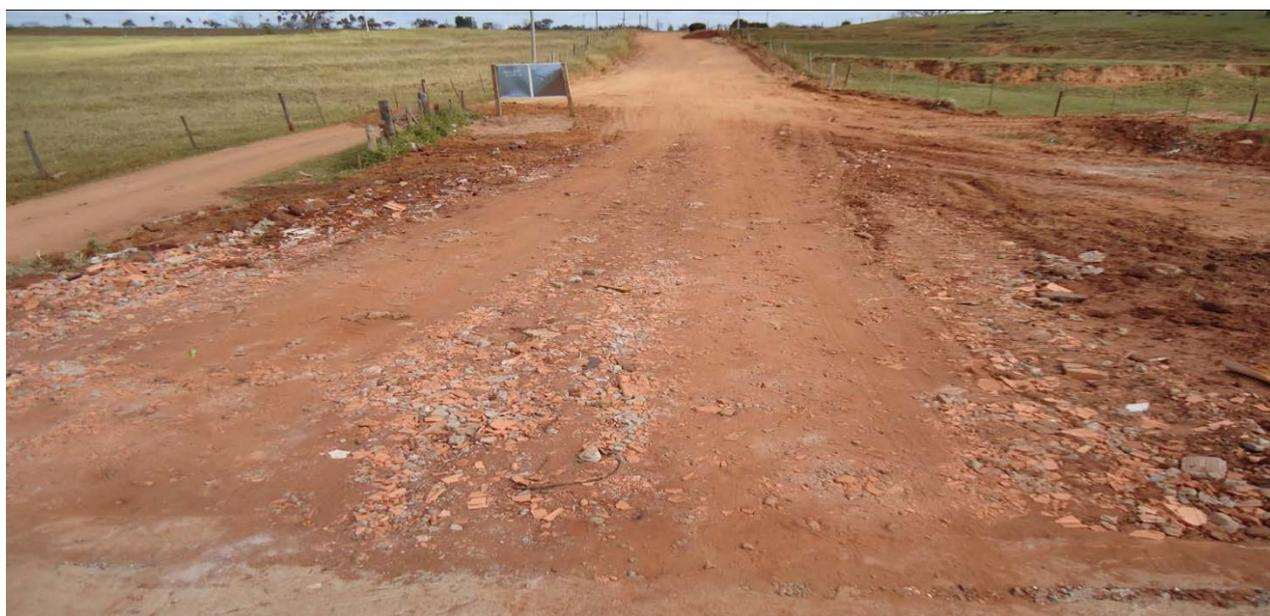
Imagem 32: resíduos da construção civil, depositados e compactados em estrada rural.
