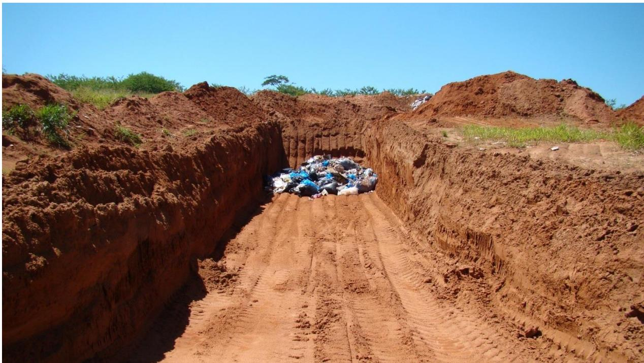
Imagem 18: *vista interna do aterro em valas, com destaque para abertura de valas e destinação final dos resíduos.*
