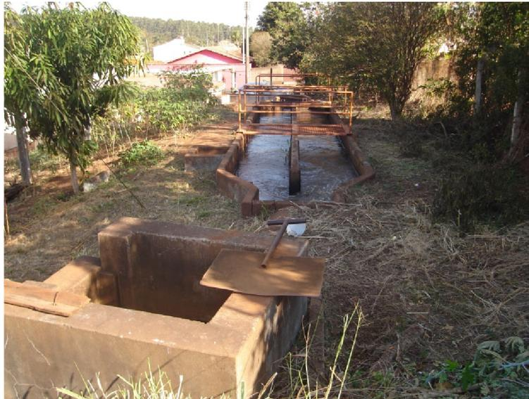
**Figura 3: Caixas de areia para o pré-tratamento da água bruta captada no córrego do Palmito**
