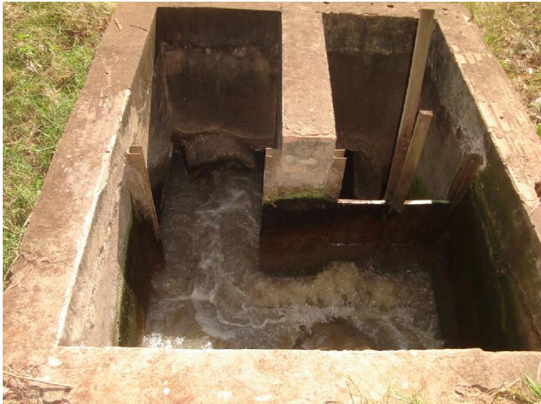
Figura 36: Caixa divisora de fluxo para os dois módulos de tratamento
