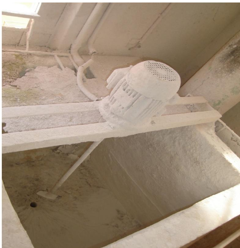
**Figura 16:** Tanque de preparo de suspensão de cal (segundo pavimento da Casa de Química)
