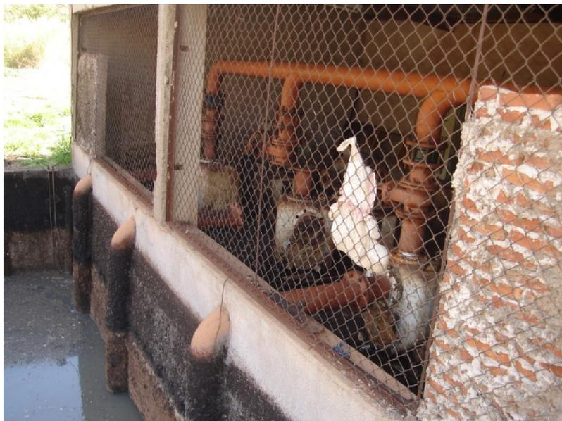
Figura 35: Vista parcial do poço de sucção e dos conjuntos motobomba da EE de esgoto pré-tratado
