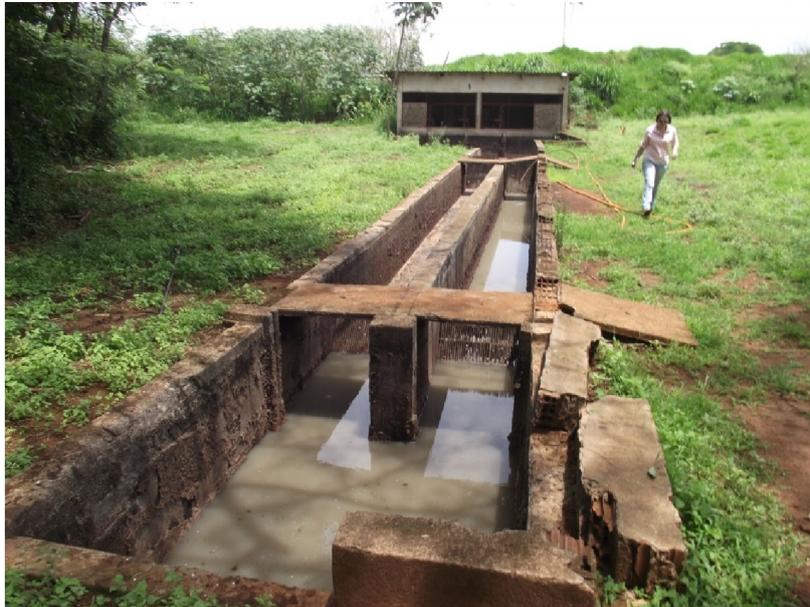
Figura 34: Vista da estrutura de tratamento preliminar composta por grades médias e caixas de areia. Ao fundo, vista da estação elevatória.
