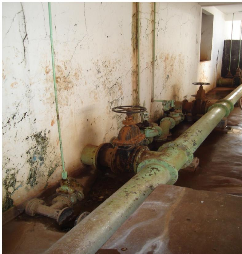
Figura 14: Galeria dos barriletes de água filtrada e de lavagem dos filtros
