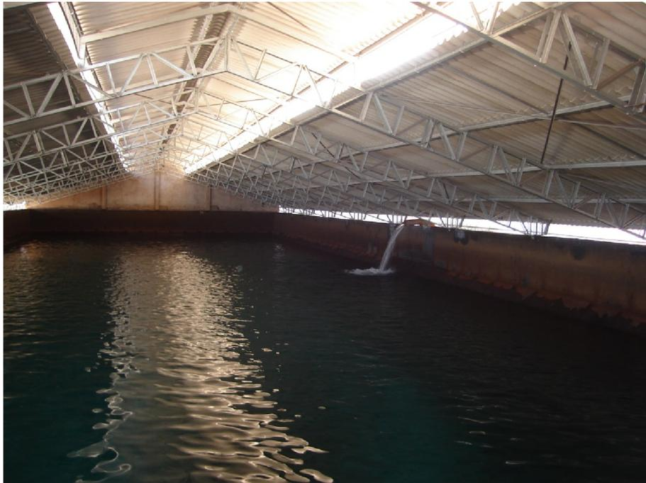
**Figura 27: Vista interna do maior reservatório do CR ETA. Destaque para sua cobertura metálica do tipo telhado de duas águas.**
