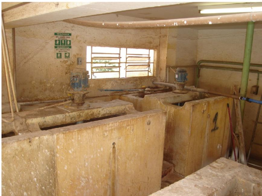
**Figura 17: Tanques de diluição da solução concentrada de sulfato de alumínio (segundo pavimento da Casa de Química)**
