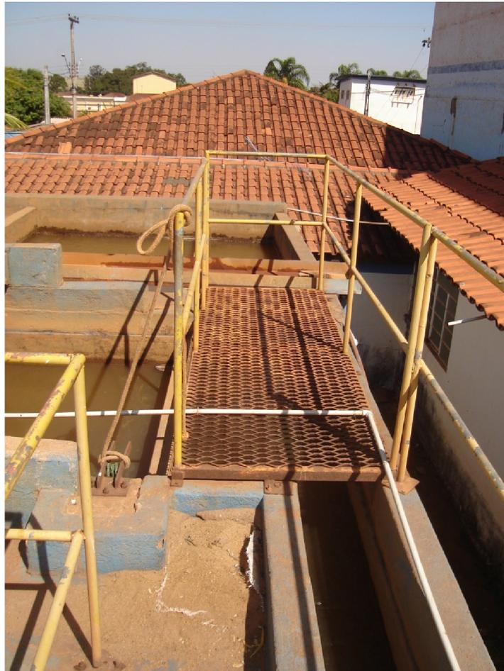
**Figura 9: Vista dos floculadores a partir de sua porção de jusante (Em primeiro plano, vista do trecho inicial do canal de água floculada)**
