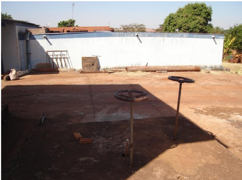
**Figura 28: Vista do reservatório semi-enterrado do CR ETA (poço de sucção da EEAT)**
