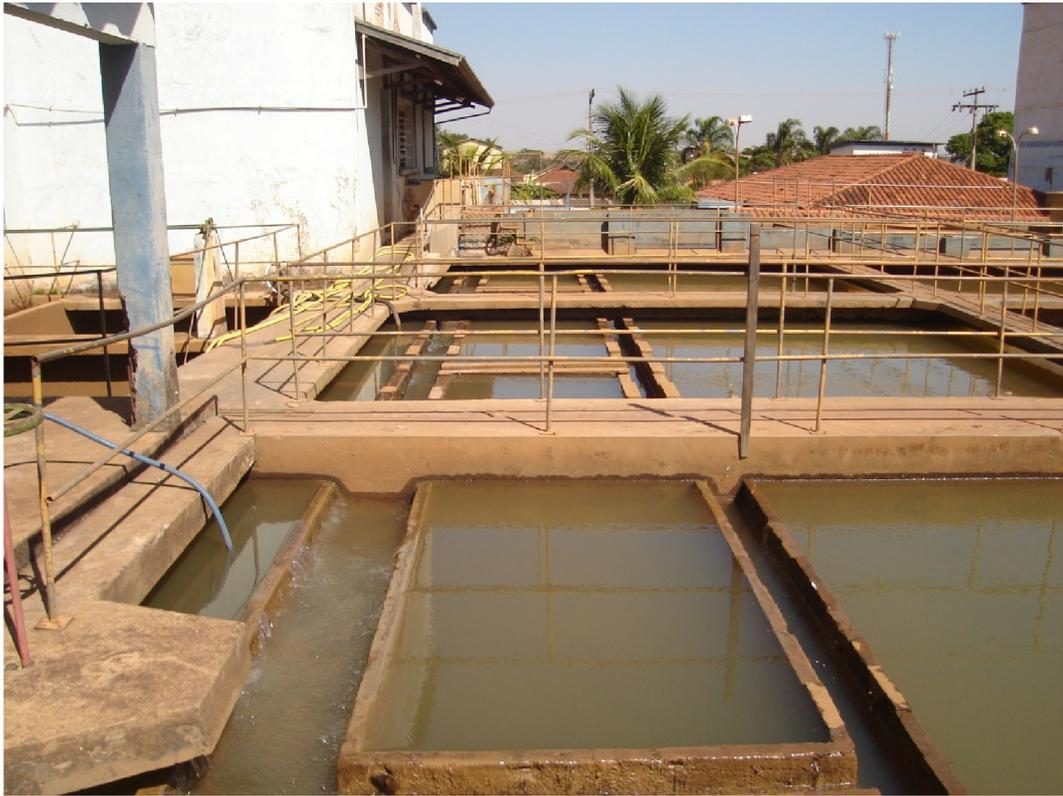
**Figura 11: Vista da porção de jusante dos decantadores com destaque para as calhas de coleta de água decantada**
