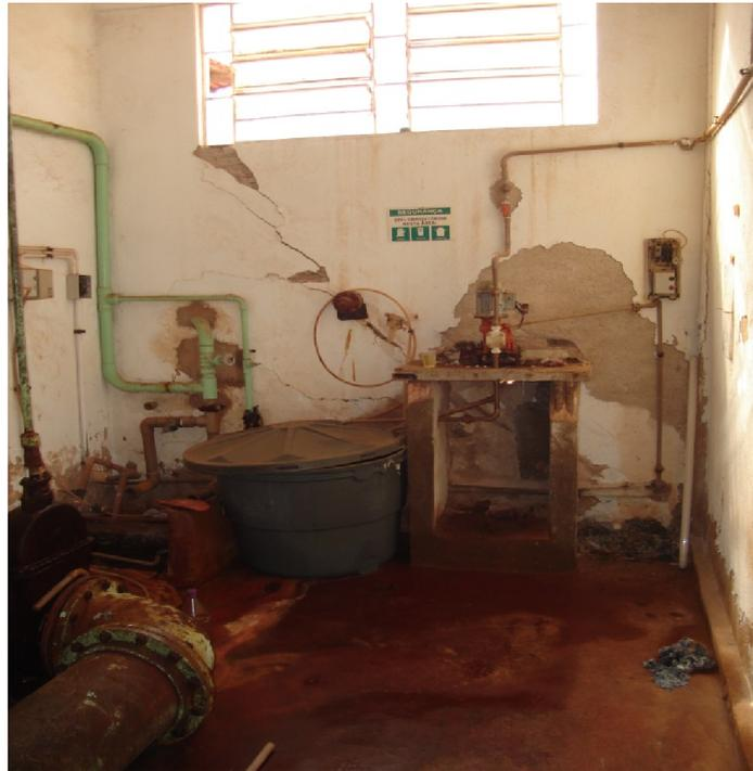
**Figura 21: Sistema de dosagem de hipoclorito de sódio para desinfecção da água filtrada**
