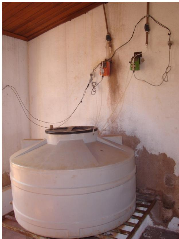
Figura 6: Sistema de armazenamento e aplicação de hipoclorito de sódio para pré-oxidação da água bruta e desinfecção da água captada pelos poços P1 e P5
