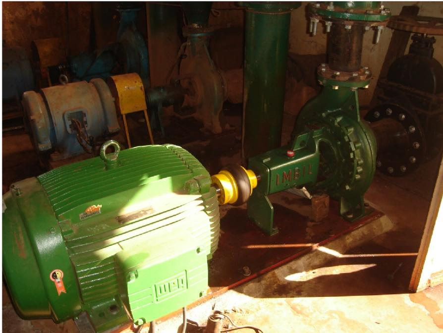
Figura 5: Conjunto motobomba recentemente implantado na EE de água bruta que alimenta a ETA
