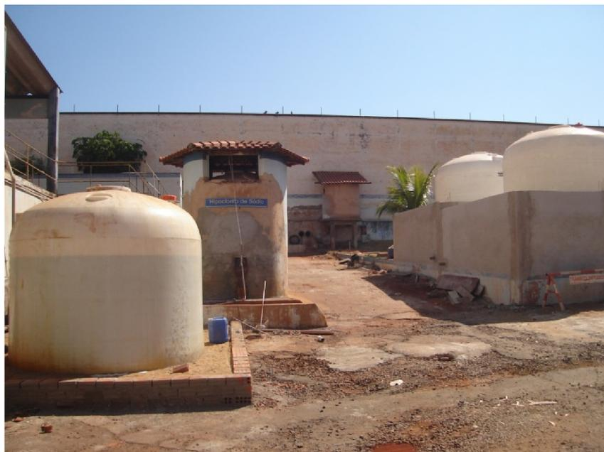
**Figura 15:** Vista dos tanques estacionários. Em primeiro plano, tanque provisório para o armazenamento de sulfato de alumínio. Em segundo plano a esquerda, tanque de hipoclorito de sódio e, a direita, tanques definitivos para o sulfato de alumínio (em fase de implantação).
