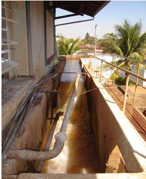
**Figura 7: Canal de chegada de água com aplicação de cal hidratada em sua porção inicial e sulfato de alumínio imediatamente a montante do vertedor**
