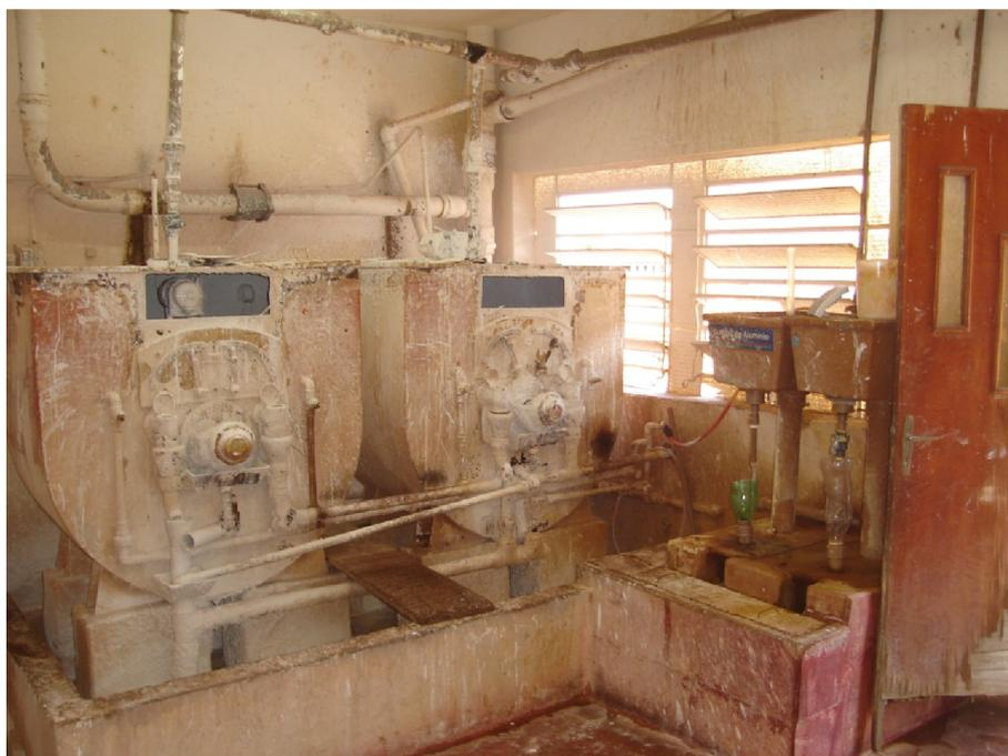
**Figura 18: Dosadores de canecas para a cal hidratada (a esquerda), dosadores de nível constante para o sulfato de alumínio (a direita), localizados no primeiro pavimento da Casa de Química.**
