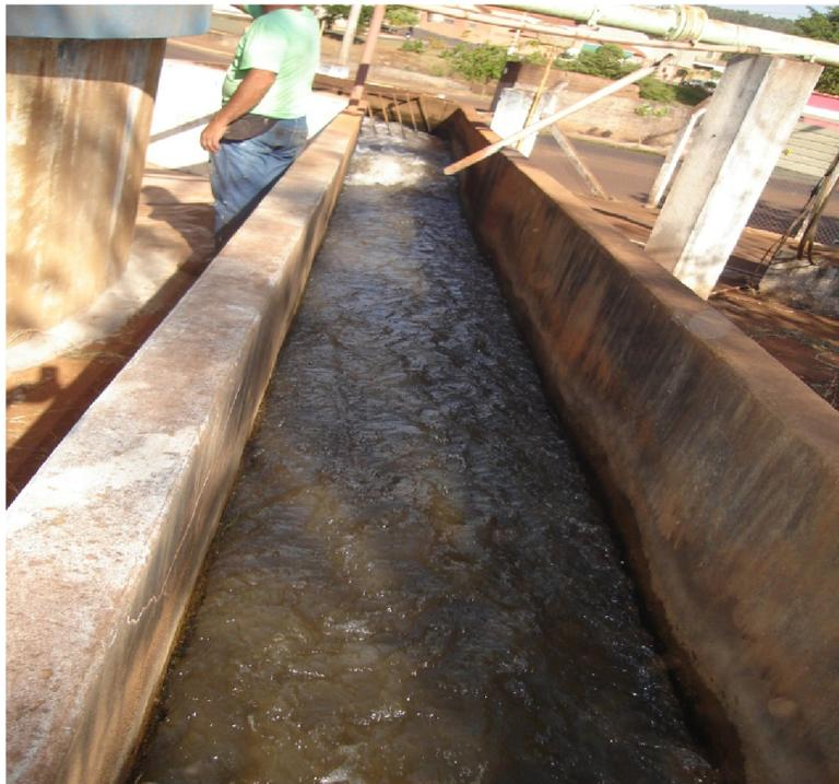
**Figura 4: Canal de água bruta a jusante das caixas de areia**
