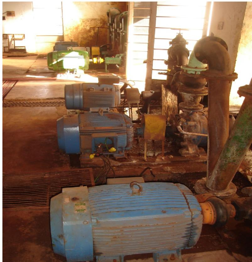
**Figura 24: Em primeiro plano, vista dos conjuntos motobomba da EEAT do Sistema de Produção dos Poços P1 e P5.**
