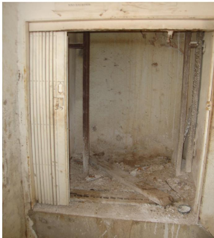
**Figura 20: Monta carga para transporte das sacas e cal e de sulfato de alumínio**
