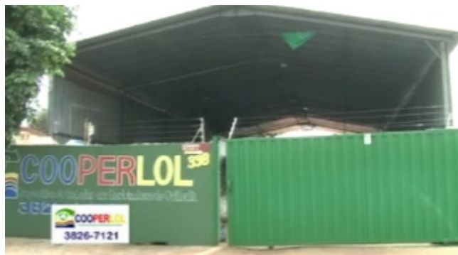
Figura 19. Galpão da Cooperativa dos Recicladores de Orlândia
