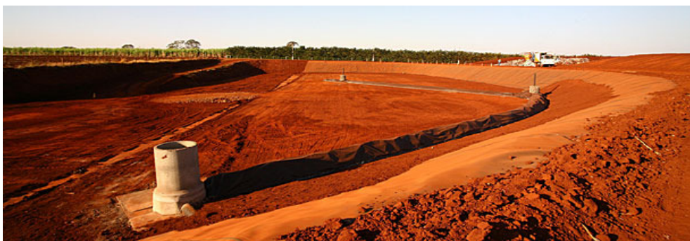
Figura 18. Instalação da CGR Jardinópolis
