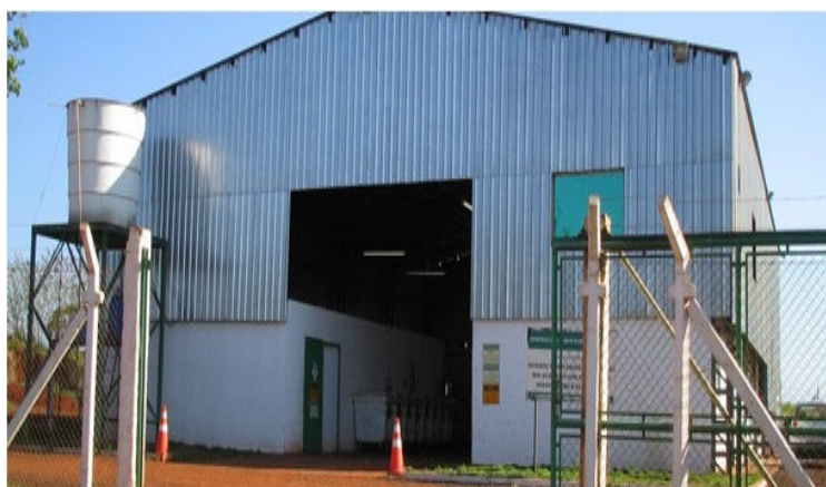
Figura 22. Unidade de Tratamento Térmico
