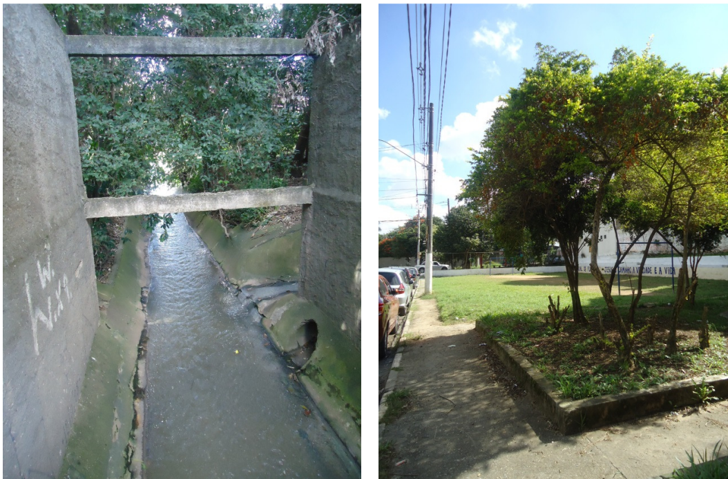
Figura 23 – Córrego Golfe Clube, afluente do córrego Bussocaba, trecho canalizado em seção aberta e seção fechada, sob a quadra de futebol
