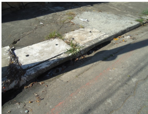
Figura 46 – Dispositivos de microdrenagem insuficientes e resíduos acumulados em região com registro de inundação, na bacia do Córrego Bussocaba – Rua Otávio Schiavinato
