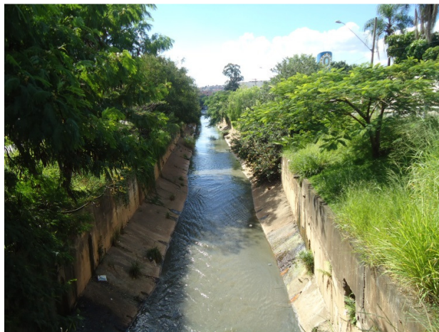
Figura 5 – Trecho canalizado em concreto do Braço Morto do Rio Tietê – prolongamento do Ribeirão Vermelho próximo ao Clube dos Subtenentes e Sargentos do Exército
