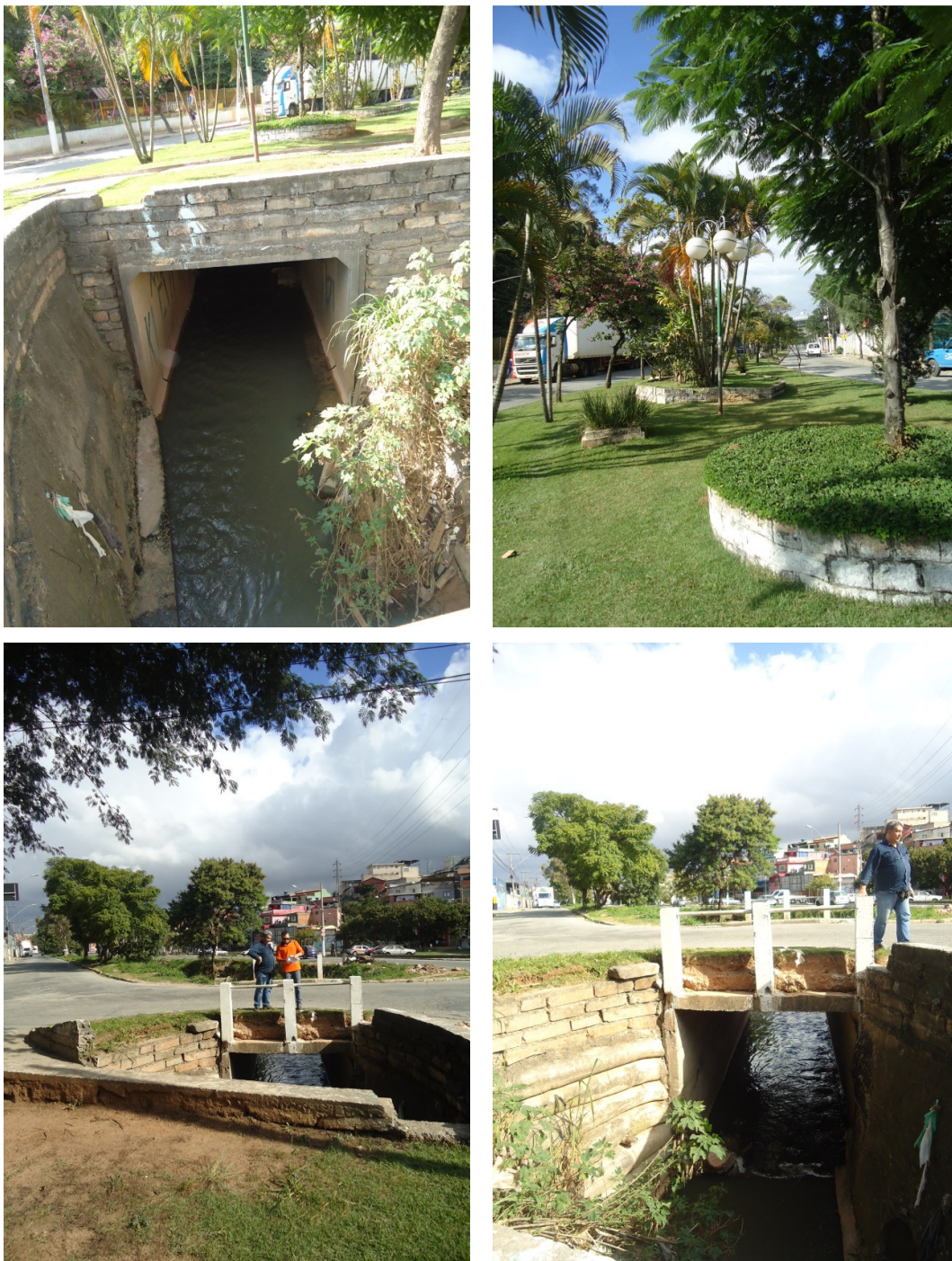
Figura 14 – Córrego Baronesa início do trecho em seção fechada, destaque para a mudança de curso e estrangulamento da seção
