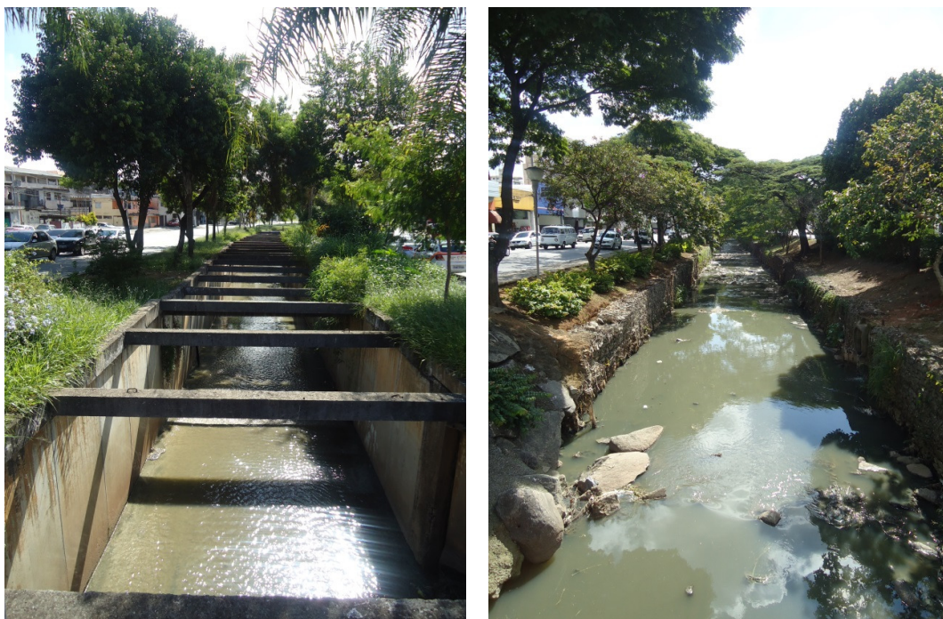
Figura 18 – Córrego Bussocaba trecho canalizado em concreto (esquerda) e em gabião (direita)
