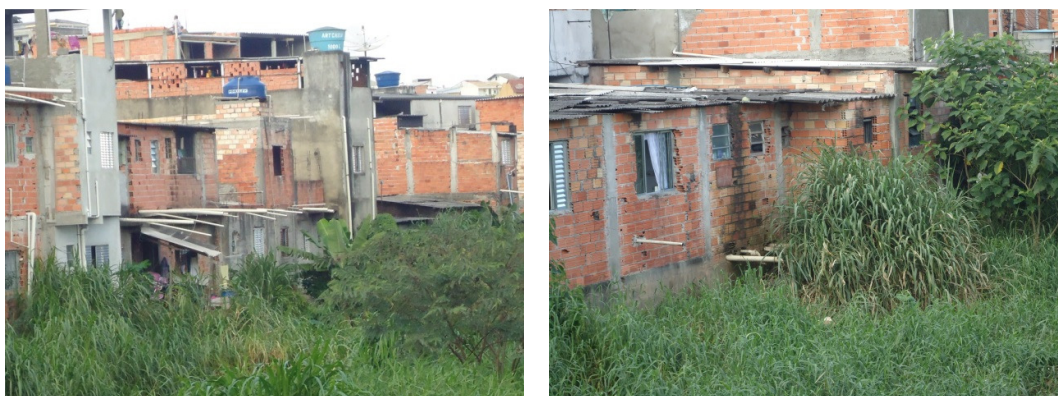
Figura 8 – Tubulações com lançamento de esgoto diretamente no Braço Morto do Rio Tietê
