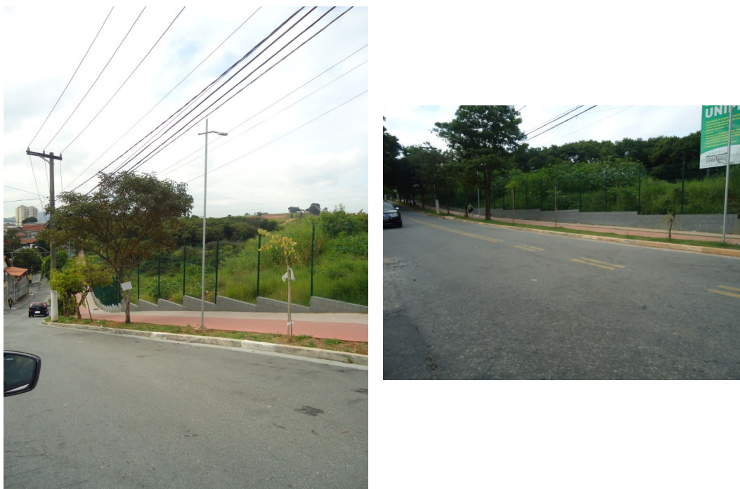
Figura 39 – Rua com declividade acentuada na bacia do córrego Quitaúna e presença de poucas bocas de lobo
