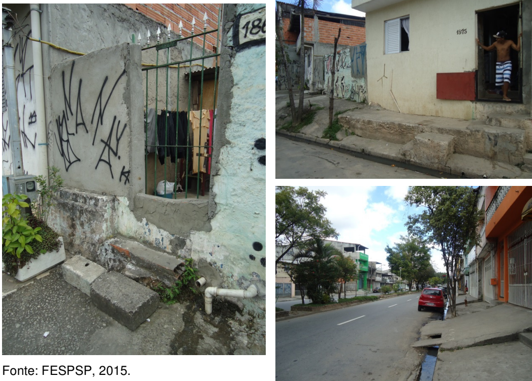
Figura 43 – Ponto de inundação na bacia do Braço Morto, próximo a Avenida Cruzeiro do Sul, destaque para as residências com entrada elevada e comportas
