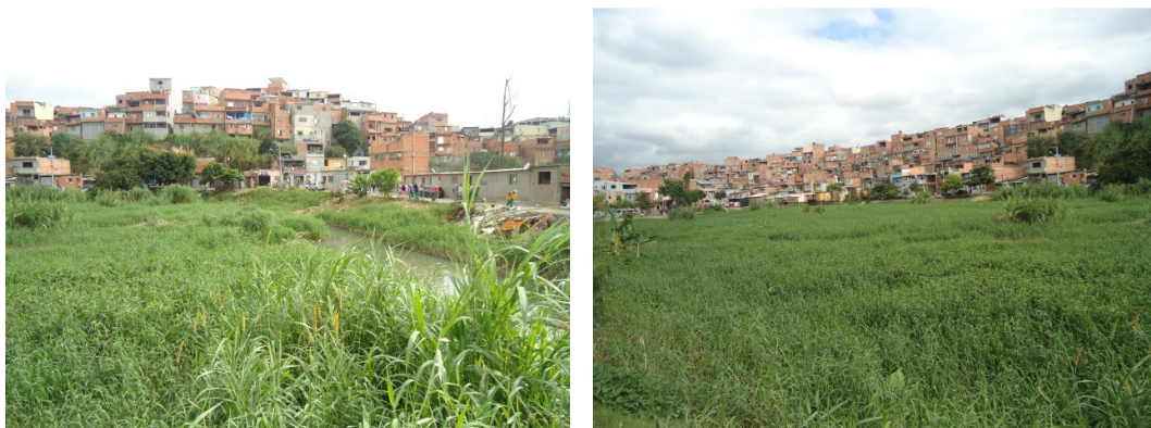
Figura 9 – Vista do reservatório do Rochdale completamente assoreado e com vegetação sobre toda a superfície
