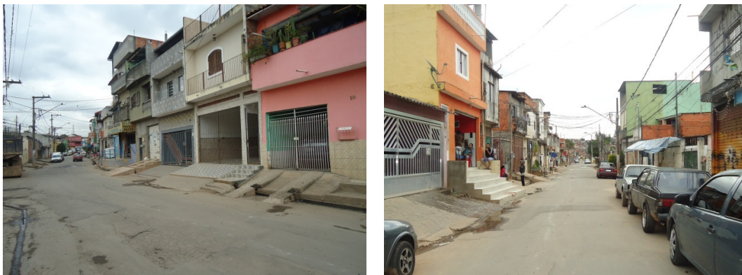
Figura 44 – Ponto de inundação na bacia do Braço Morto, Rua Cuiabá, destaque para as residências com entrada elevada
