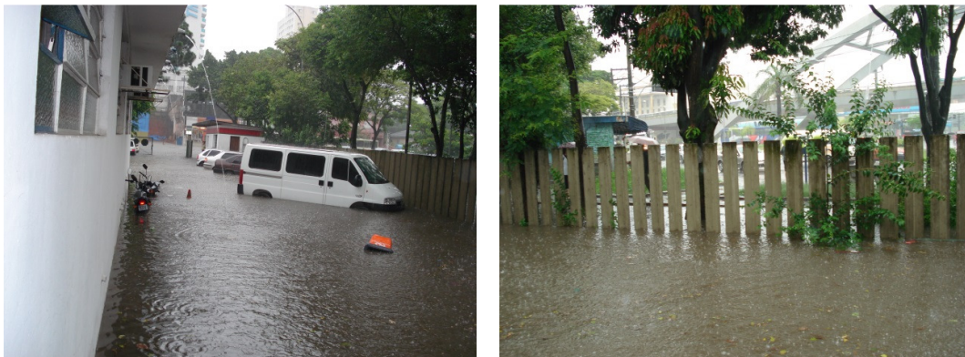
Figura 36 – Bacia do Córrego Bussocaba na Rua Narciso Sturlini
