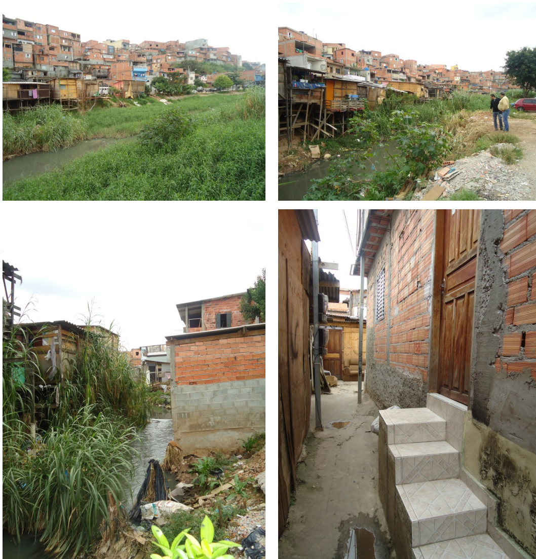
Figura 12 – Ocupação das margens do Braço Morto do Rio Tietê junto ao reservatório do Rochdale.
