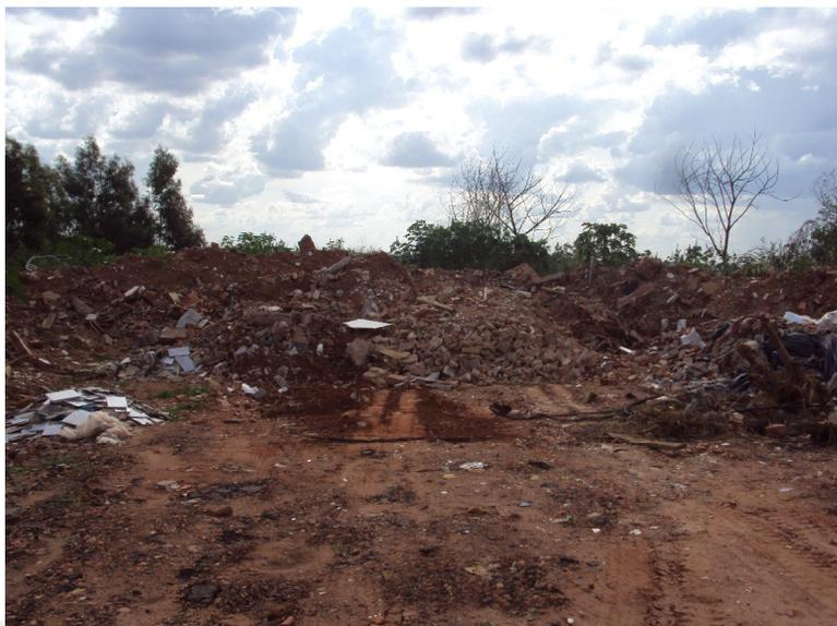
Foto 1 – Resíduo de Construção Civil depositado no aterro
