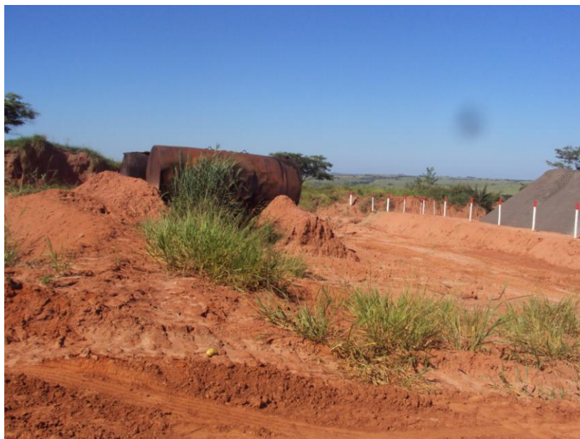
Foto 33 – Área destinada a construção do galpão
