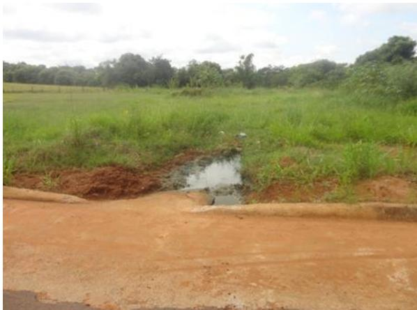
**Foto 3.9 – Saída de águas pluviais do município sede de Palmeira d'Oeste sem revestimento adequado e sem dissipadores de energia**
