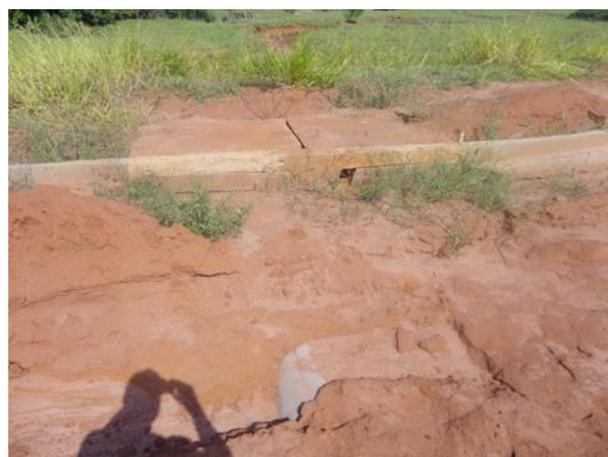
Foto 3.6 – Boca de lobo fechada e obstruída por vegetação e solo
