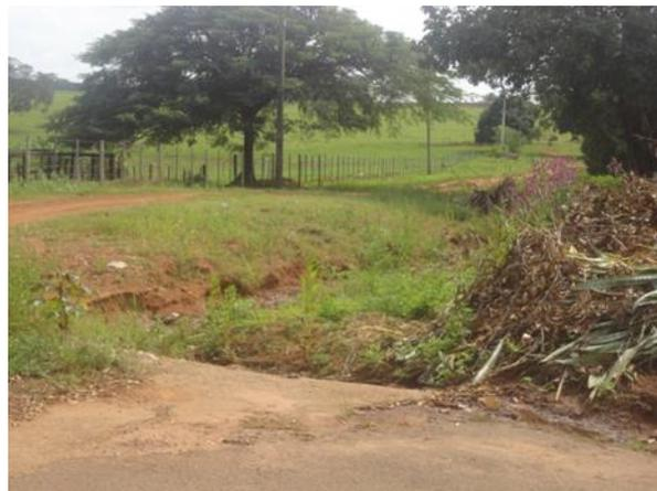
**Foto 3.10 – Saída de águas pluviais do Distrito de Dallas sem revestimento adequado e sem dissipadores de energia**
