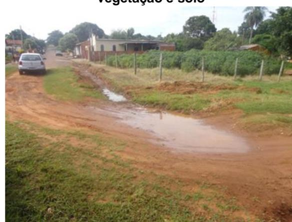
Foto 3.8 – Boca de lobo fechada e obstruída por vegetação e solo
