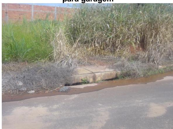
Foto 3.7 – Boca de lobo e sarjeta obstruídas por vegetação
