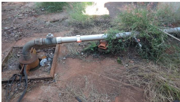
Foto 3.11 - Identificação do Poço: P-11
