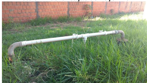
Foto 3.4 - Identificação do Poço: P-04
