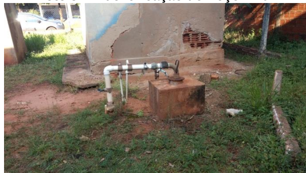
Foto 3.6 - Identificação do Poço: P-06
