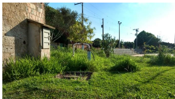
Foto 3.16 - Identificação do Poço: P-16
