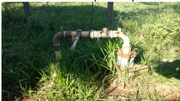
Foto 3.5 - Identificação do Poço: P-05
