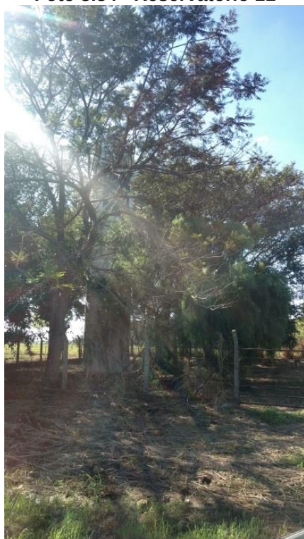
Foto 3.36 - Reservatório Desativado (Aldeia do Lago III)
