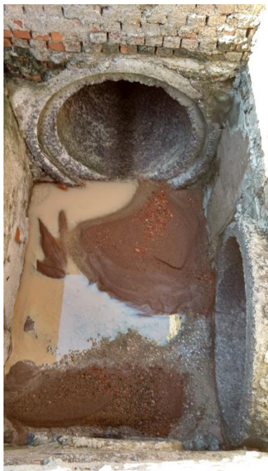
Foto 3.57 - Ponto 5: Alameda F x Rua Vinte e Oito (caixa para conter o remanso, quando o Ponto 4 alaga)
