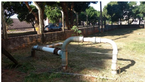
Foto 3.7 - Identificação do Poço: P-07
