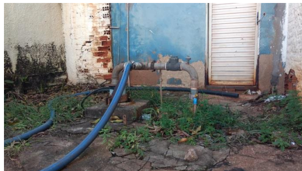
Foto 3.10 - Identificação do Poço: P-10
