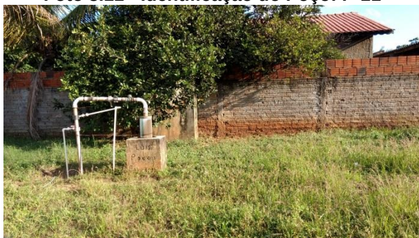
Foto 3.13 - Identificação do Poço: P-13
