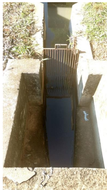
Foto 3.44 - Detalhe do gradeamento
