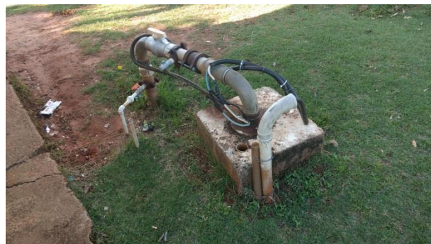
Foto 3.8 - Identificação do Poço: P-08
