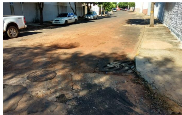
Foto 3.50 - Ponto 2 - Vista da Rua Emílio Condé
