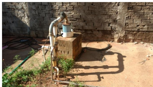
Foto 3.2 - Identificação do Poço: P-02
