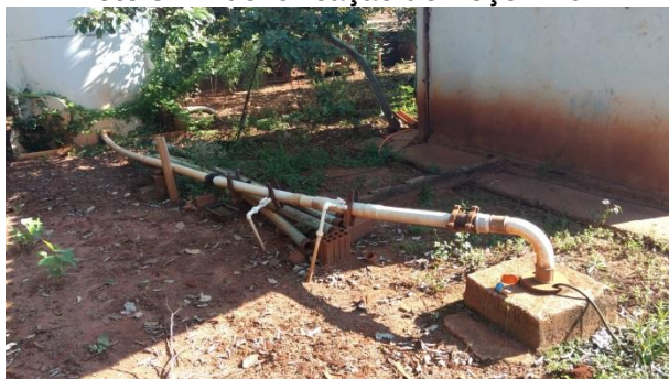
Foto 3.3 - Identificação do Poço: P-03
