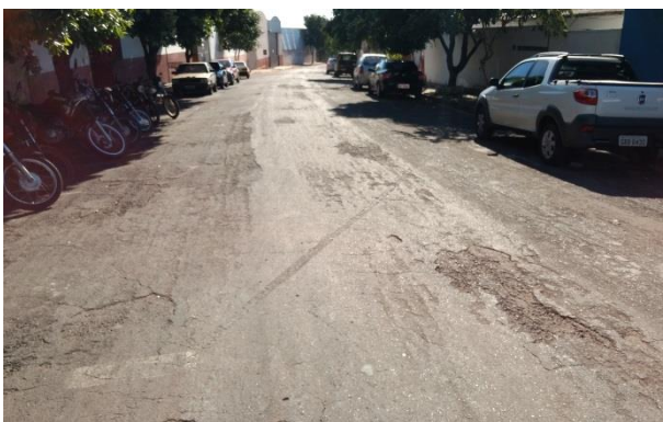
Foto 3.49 - Ponto 1 - Vista da Rua Emílio Condé
