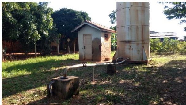
Foto 3.9 - Identificação do Poço: P-9
