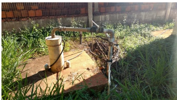
Foto 3.1 - Identificação do Poço: P-01
