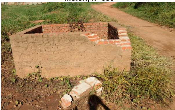
Foto 3.56 - Ponto 5: Alameda F x Rua Vinte e Oito (caixa para conter o remanso, quando o Ponto 4 alaga)
