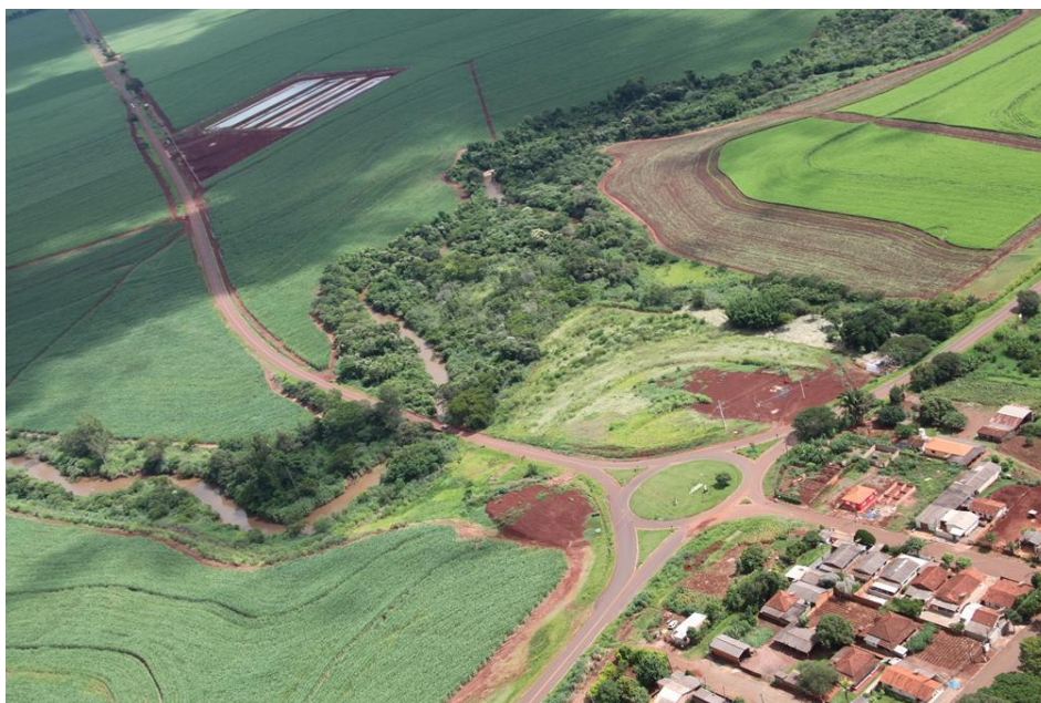
Foto 12 - Tratamento de Esgoto no Distrito de Roseta.
