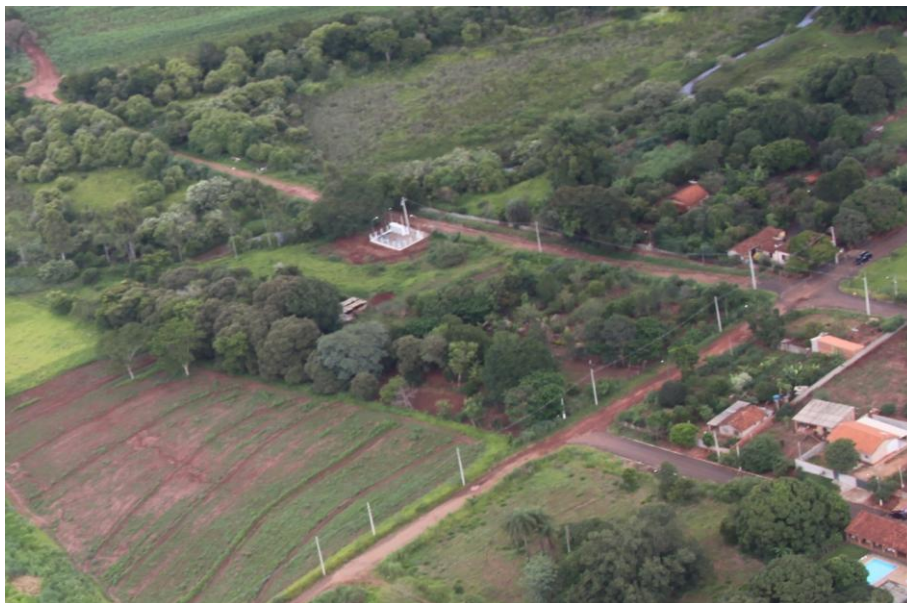
Foto 13 - Tratamento de Esgoto no Distrito de Conceição de Monte Alegre.
