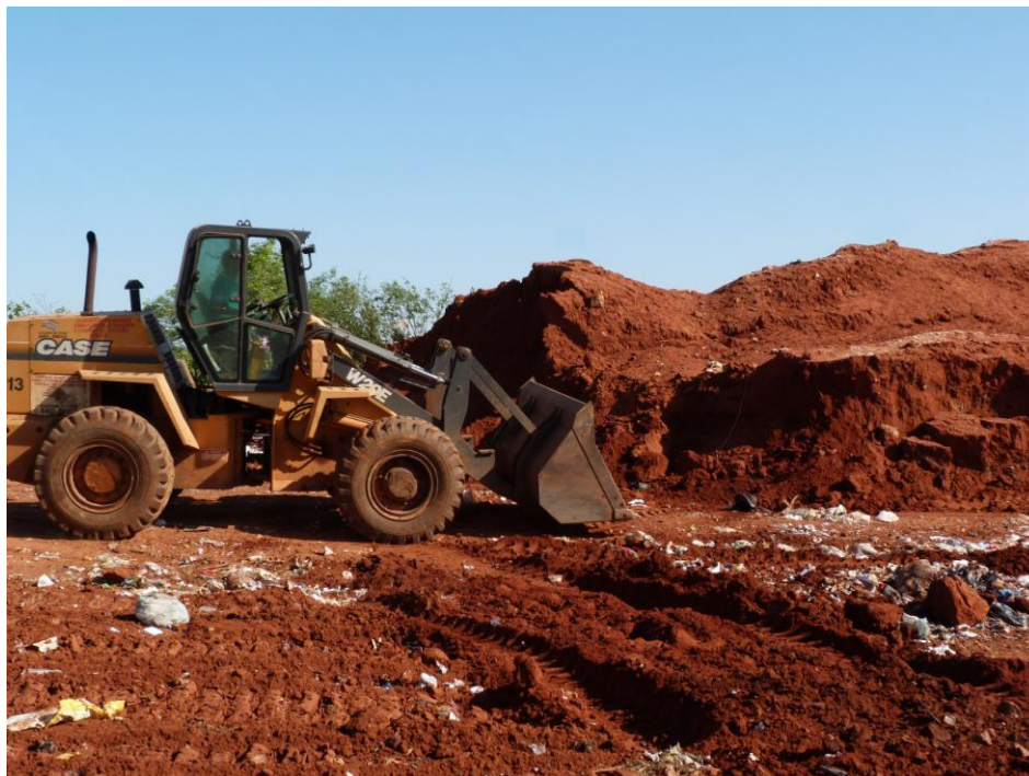
Foto 24 - Compactação de resíduos sólidos urbanos na área do atual vazadouro – Paraguaçu Paulista/SP – fonte: Prefeitura de Paraguaçu Paulista
