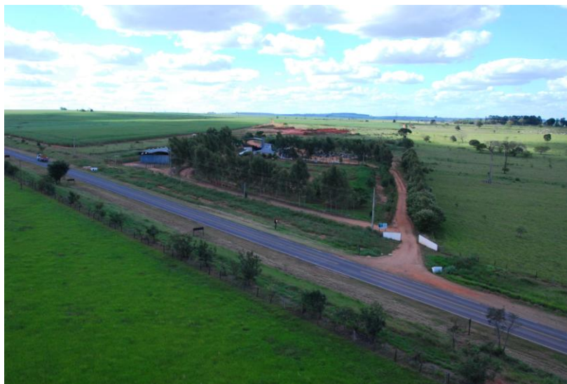
Foto 25 - Vista entrada do Aterro em valas – fonte: Prefeitura de Paraguaçu Paulista
