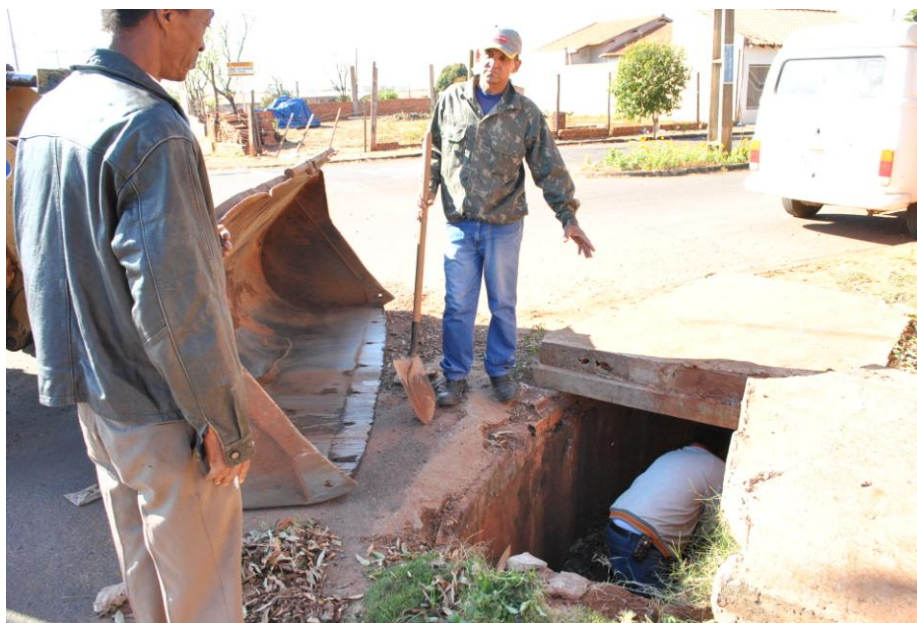
Foto 27 - Funcionários da Prefeitura Municipal executando a limpeza de boca-de-lobo.
