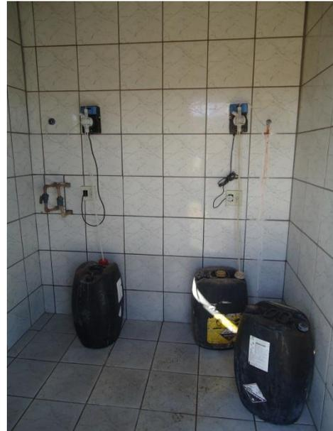
Foto 3.15- Unidade de Fluoretação e Cloração com bomba dosadora – Sistema Velório – P8
