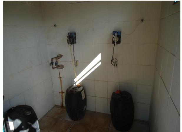
Foto 3.13- Unidade de Fluoretação e Cloração com bomba dosadora – Sistema Creche – P6
