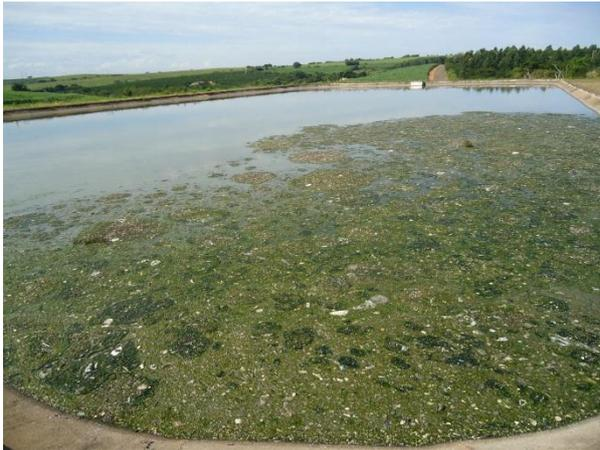
Foto 3.28 – Sobrenadante na Lagoa Anaeróbia
