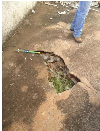
Foto 6.2 – R-06 – Infiltração no calçamento
