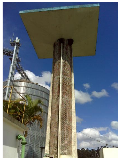
FOTO 4.11 – RESERVATÓRIO ELEVADO DE 120M 3 , ETA HOLAMBRA II
