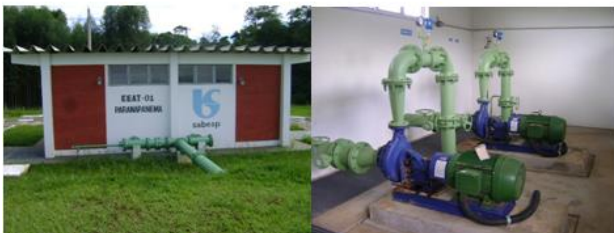
FOTOS 4.5 E 4.6 – EEAT-01, ETA PARANAPANEMA.
