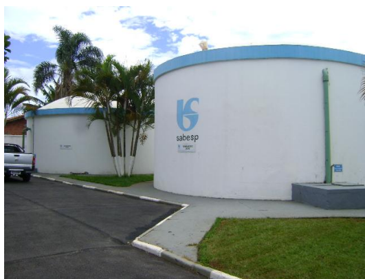
FOTO 4.7 – RESERVATÓRIOS DE 250M³, SEDE DO MUNICÍPIO DE PARANAPANEMA
