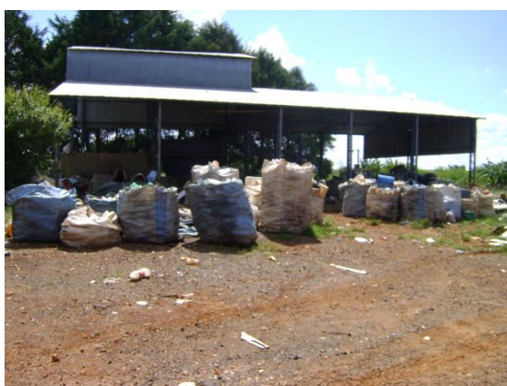
FOTO 4.24 – GALPÃO DA COLETA SELETIVA DE PARANAPANEMA.
