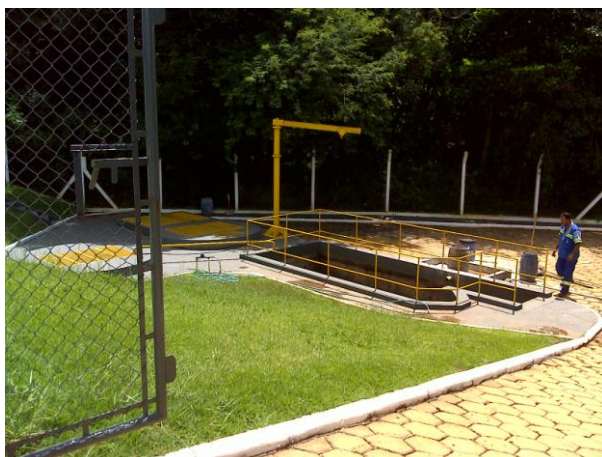
FOTO 4.13– ESTAÇÃO ELEVATÓRIA DE ESGOTO PARANAPANEMA
