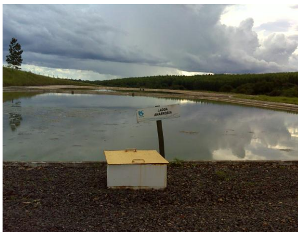
FOTO 4.20– LAGOA ANAERÓBIA ETE HOLAMBRA II.
