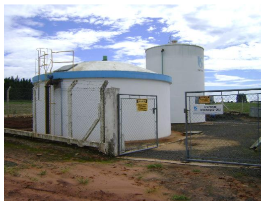
FOTO 4.8 – RESERVATÓRIOS DE 200M³ E DE 150M³, SEDE DO MUNICÍPIO DE PARANAPANEMA.
