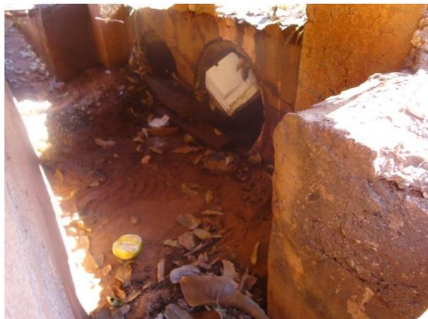
Foto 3.2 – Galeria entupida e assoreada na avenida Circular C
