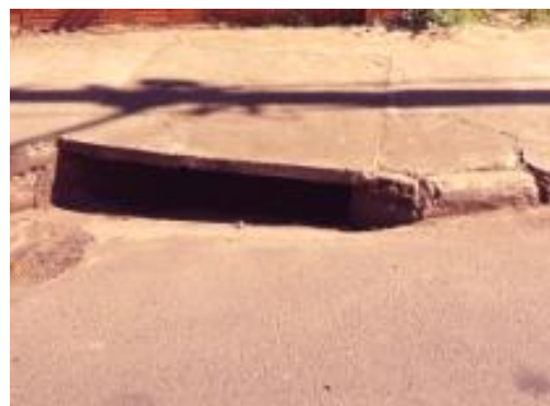
Foto 3.6 - Galeria Rua Euzébio da Rocha Camargo II
