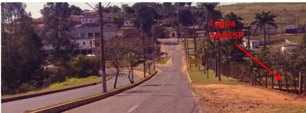
Foto 3.8 – Trecho da Estrada Municipal onde Ocorrem Inundações
