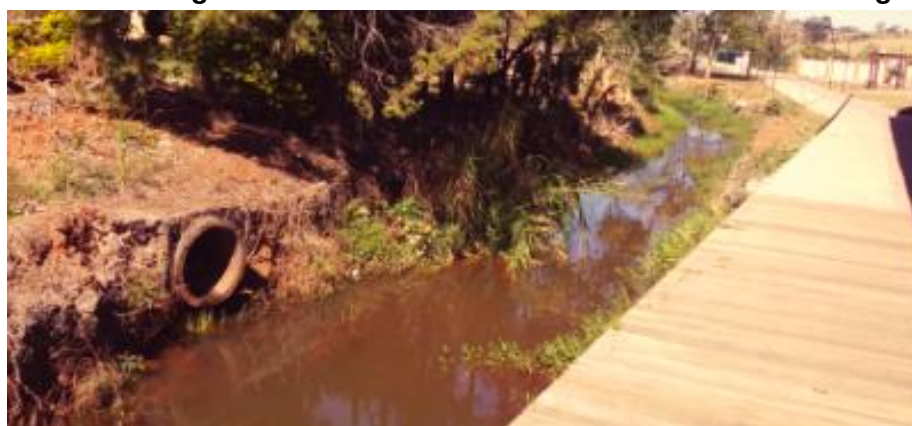
Foto 3.7 – Lançamento da galeria no Rio Pardo
