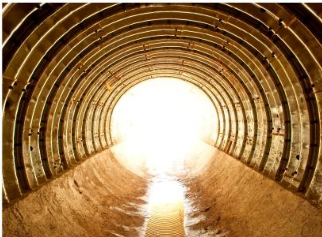
Ilustração 8.8 – BSTM construído por método não destrutivo (MND)
