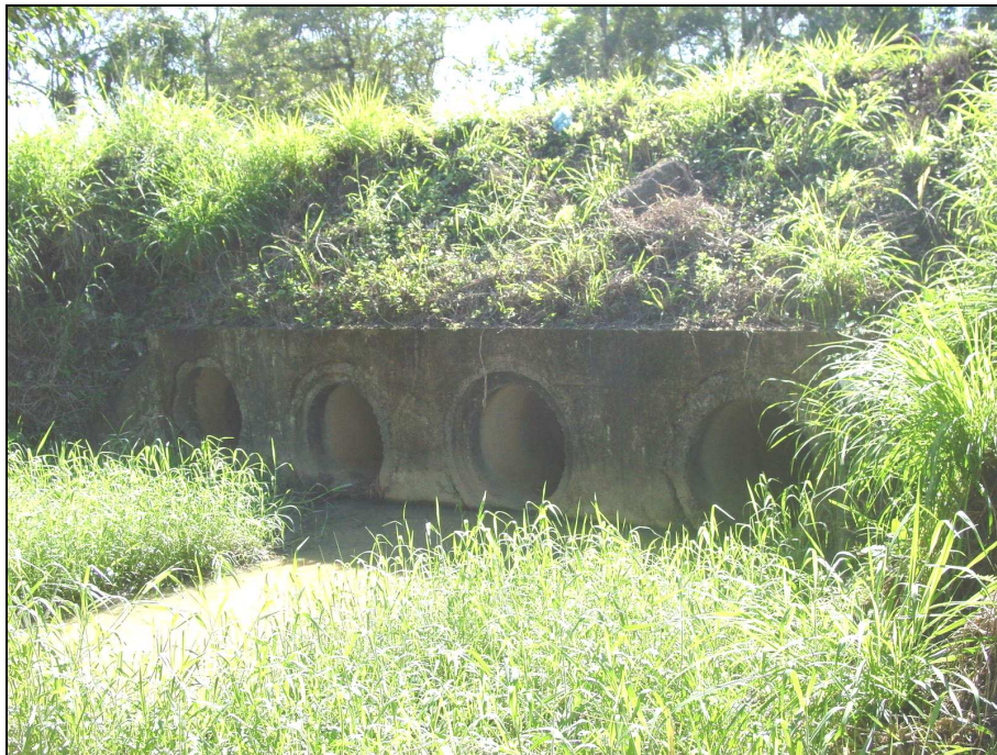
Foto 2 – Travessia Galeria da Rodovia SP-222. Vista a montante
