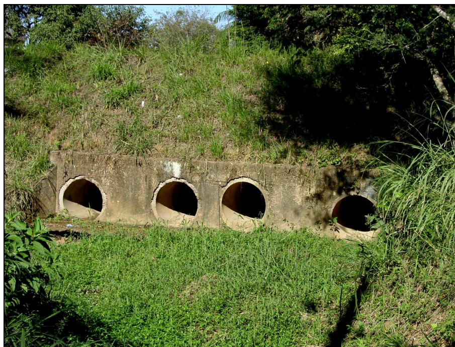
Foto 3 – Travessia Galeria da Rodovia SP-222. Vista a jusante
