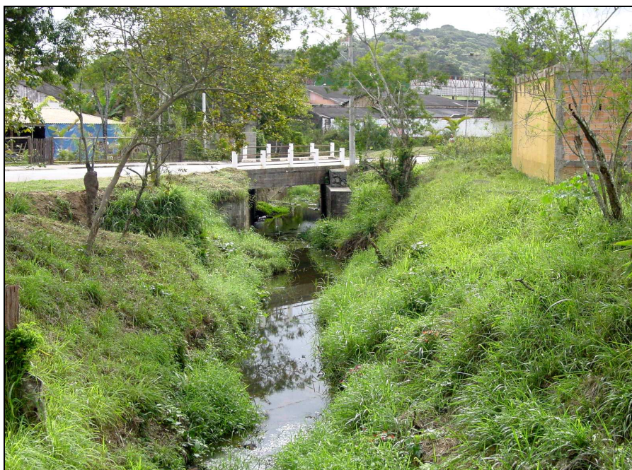
Foto 4 – Córrego Turvo. Margens Regularizadas
