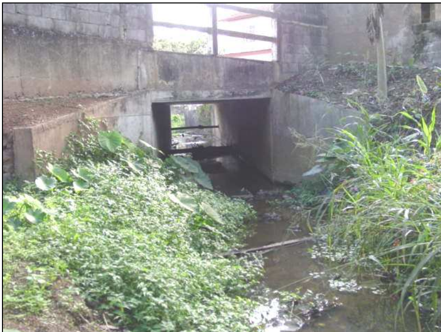
Foto 6 – Córrego Bom Retiro. Ponte e Travessia
