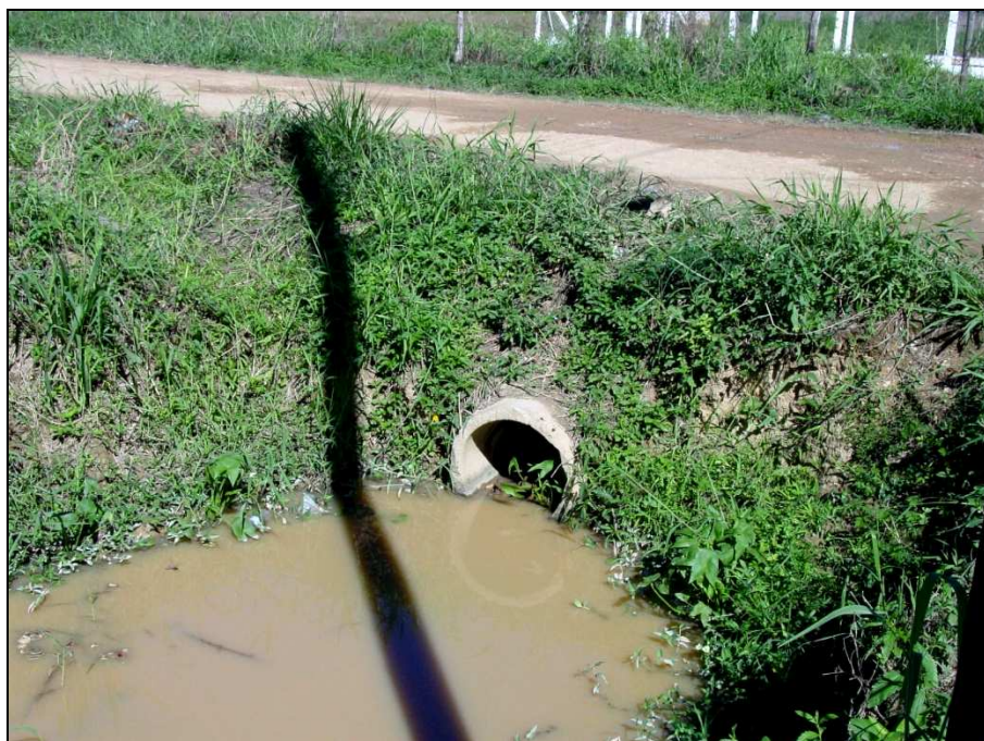
Foto 9 – Travessia de Vala de Drenagem da Rua Pedro Bahia dos Santos
