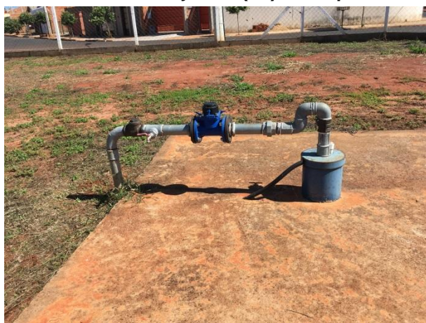
Foto 3.6 – Poço P6 – CDHU 2
