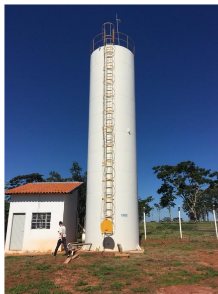
Foto 3.19 – Reservatório elevado – CDHU 2
