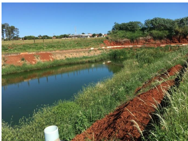
Foto 3.25 – Primeira lagoa anaeróbia – tratamento preliminar
