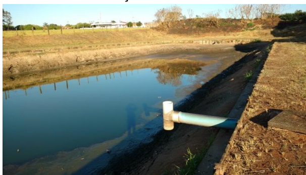
Foto 3.33 – Primeira lagoa de tratamento após limpeza (maio 2016)
