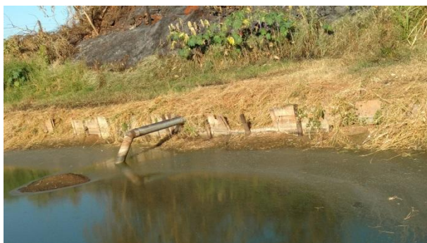
Foto 3.31 – Primeira lagoa anaeróbia antes da remoção do material
