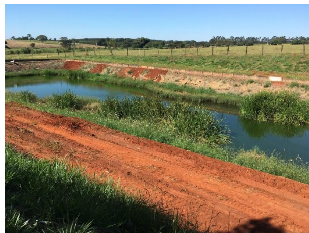
Foto 3.26 – Primeira lagoa anaeróbia – tratamento preliminar
