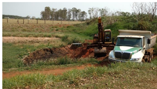
Foto 3.32 – Remoção de todo o material da primeira lagoa anaeróbia
