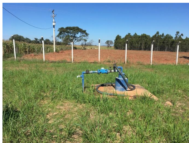
Foto 3.2 – Poço 701 (P2) – Izidoro
