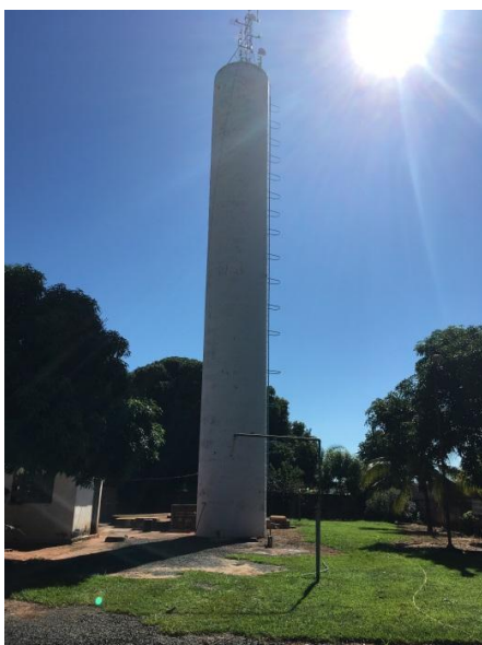
Foto 3.18 – Reservatório elevado - DEARP
