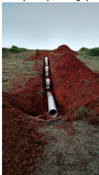
Foto 3.23 – Ligação instalada – finalização
