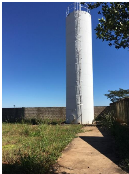
Foto 3.20 – Reservatório desativado – CDHU 1
