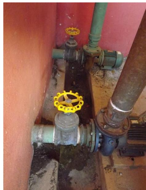
**Foto 3.50 – Detalhe dos conjuntos motobomba da EEAT ETA I.**
