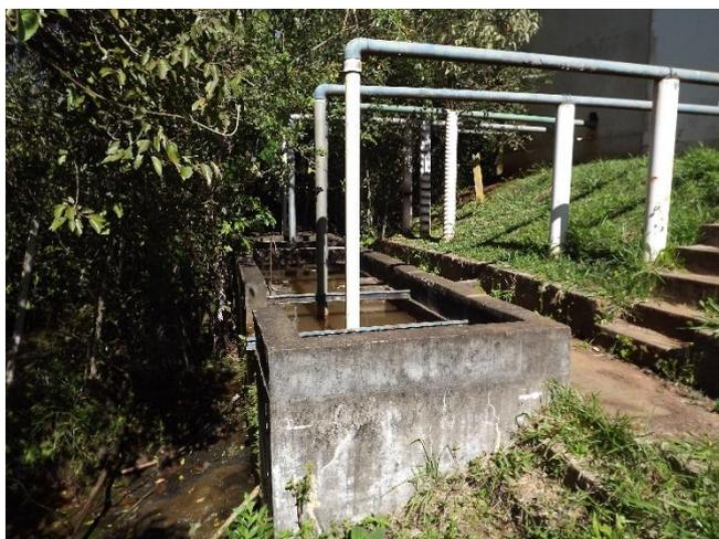
Foto 3.3 – Tubulações de recalque da captação para a casa de bombas.
