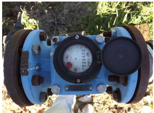
Foto 3.10 – Detalhe de macromedidor instalado no Poço Pinguela 2.
