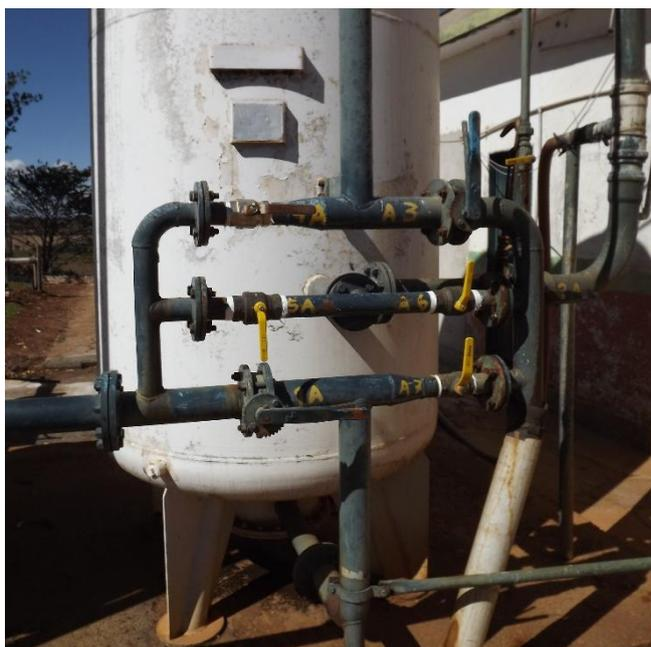
Foto 3.22 – Vista geral do sistema de retrolavagem de filtros.
