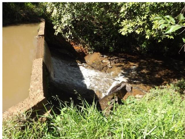
Foto 3.2 – Vista geral do vertedouro da barragem no Córrego das Pedras.
