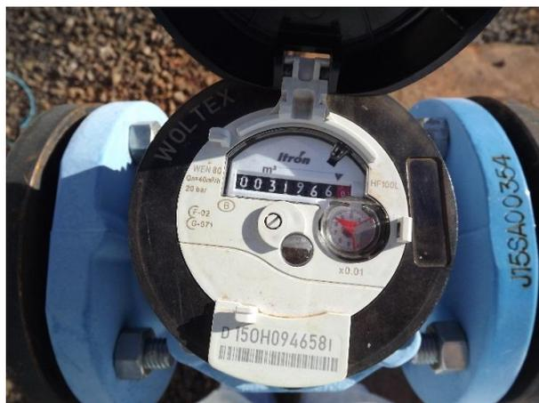
**Foto 3.17 – Detalhe de macromedidor instalado no Poço Aroeira.**
