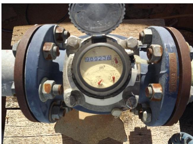
Foto 3.15 – Detalhe de macromedidor instalado no Poço Marumbé.
