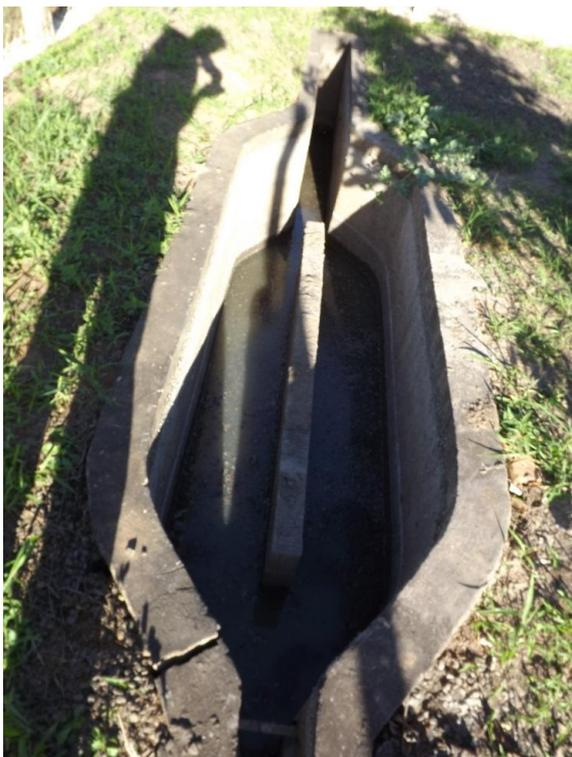
Foto 3.70 – Detalhe da caixa de areia com fissura na estrutura.
