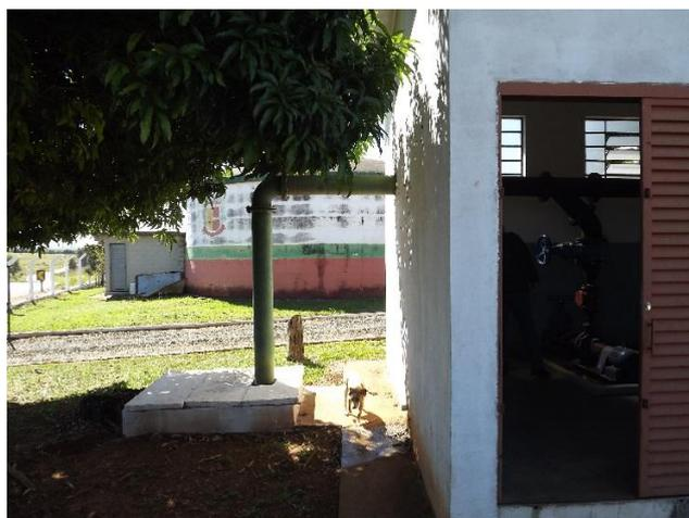
Foto 3.52– Detalhe da tubulação de recalque para o Centro de Reservação Planalto na saída do abrigo da EEAT ETA II.
