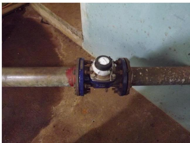
Foto 3.6 – Macromedidor instalado na tubulação de recalque da água bruta.
