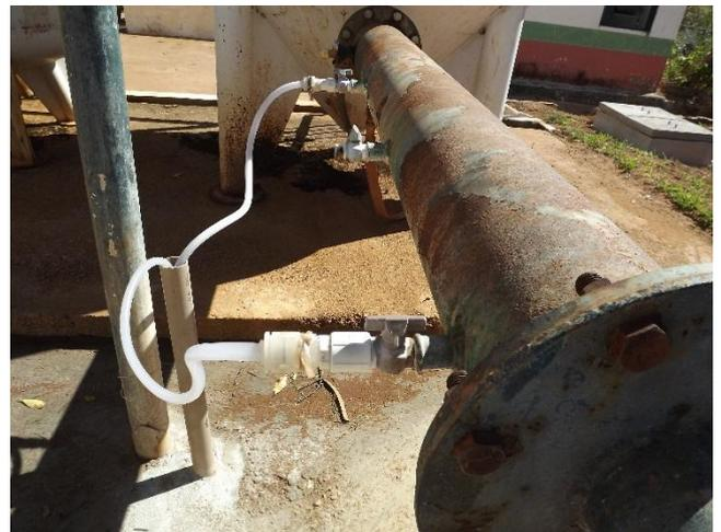
**Foto 3.19 – Ponto de aplicação de policloreto de alumínio (coagulante) na entrada da ETA.**
