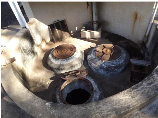
Foto 3.62 – Detalhe do poço de sucção da EEE Major Goulart.
