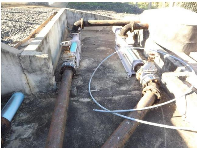
**Foto 3.80 – Detalhe da fiação aparente no conjuntos motobomba – furtada recentemente.**
