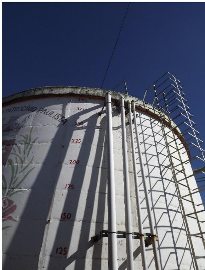
Foto 3.38 – Detalhe das tubulações de entrada e medidor de nível no RAP Pinguela.
