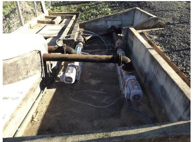
**Foto 3.79 – Detalhe dos conjuntos motobomba instalados.**
