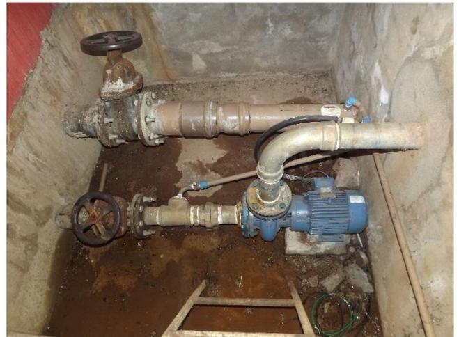
**Foto 3.57 – Detalhe do Booster Planalto.**
