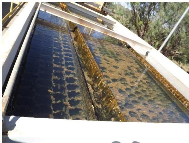
Foto 3.25 – Detalhe do decantador laminar ascendente de contato.
