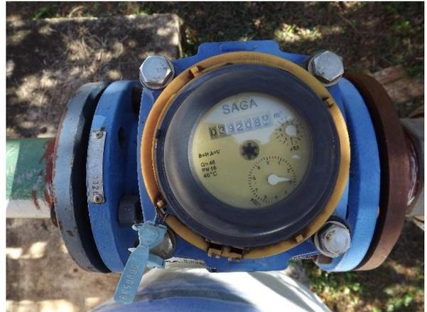
Foto 3.8 – Detalhe de macromedidor instalado no Poço Pinguela 1.
