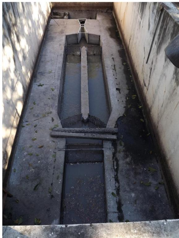
Foto 3.59 – Detalhe da caixa de areia e Calha Parshall da EEE Major Goulart.
