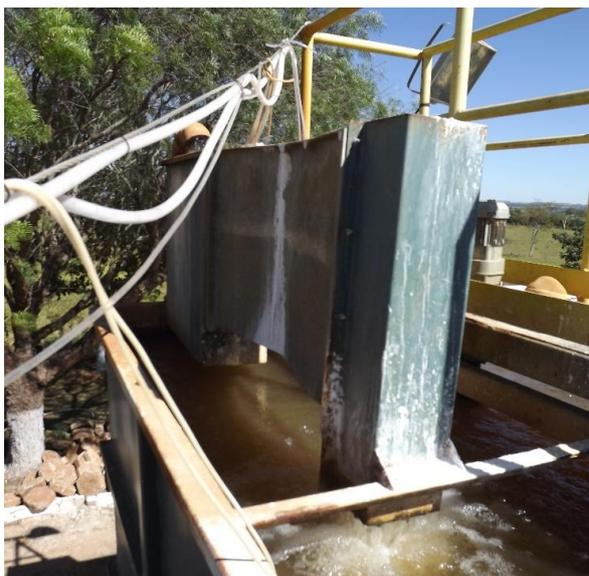
Foto 3.24 – Detalhe do flocculador mecanizado na ETA Compacta.
