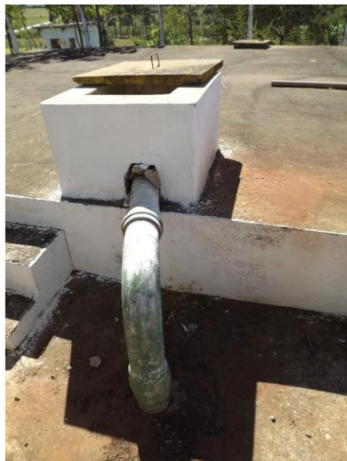
Foto 3.29– Detalhe de tubulação de entrada do RENT ETA.
