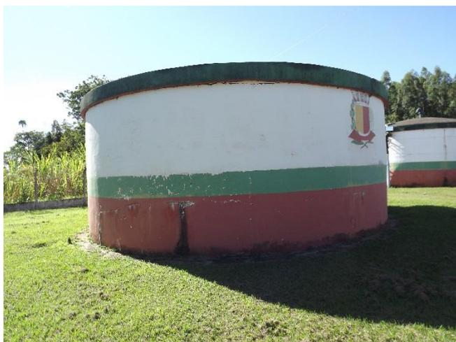
Foto 3.36 – Detalhe de vazamento no RAP Planalto 2.
