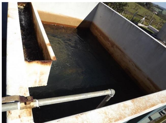
Foto 3.26 – Vista de um dos filtros da ETA Compacta.
