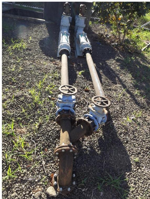
Foto 3.71 – Detalhe dos dois conjunto motobomba instalados.
