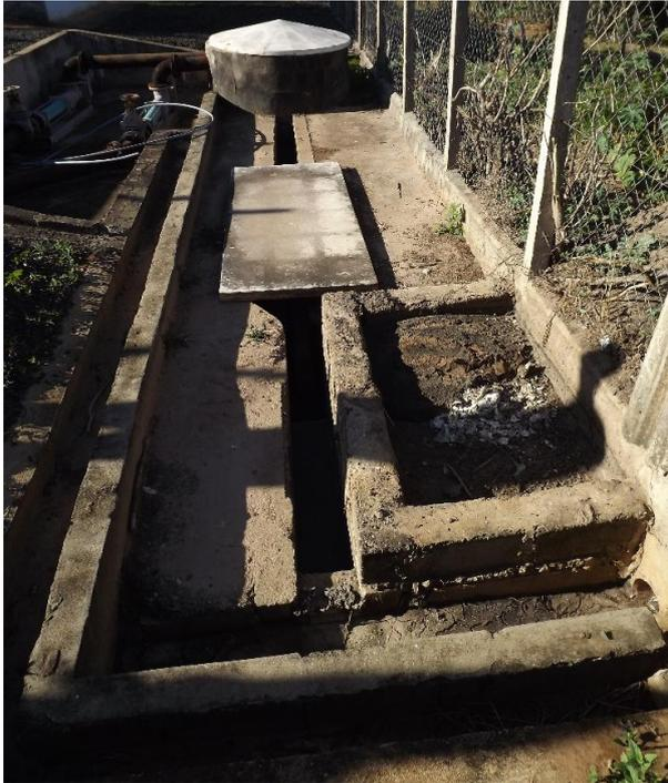
**Foto 3.78 – Vista geral do tratamento preliminar com poço de sucção ao fundo.**
