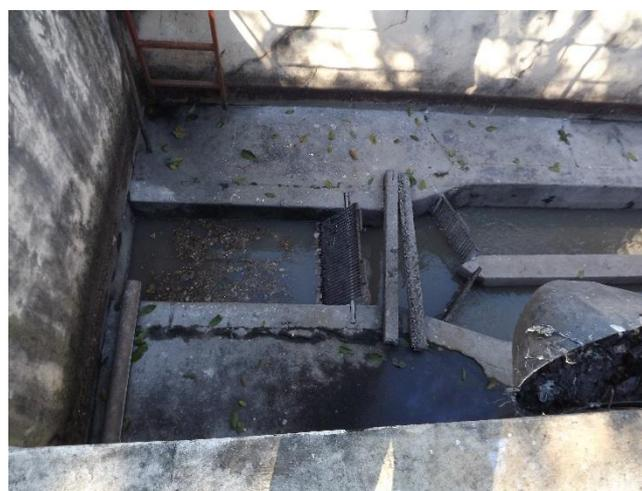
Foto 3.61 – Detalhe da entrada do esgoto bruto na caixa de areia da EEE Major Goulart.
