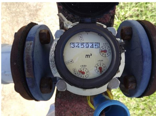
Foto 3.13 – Detalhe de macromedidor instalado no Poço Planalto.
