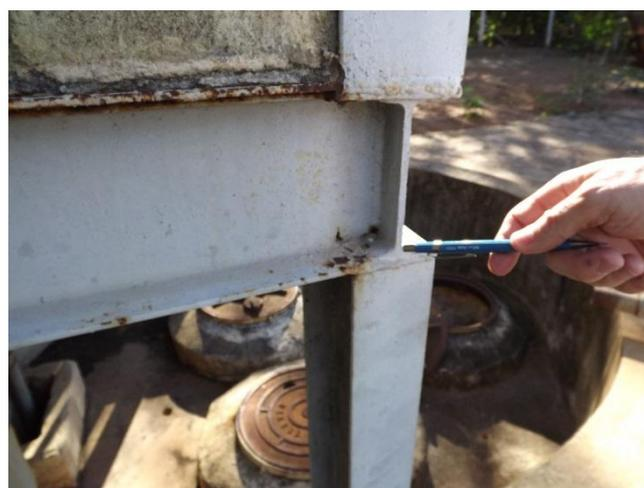
Foto 3.65 – Detalhe da corrosão na estrutura da casa de bombas
