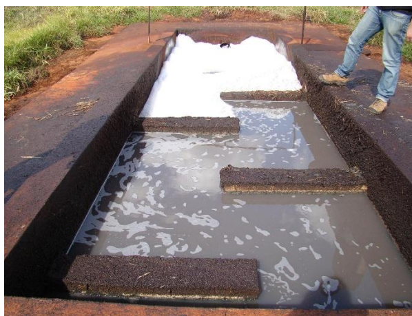
Foto 83. Etapa média do tratamento da água.
