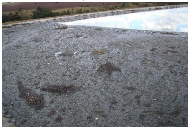
Foto 82. Resíduos do esgotamento sanitário.
