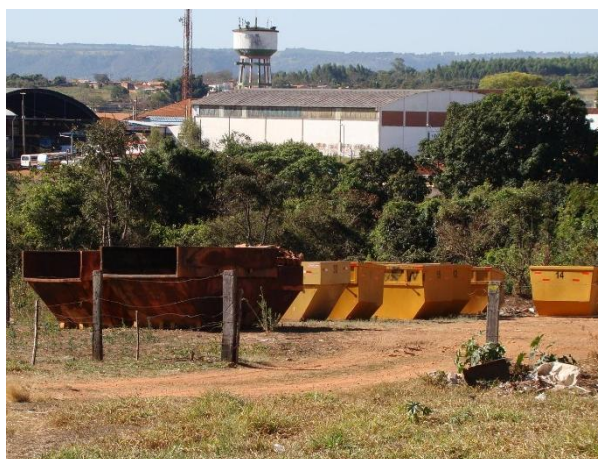
Foto 49. Caçambas dispostas em frente ao local atualmente utilizado como aterro de inertes.
