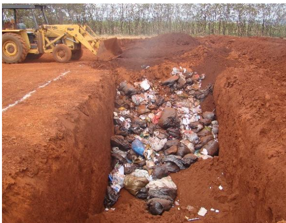
Foto 12. Resíduos comprimidos sendo cobertos por terra.
