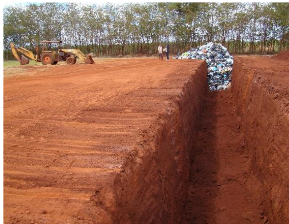
Foto 7. Vala em operação na data da visita (23/08/2013).
