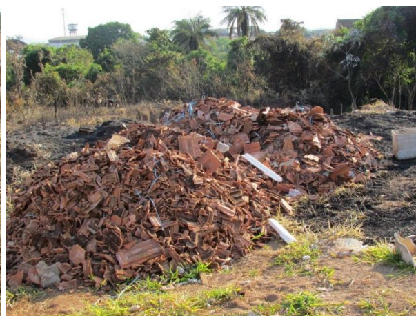
Foto 52. Inertes próximos ao aterro.
