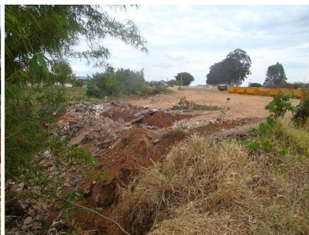
Foto 50. Visão geral do aterro de Inertes.
