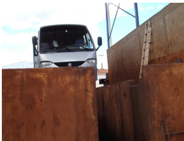
Foto 71. Rampa para lavagens de veículos da frota municipal.
