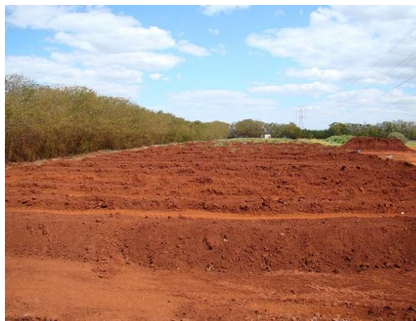
Foto 13. Valas finalizadas até a data da visita
