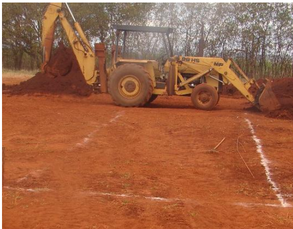
Foto 6. Área onde será furada a vala demarcada em branco.
