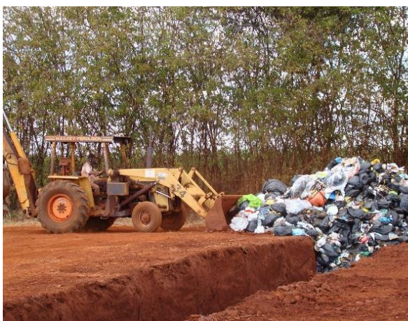
Foto 10. Retro escavadeira acomodando os resíduos dentro da vala.
