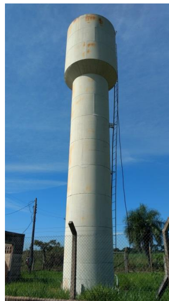
Foto 3.33 – Vista do reservatório RAP-11
