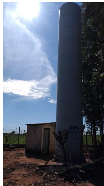
Foto 3.29 – Vista do reservatório RAP-07
