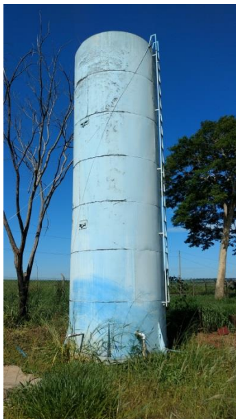
Foto 3.30 – Vista do reservatório RAP-08
