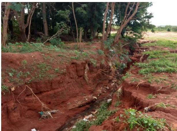
Foto 3.80 – Avenida Brasil (vista da vala que está sendo construída)
