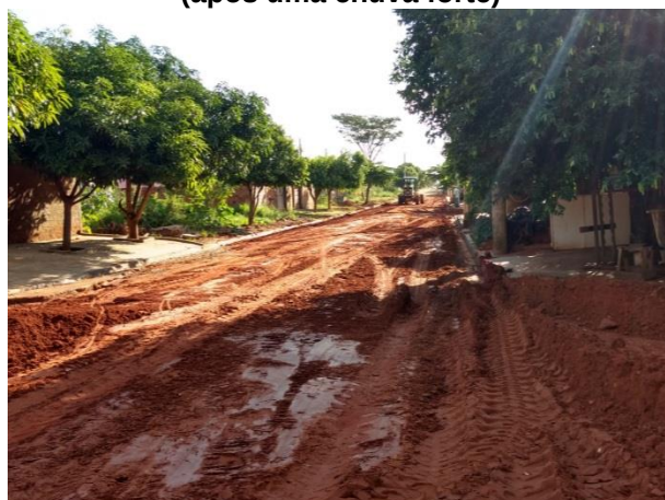
Foto 3.64 - Avenida Engenheiro Abraão Leite (local da obra)
