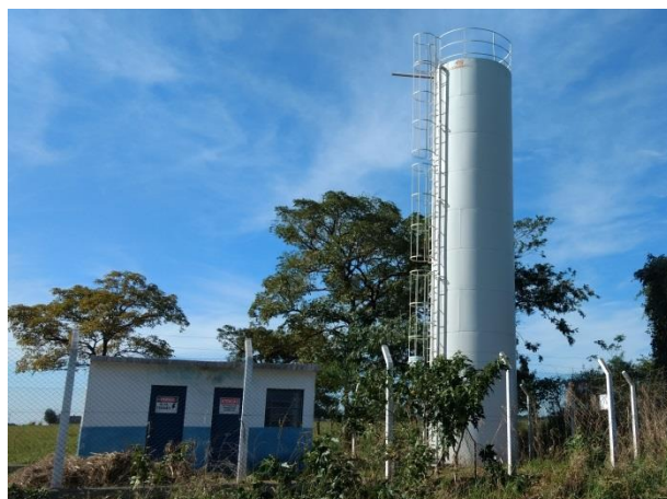
Foto 3.31 – Vista do reservatório RAP-09
