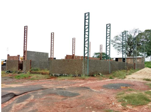
Foto 3.58 – Galpão de triagem
