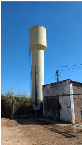
Foto 3.34 – Vista do reservatório RAP-12
