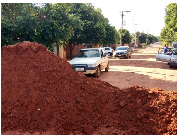
Foto 3.65 – Vista da Rua Padre Anchieta (local da obra)
