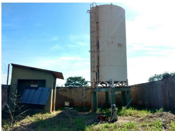
Foto 3.24 – Vista do reservatório REL-03
