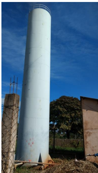
Foto 3.28 – Vista do reservatório RAP-06
