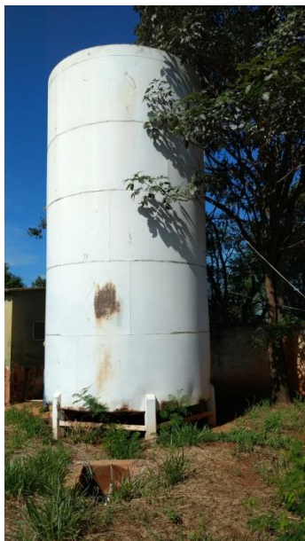
Foto 3.26 – Vista do reservatório RAP-05
