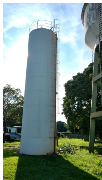
Foto 3.23 – Vista do reservatório RAP-02 (desativado)
