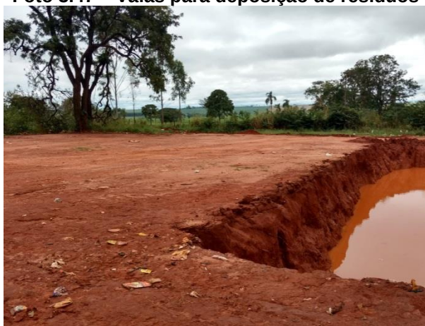
Foto 3.49 – Área para construção de valas
