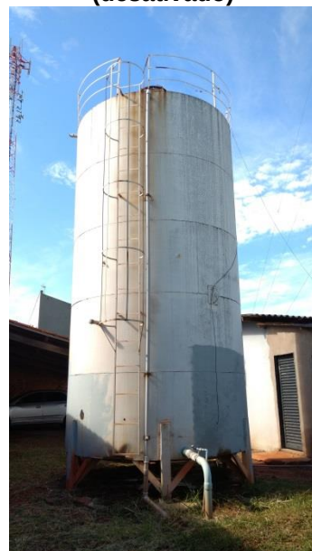
Foto 3.25 – Vista do reservatório RAP-04
