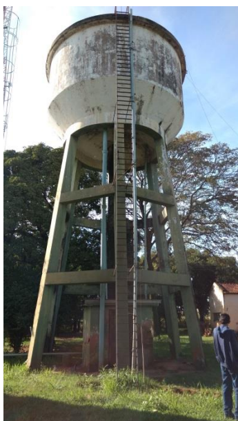
Foto 3.22 – Vista do reservatório REL-01
