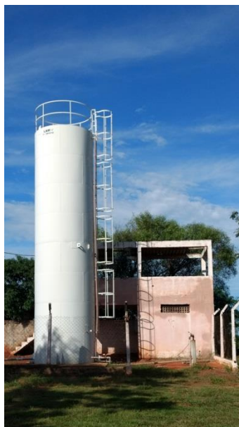
Foto 3.36 – Vista do reservatório RAP (desativado) ao lado do P08
