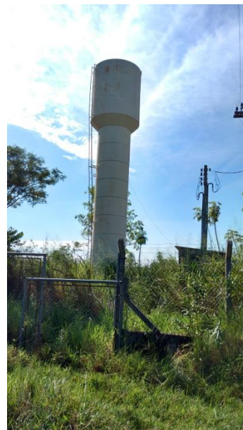
Foto 3.35 – Vista do reservatório RAP-13
