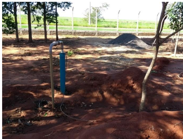
Foto 3.12 – Identificação do Poço: P11 (2)
