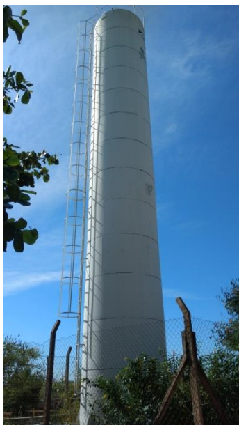
Foto 3.32 – Vista do reservatório RAP-10
