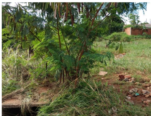
Foto 3.73 – Rua General Vargas (vista do loteamento que alaga)
