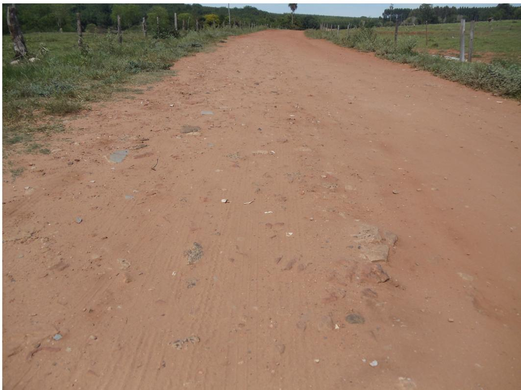
**FIGURA 08 – Resíduos de Construção Civil, usado na pavimentação do leito carroçável de estradas vicinais em Paulistânia - SP.**
