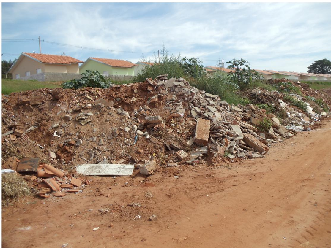
Figura 06 – Resíduos da Construção Civil depositado no Mini-Bolsão de Entulho nas dependências da Garagem Municipal.
