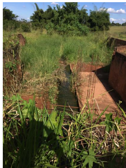
Foto 6.2 - Vista superior da escada hidráulica
