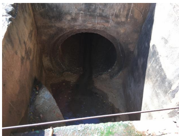
Foto 3.1 – Galeria no ponto mais baixo
