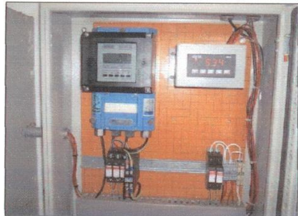
Foto 21 - Controle do tratamento e medição de vazão - Iguaçu
