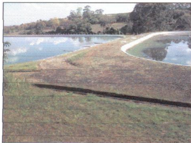
Foto 27- Lagoas de tratamento de esgoto anaeróbia e facultativa
