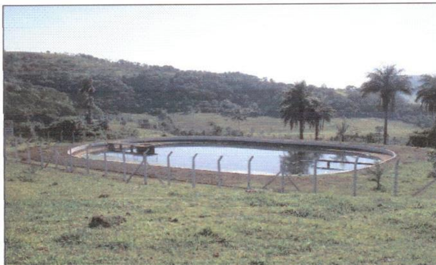
Foto 29 - Estação de tratamento de esgoto
