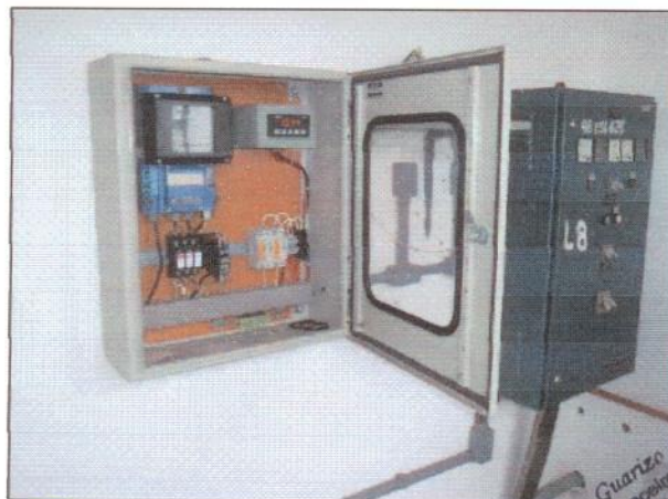
Foto 16 – Controle do tratamento e medição de vazão - Alto Porã
