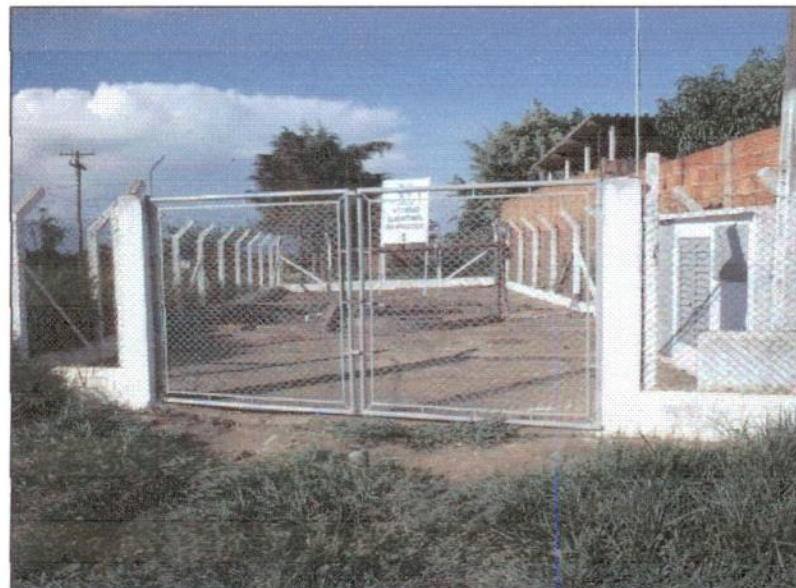
Foto 23 - Estação elevatória 01 (EEE 01)
