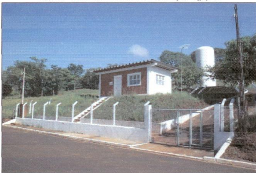
Foto 18 – Área do tratamento e Reservação - Igaçaba
