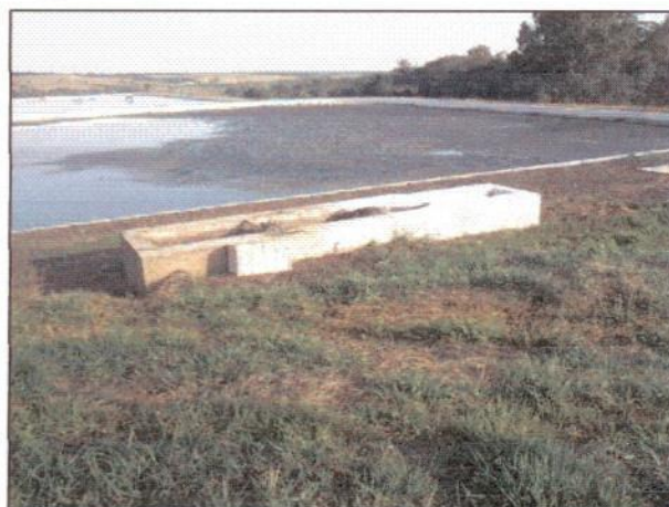
Foto 27- Lagoas de tratamento de esgoto anaeróbia e facultativa
