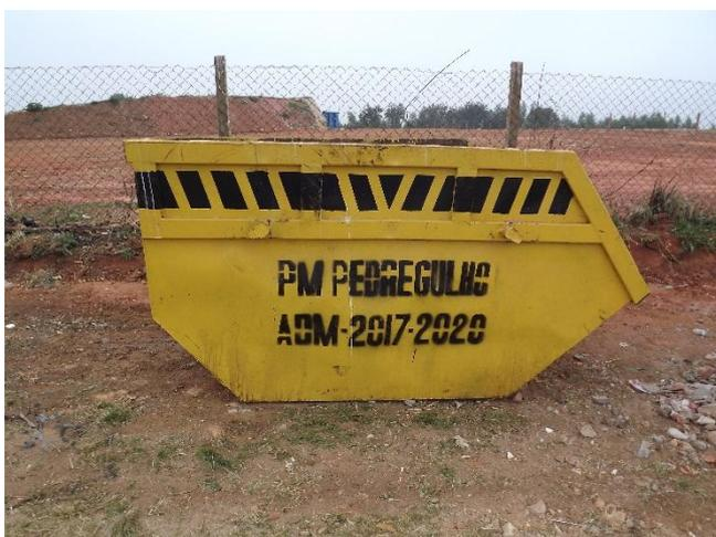
Foto 3.9 – Caçamba de acondicionamento de RCC
