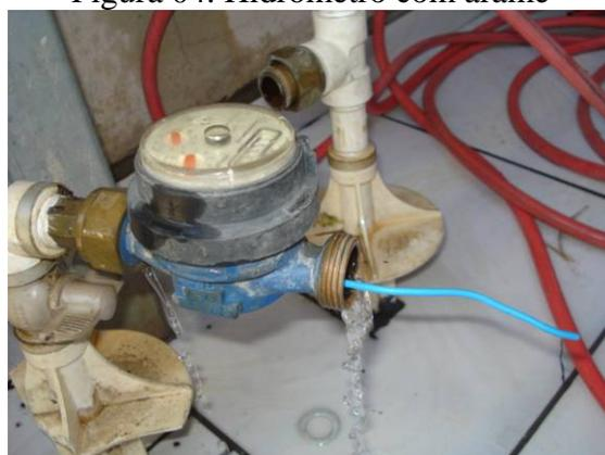
Figura 06. Hidrômetro com arame
