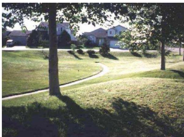
Figura 145. Reservatório de detenção gramado numa pequena área, durante a seca
