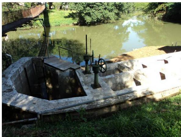
Figura 17. Vista da tomada de água do rio Jaguarí para captação de água bruta
