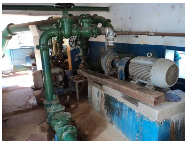
Figura 21. Conjunto motor-bomba de 100 cv existente na captação de água bruta
