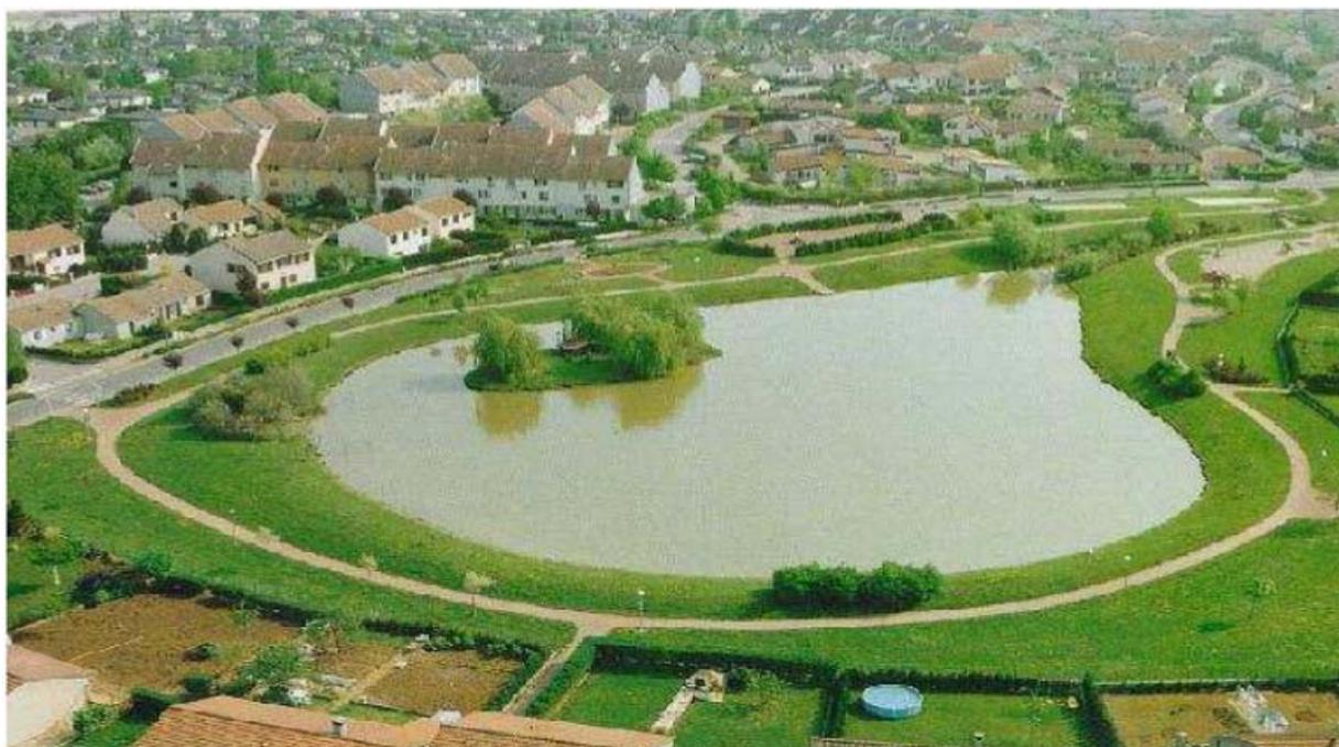
Figura 138. Bacia de detenção alagada com volume de espera para controle de enchente e áreas de recreação e lazer
