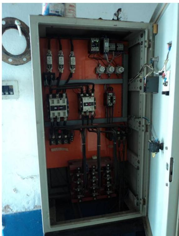
Figura 26. Vista do painel elétrico de um conjunto motor-bomba da captação de água bruta
