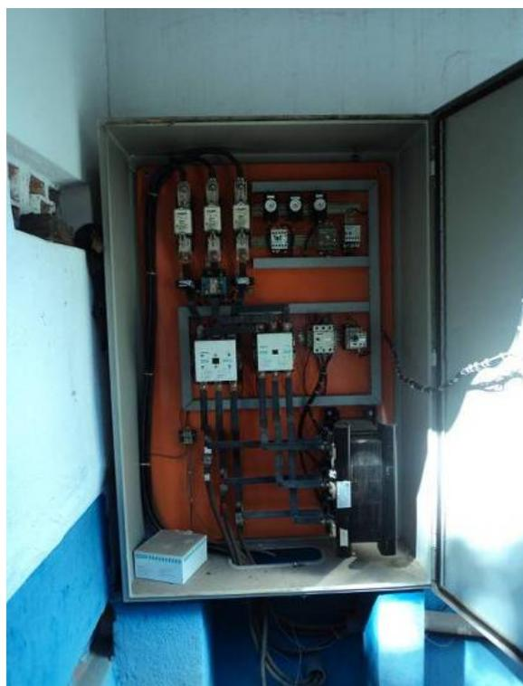
Figura 24. Vista do painel elétrico de um conjunto motor-bomba da captação de água bruta
