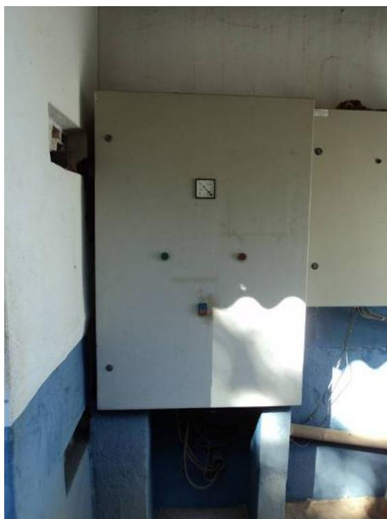
Figura 25. Vista do painel elétrico de um conjunto motor-bomba da captação de água bruta
