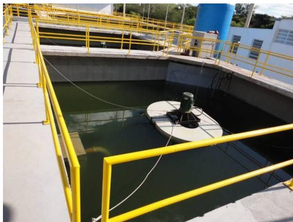
Figura 97. Vista de um módulo do Tanque de adensamento
