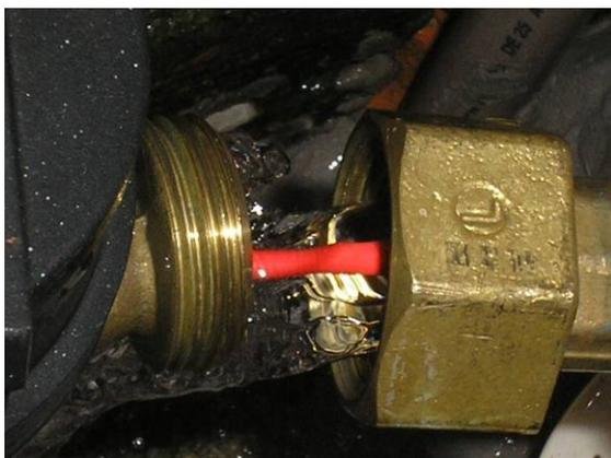
Figura 03. Hidrômetro com arame
