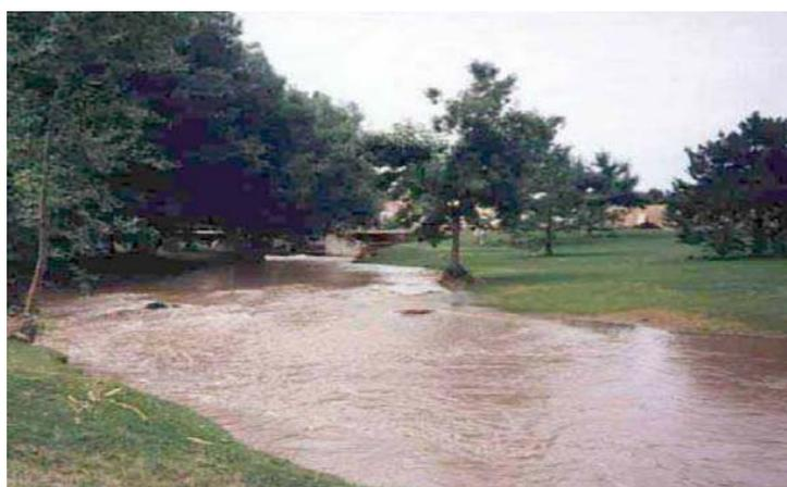
Figura 146. Reservatório de detenção gramado numa pequena área, durante a cheia
