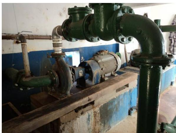
Figura 20. Conjunto motor-bomba de 100 cv existente na captação de água bruta
