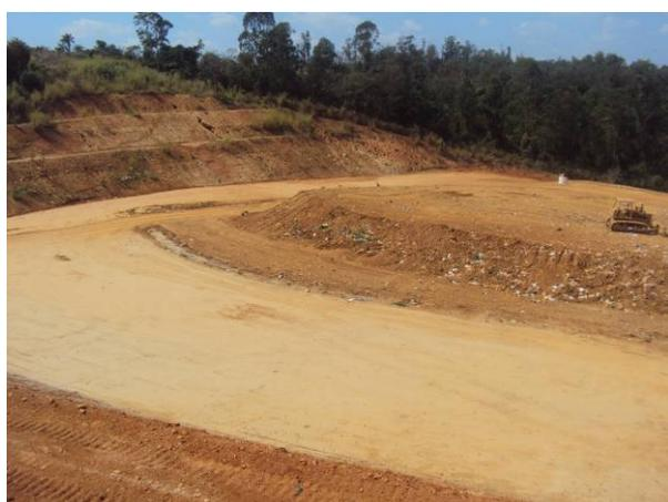
Figura 172. Cobrimento das valas.
