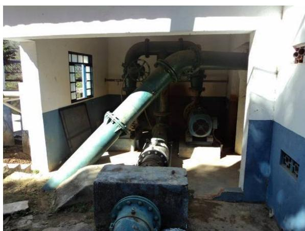
Figura 18. Conjunto motor-bomba de 100 cv existente na captação de água bruta (o conjunto motor-bomba reserva está em manutenção)
