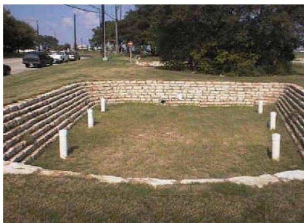
Figura 144. Reservatório de detenção para atendimento de uma pequena área
