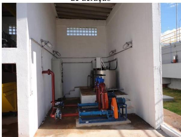
Figura 100. Vista da elevatória com conjuntos motor-bomba para recirculação do lodo
