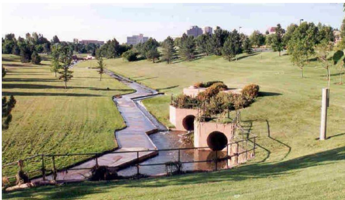
Figura 139. Reservatório de detenção seca construída no Wallace Park, Denver-USA, utilizado para controle de enchentes, e recreação no período seco
