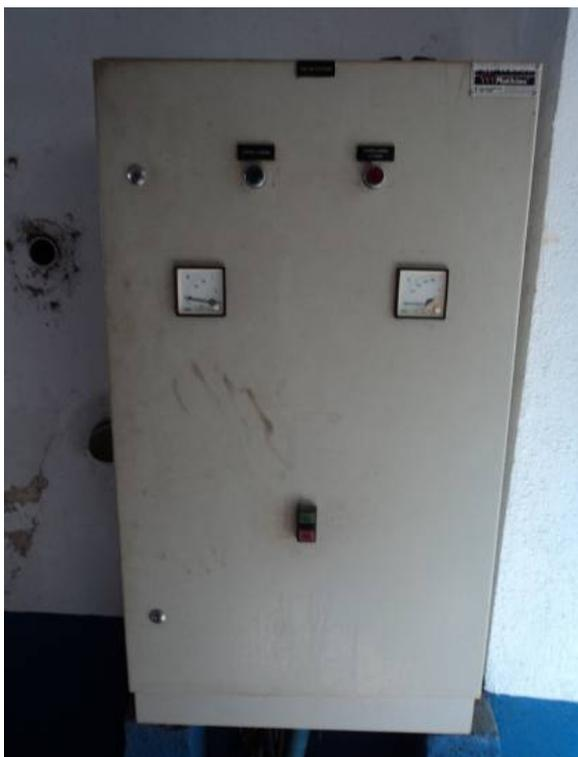
Figura 22. Painel elétrico de um conjunto motor-bomba da captação de água bruta
