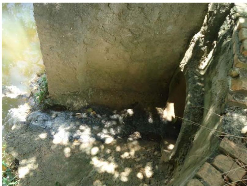
Figura 124. Galeria pluvial com esgoto sanitário sendo lançado irregularmente.
