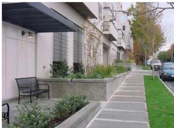
Figura 142. Plano de infiltração constituído por uma faixa de grama na Calçada
