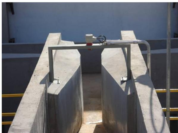
Figura 94. Vista da Calha Parshal com medidor ultrassônico de vazão
