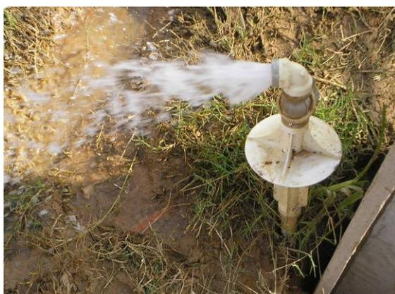
Figura 01. Cavalete sem hidrômetro
