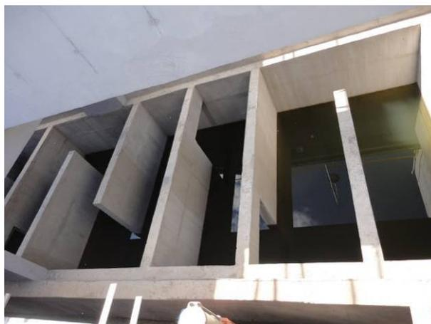
Figura 103. Vista da câmara de contato para desinfecção
