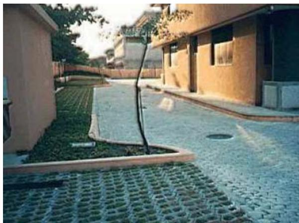
Figura 143. Pavimentação com blocos vazados para favorecer a infiltração
