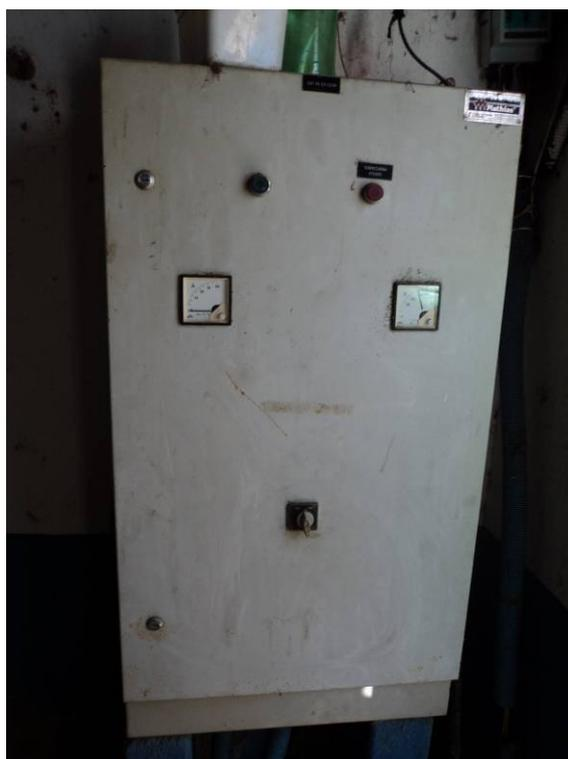
Figura 27. Vista do painel elétrico de um conjunto motor-bomba da captação de água bruta
