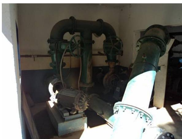
Figura 19. Conjunto motor-bomba de 100 cv existente na captação de água bruta (o conjunto motor-bomba reserva está em manutenção)
