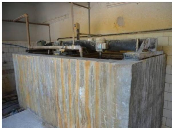
Figura 86. Tanque de preparo do Sulfato de Alumínio
