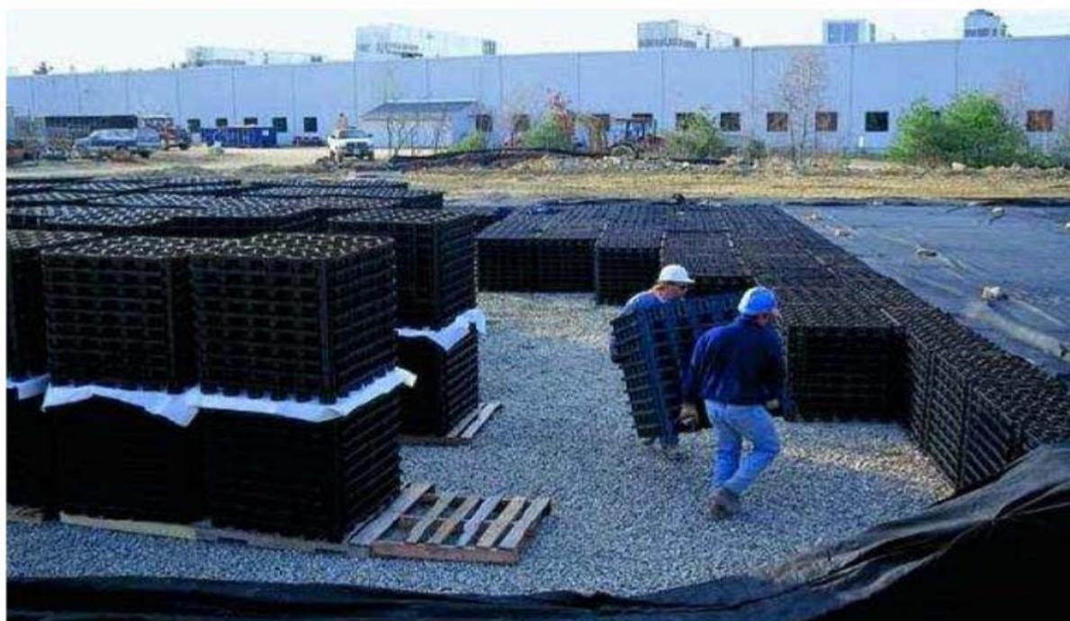
Figura 140. Reservatório de detenção enterrado
