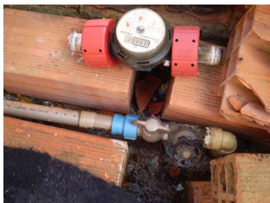
Figura 02. Cavalete sem Hidrômetro
