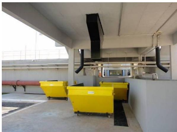
Figura 99. Vista das caçambas para o transporte do lodo desidratado
