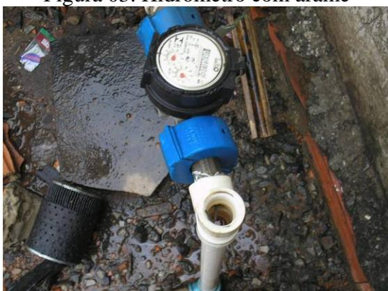
Figura 05. Hidrômetro com arame
