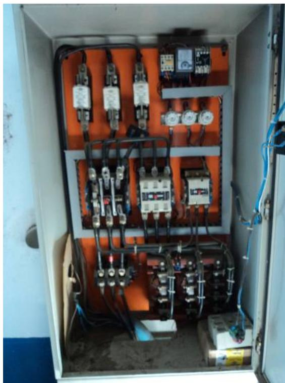
Figura 23. Painel elétrico de um conjunto motor-bomba da captação de água bruta
