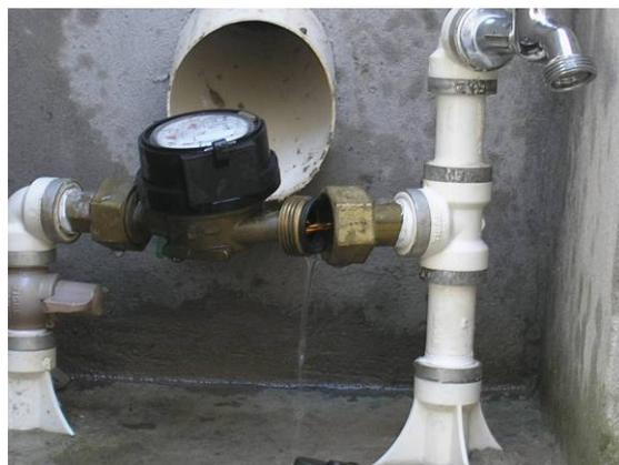
Figura 04. Hidrômetro com arame
