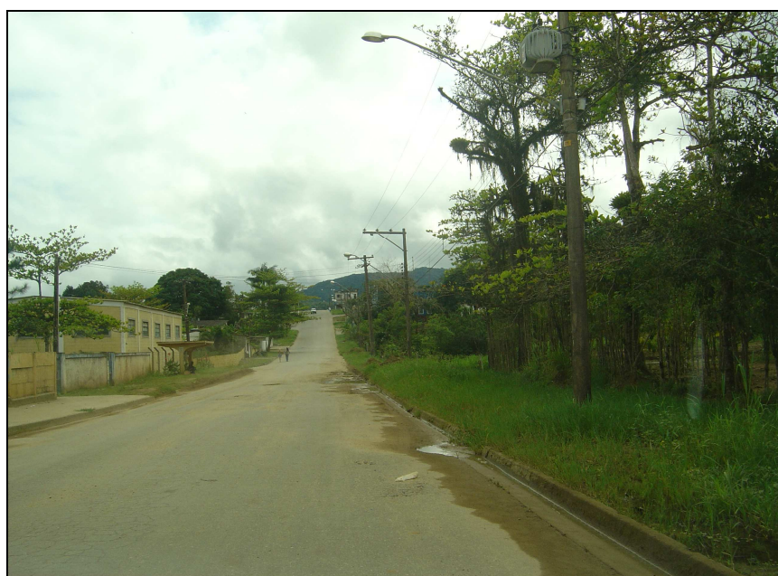
Foto 1 – Inexistência de Bocas de Lobo e Galerias
