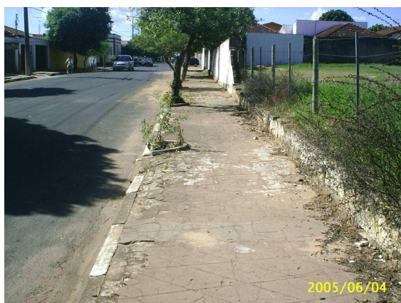
Calçada com mato após a aplicação do produto herbicida – fica um aspecto muito ruim pelo material ficar sem a devida remoção (capinação manual)
