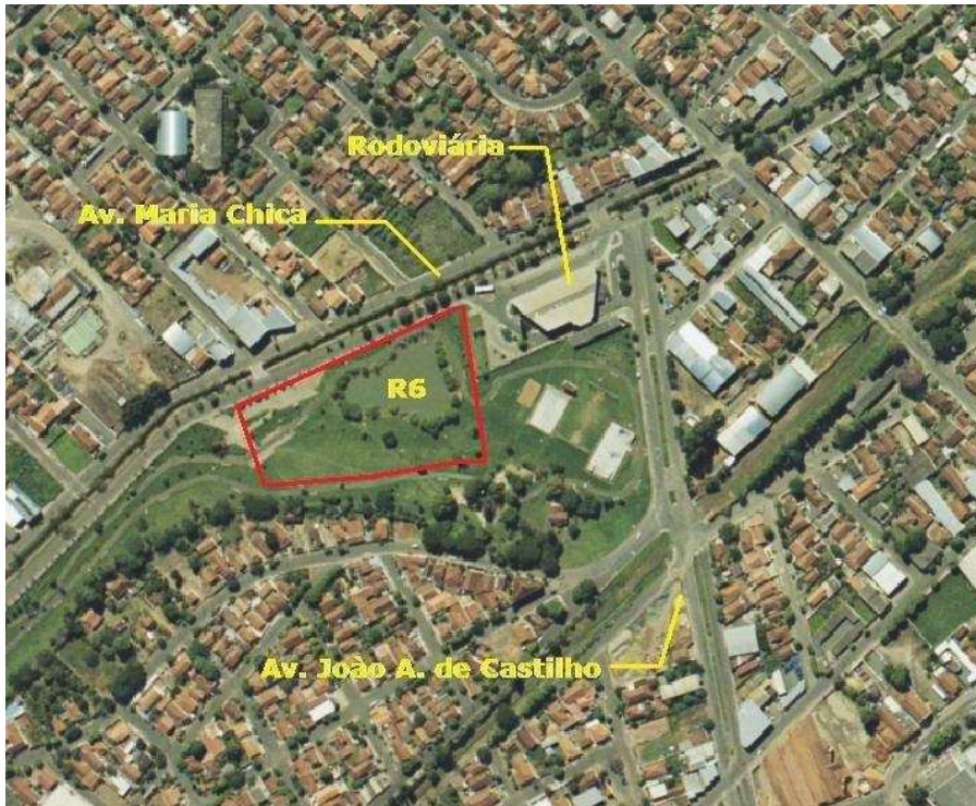
Figura 7. Reservatório (R6) existente na sub-bacia B.
