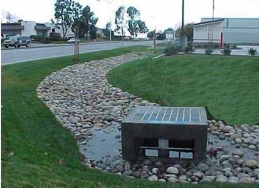
Figura 21. Trincheira de infiltração ao longo da rua.
