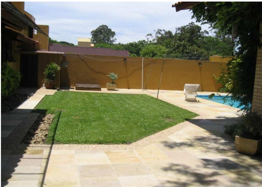
Figura 24. Trincheira de infiltração num lote residencial.
