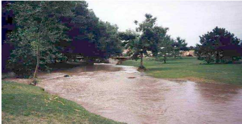
Figura 23b. Reservatório de detenção gramado numa pequena área, durante a cheia.
