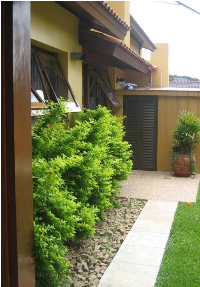
Figura 25. Trincheira de infiltração num lote residencial.
