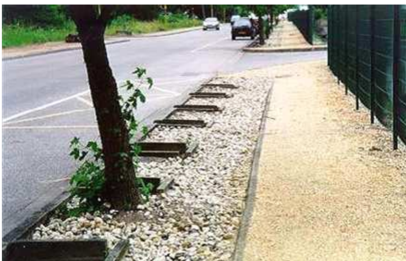
Figura 20. Trincheira de infiltração ao longo da rua.
