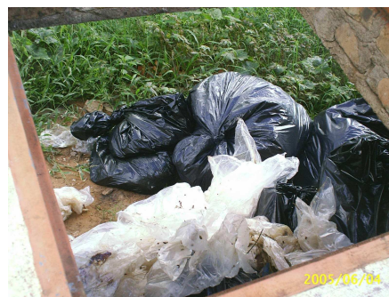
Abrigo para acondicionamento de resíduo comum gerado em Unidade Hospitalar - impossibilidade da equipe retirar o resíduo devido ao tipo de construção
