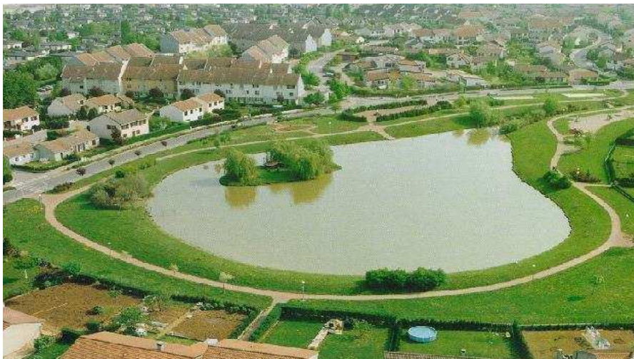
Figura 12. Bacia de detenção alagada com volume de espera para controle de enchente e áreas de recreação e lazer.
