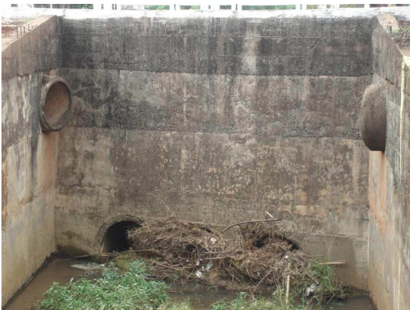
Figura 16. Fotografia da seção de controle S8, vista desde montante.
