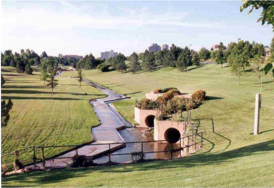
Figura 13. Reservatório de detenção seca construído no Wallace Park, Denver-USA, utilizado para controle de enchente, e recreação no período seco.
