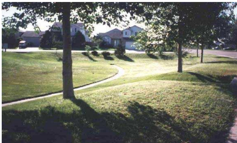
Figura 23a. Reservatório de detenção gramado numa pequena área, durante a seca.
