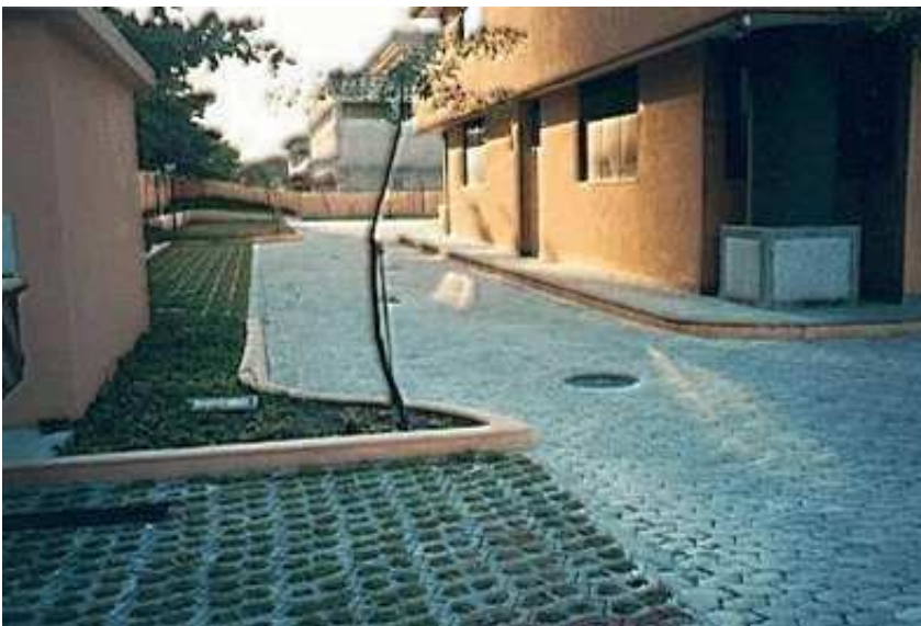
Figura 28. Pavimentação com blocos vazados para favorecer a infiltração.
