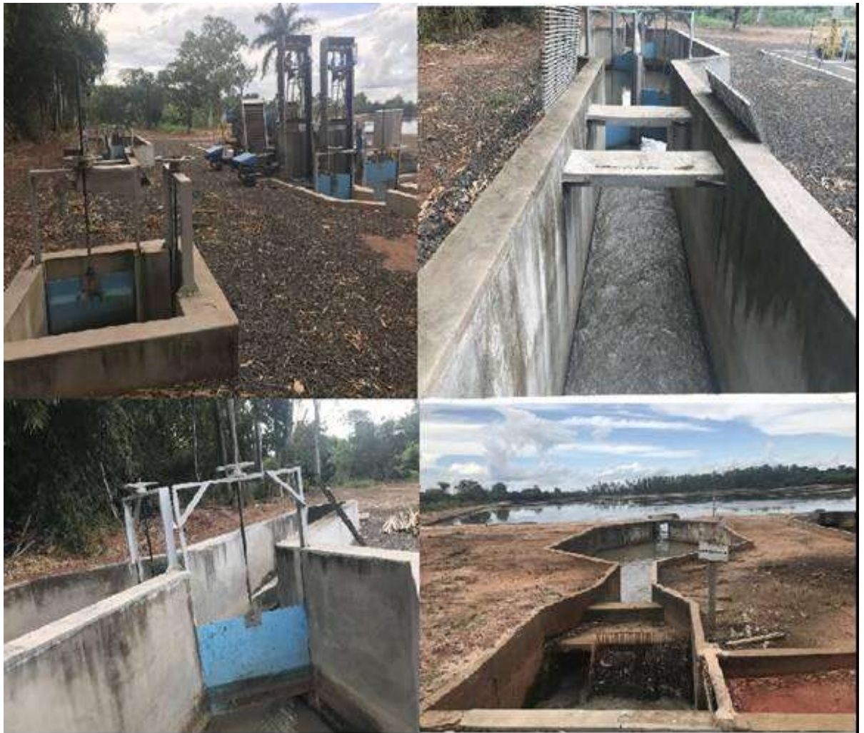
Figura 53 - Tratamento preliminar manual
