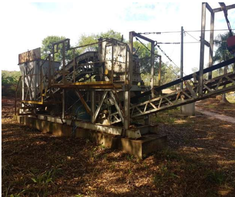
Figura 75 - Usina de processamento de RCC
