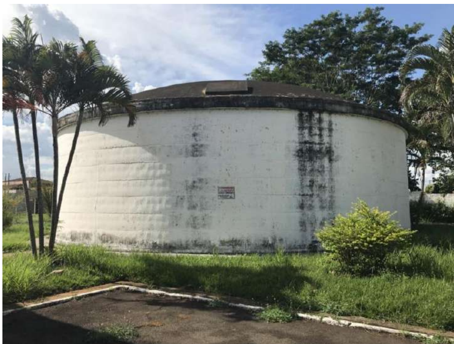
Figura 41 - Reservatório semi enterrado do Jd. Pevi – 1.000 m
