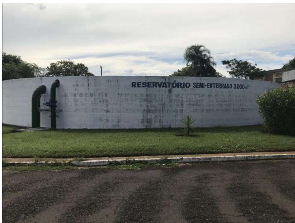
Figura 43 - Reservatório semi enterrado do Eldorado – 3.000 m 3
