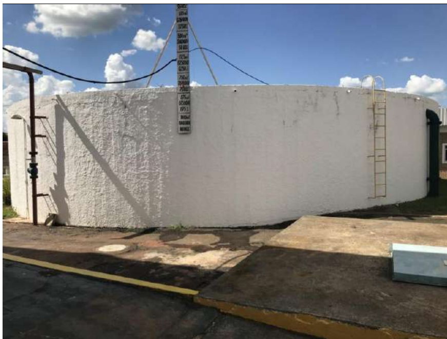
Figura 39 - Reservatório semi enterrado na sede – 1.000 m 3
