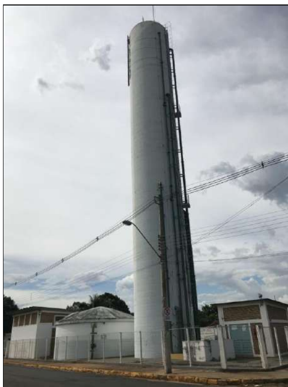
Figura 44 - Reservatório elevado do Jd. Toquio – 500 m 3
