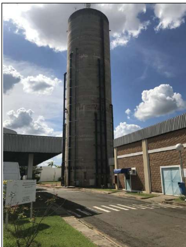
Figura 38 - Reservatório elevado na sede – 1.200 m 3
