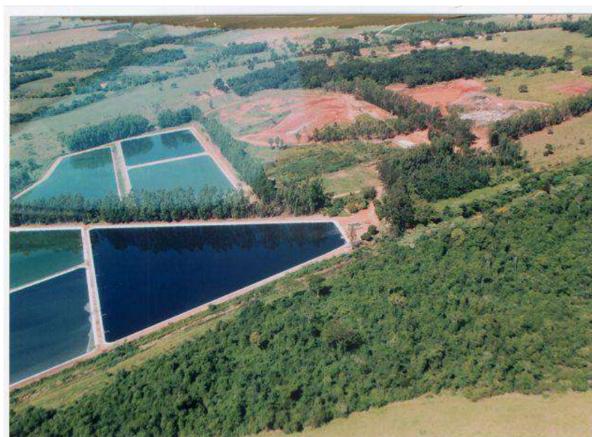
Figura 17 - Lagoas de Tratamento de Esgotos e Aterro Sanitário
