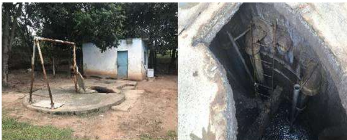
Figura 52 - Estação Elevatória de Esgotos Pevi
