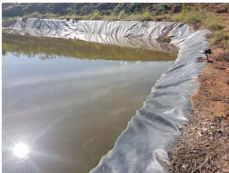
Figura 69 - Lagoa de captação do chorume gerado pelo aterro
