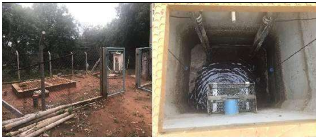
Figura 51 - Estação Elevatória de Esgotos Matadouro
