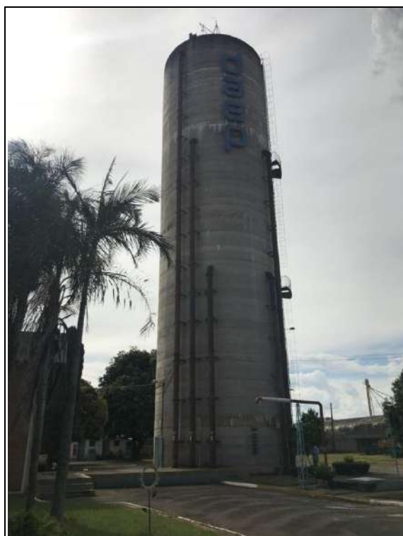
Figura 42 - Reservatório elevado do Eldorado – 1.200 m 3
