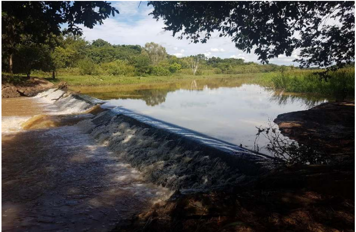
Figura 23 - Barramento na captação do Ribeirão Lajeado
