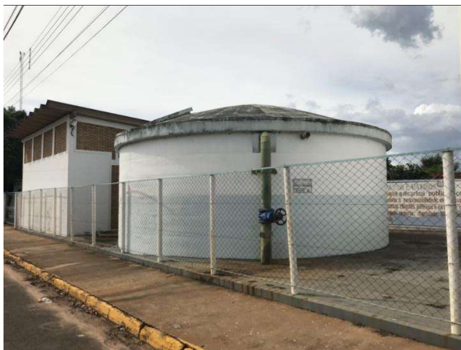
Figura 45 - Reservatório elevado do Jd. Toquio – 250 m 3
