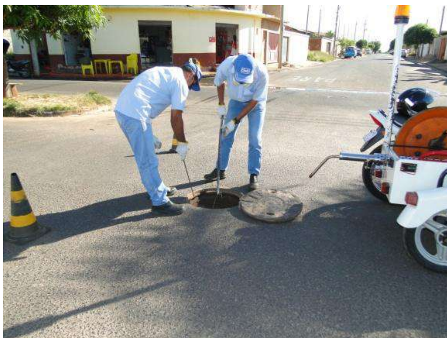
Figura 14 - Limpeza dos Poços de Visita
