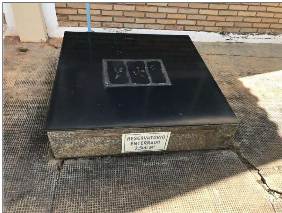
Figura 37 - Reservatório enterrado na sede – 3.500 m 3
