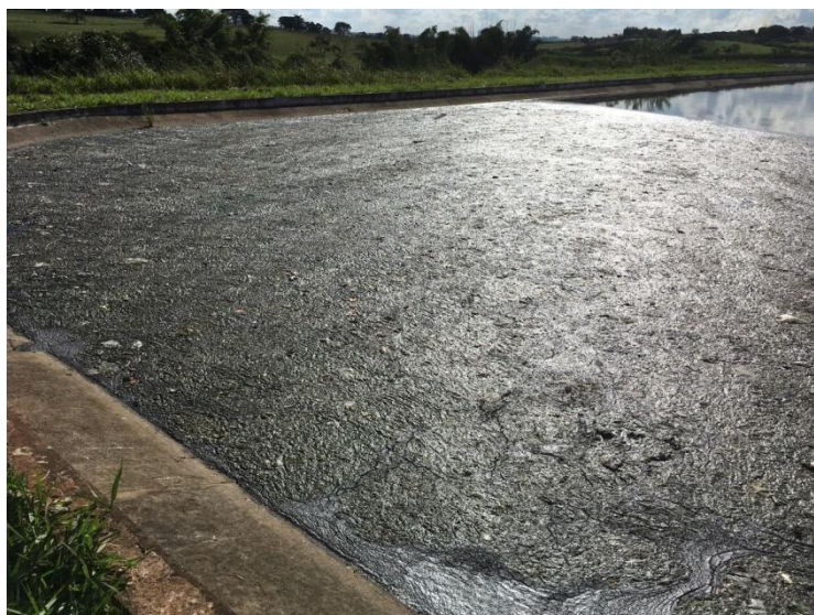
Foto 6.3 – Vista da presença de sobrenadante na superfície líquida da lagoa anaeróbia
