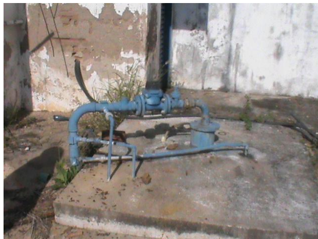
Foto 3.10 - Identificação do Poço 11
