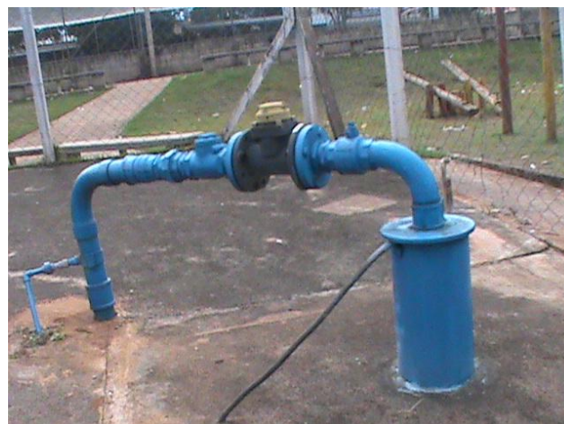
Foto 3.6 - Identificação do Poço 7
