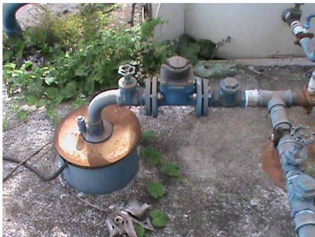
Foto 3.9 - Identificação do Poço 10
