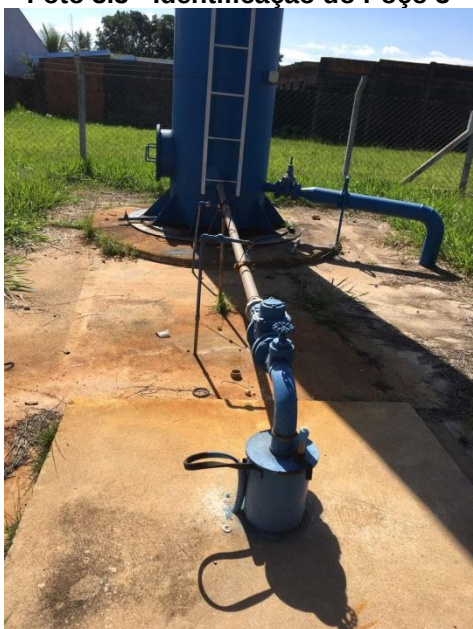
Foto 3.5 - Identificação do Poço 6
