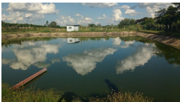
Foto 3.60 – Vista da Lagoa Facultativa
