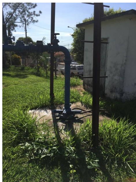
Foto 3.2 - Identificação do Poço 2
