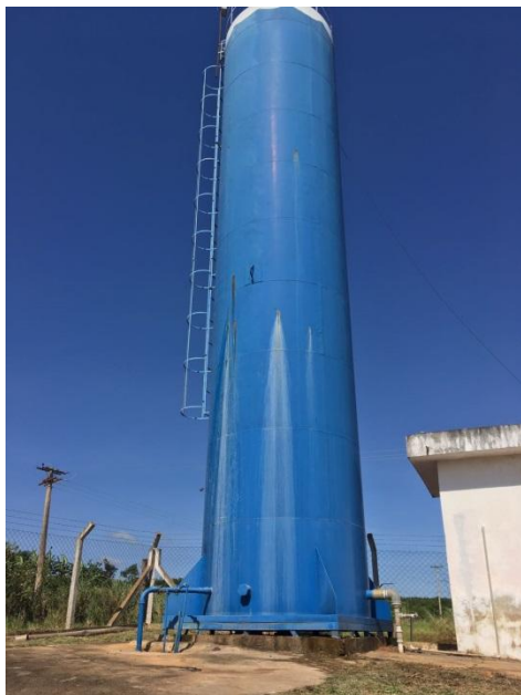
Foto 3.38 - Identificação do Reservatório 14
