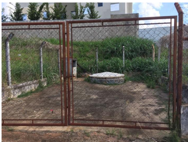
Foto 3.43 – Vista geral das unidades
