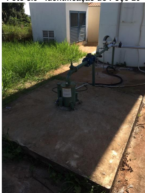
Foto 3.11 - Identificação do Poço 17
