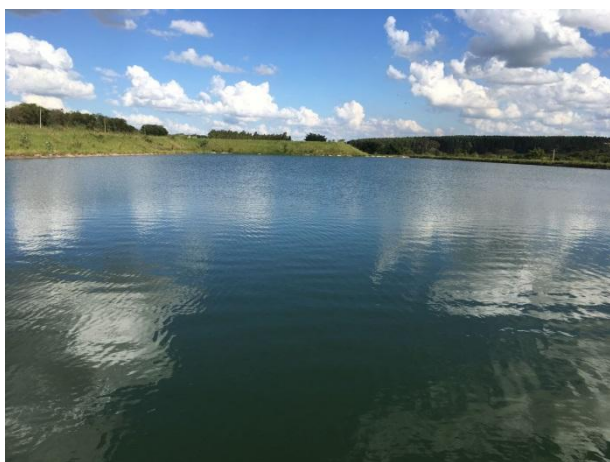
Foto 3.57 – Vista da Lagoa de Maturação
