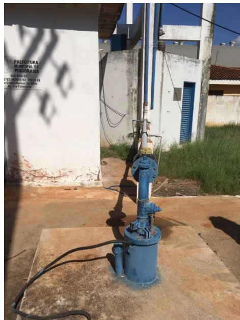
Foto 3.4 - Identificação do Poço 5
