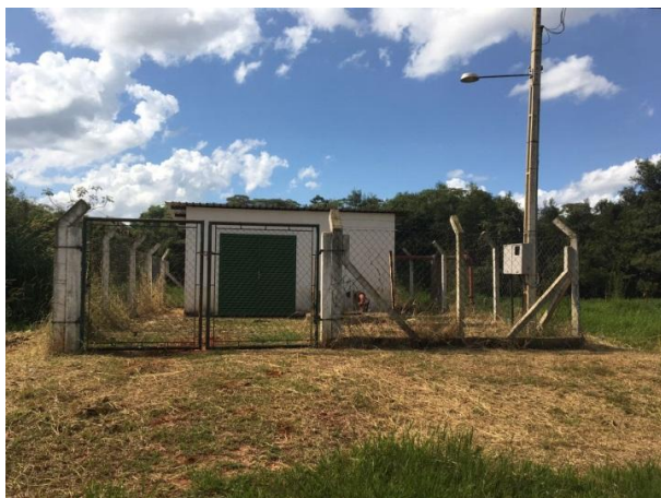
Foto 3.39 – Vista geral das unidades
