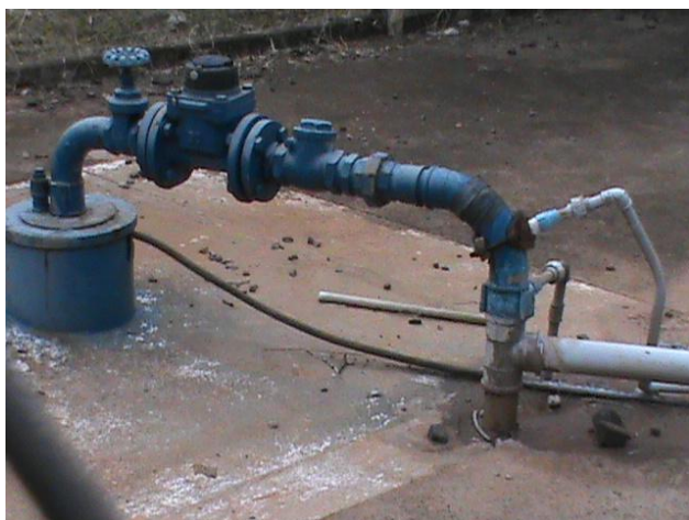
Foto 3.13 - Identificação do Poço 14
