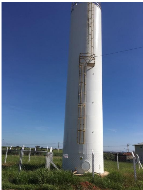
Foto 3.32 - Identificação do Reservatório 7
