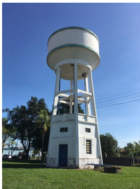
Foto 3.27 - Identificação do Reservatório 2
