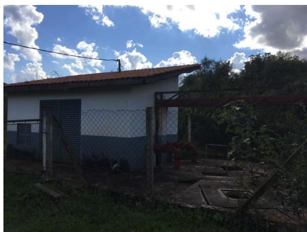
Foto 3.49 – Vista geral das unidades
