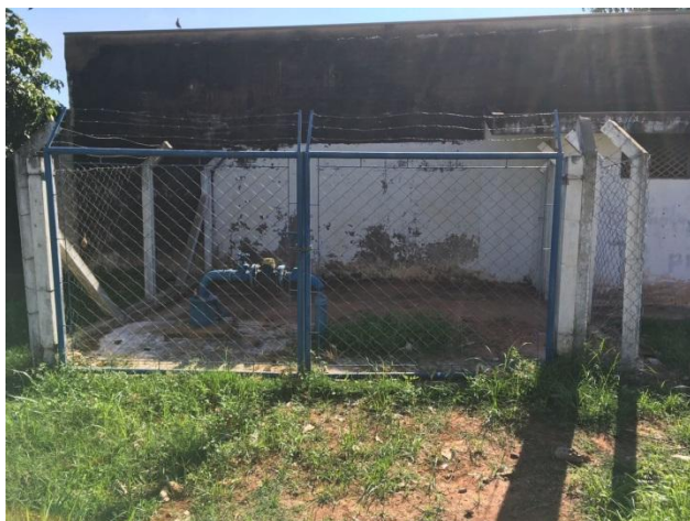
Foto 3.3 - Identificação do Poço 3
