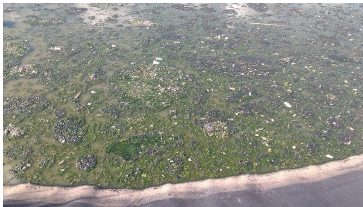
Foto 6.4 – Vista da presença de sobre-nadante e placas de lodo desprendido do fundo na superfície líquida da lagoa anaeróbia
