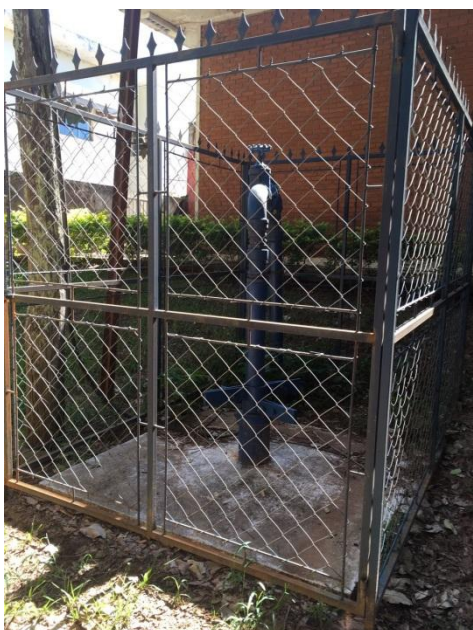
Foto 3.1 - Identificação do Poço 1
