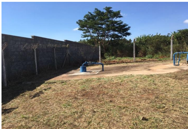
Foto 3.15 - Identificação do Poço 16
