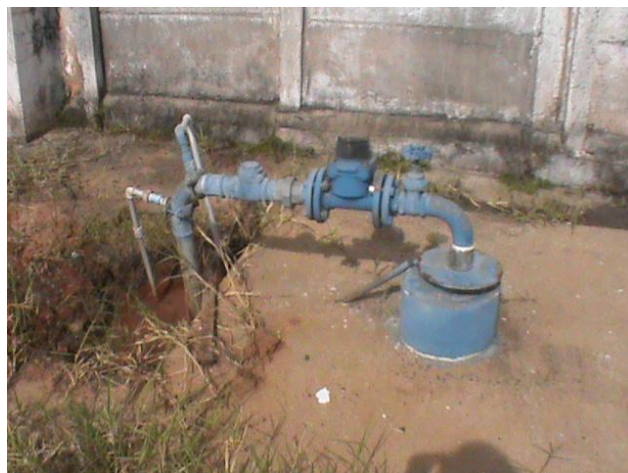
Foto 3.12 - Identificação do Poço 13
