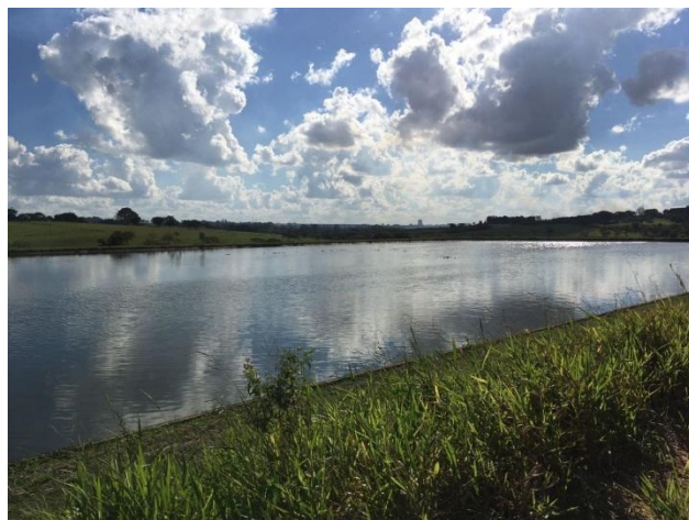
Foto 3.56 – Vista da Lagoa Facultativa
