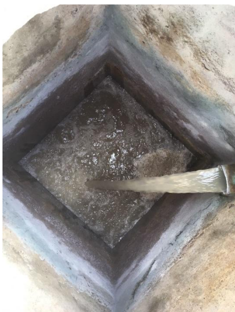
Foto 3.48 – Vista da caixa de chegada de esgoto
