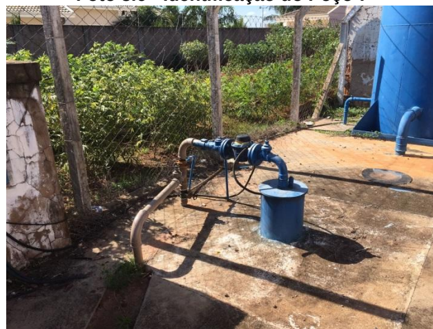
Foto 3.8 - Identificação do Poço 9
