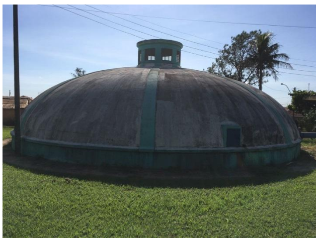
Foto 3.26 - Identificação do Reservatório 1
