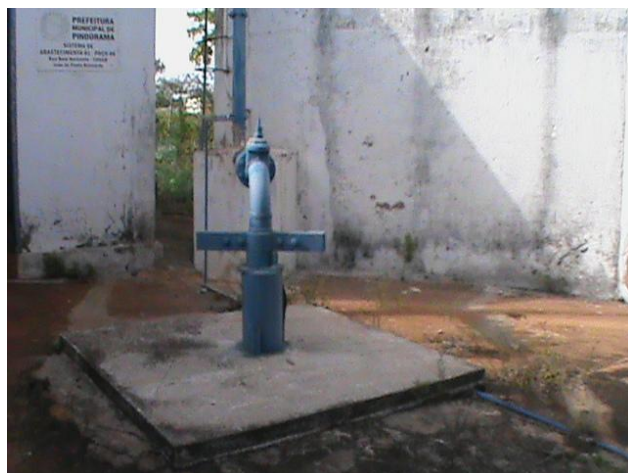
Foto 3.14 - Identificação do Poço 15
