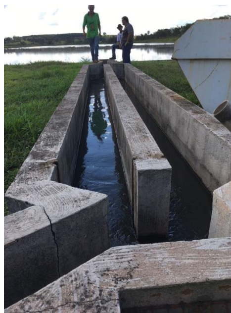
Foto 3.54 – Vista do desarenador
