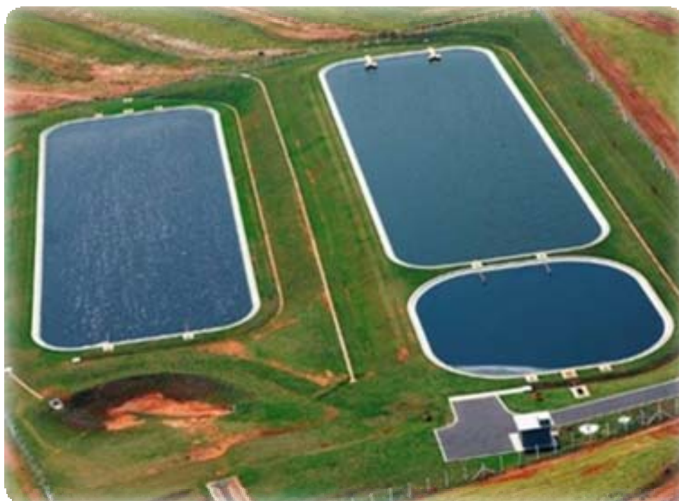
Fig. 08. Lagoas de tratamento de efluentes no município
