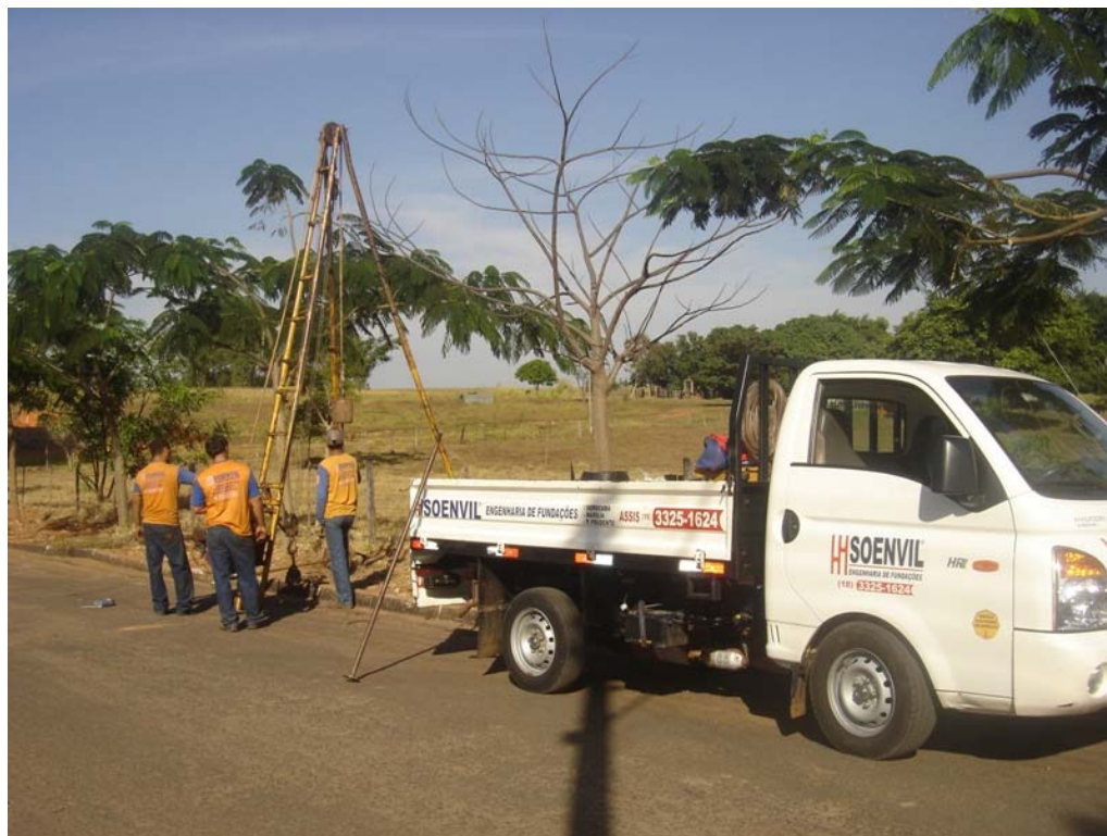
Sondagem Ponto S2
