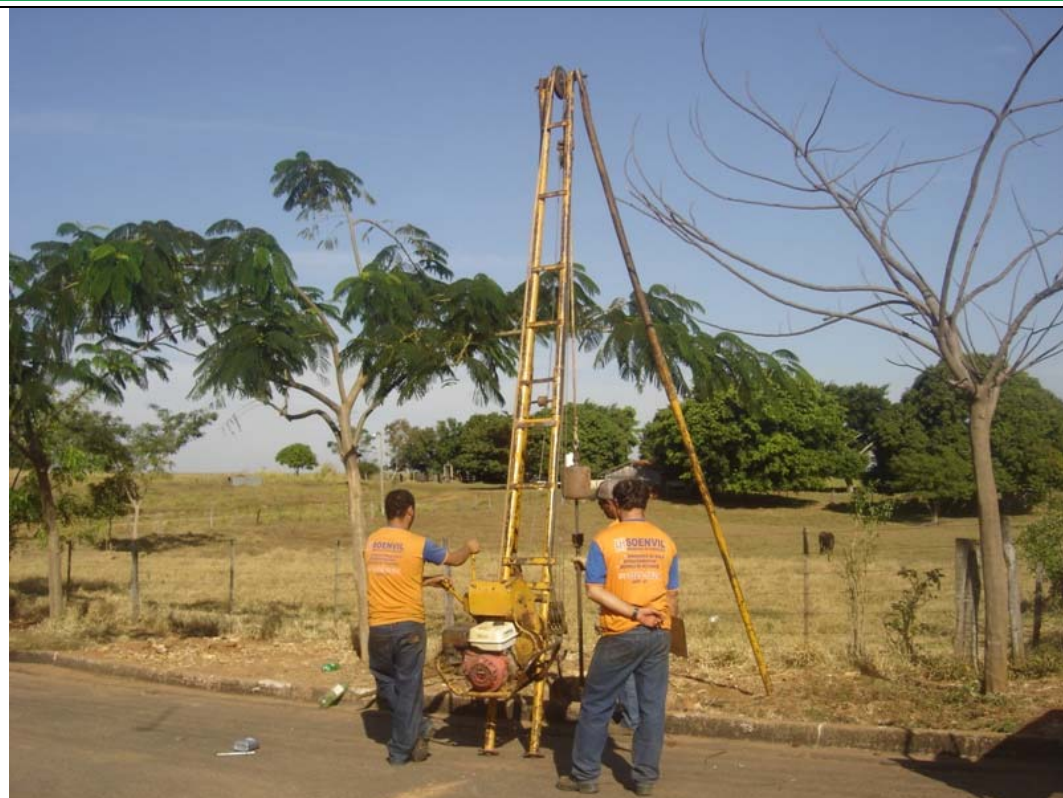
Fig. 05. Ponto de Sondagem - S1
