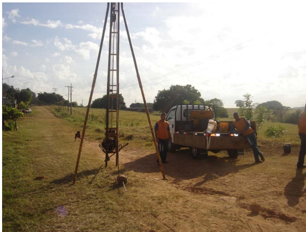
Sondagem Ponto S1
