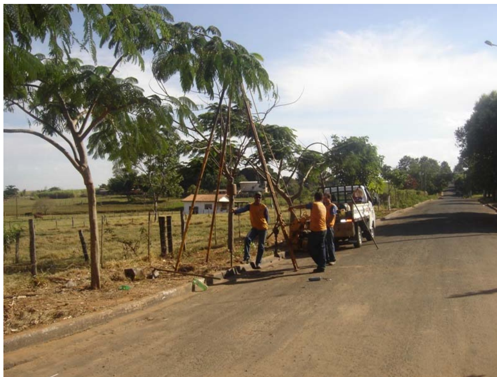
Sondagem Ponto S2
