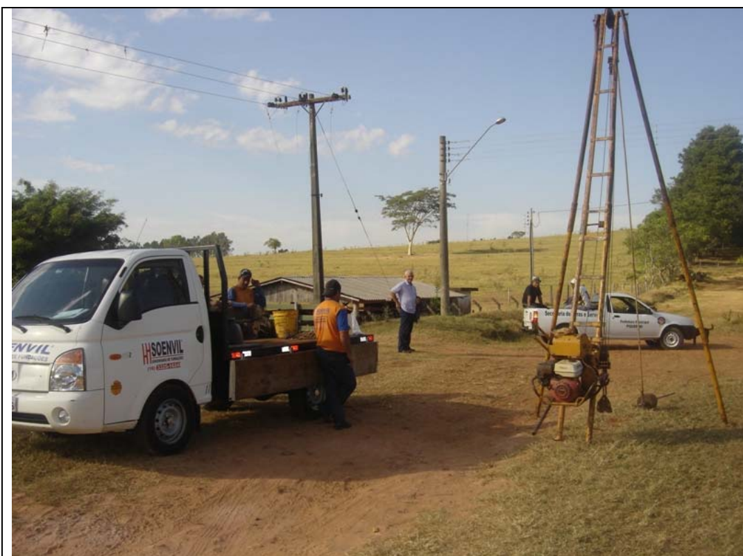
Fig. 06. Ponto de Sondagem S2
