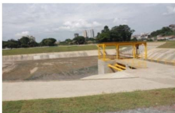
reservatório de amortecimento de cheia
