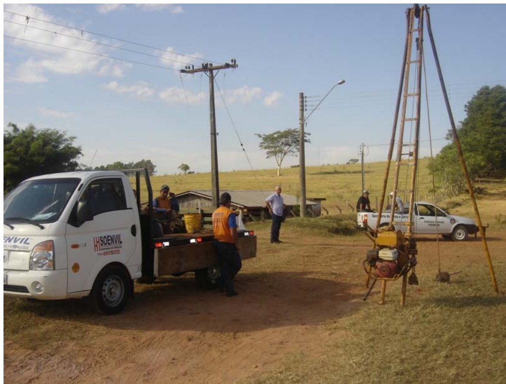
Sondagem Ponto S1
