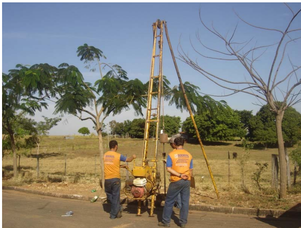
Sondagem Ponto S2
