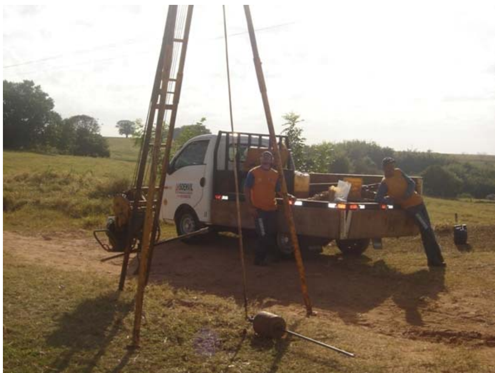
Sondagem Ponto S1
