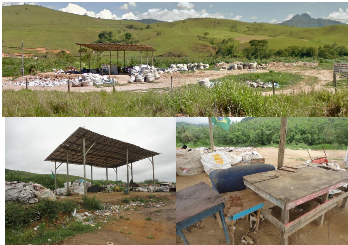
FIGURA 33 – Galpão de reciclagem
