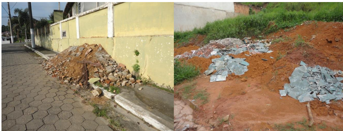
FIGURA 26 – Pontos clandestinos de disposição de RCC
