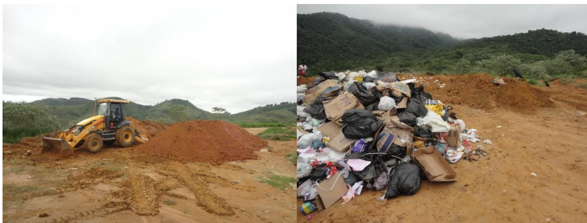
FIGURA 30 – Operação da vala no aterro sanitário
