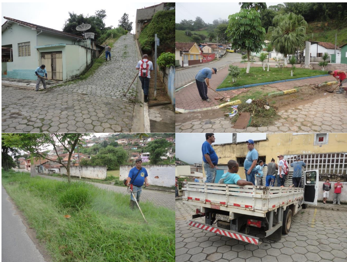
FIGURA 17 – Equipamentos e equipe da Capina, Roçada e Poda
