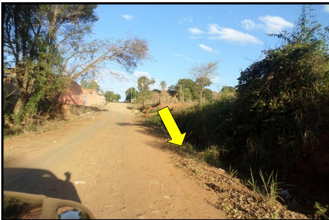
Av. 7 de Setembro - Processo Erosivo devido ao escoamento da água pluvial
