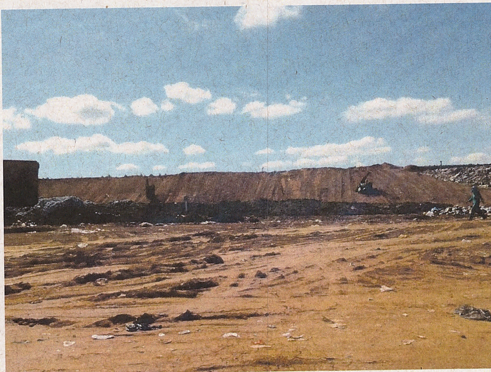
Aterro da empresa CGR Guatapar
