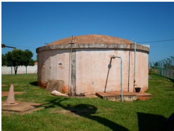
Foto 4.28 – Reservatório Semienterrado do Poço Matadouro
