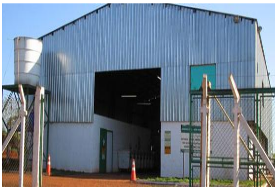
Foto 4.39 - Unidade de Tratamento NGA
