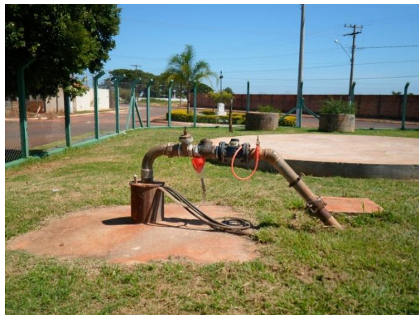
Foto 4.26 – Poço da Av. Saudade
