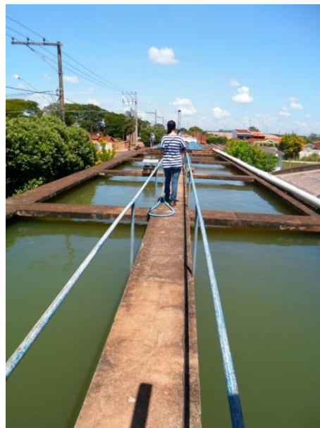
Foto 4.12 – Vista dos floculadores da ETA
