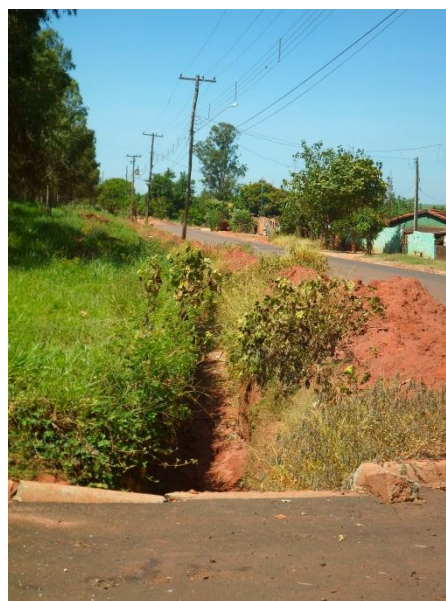
Foto 4.44 - Drenagem – Distrito Ibitiúva
