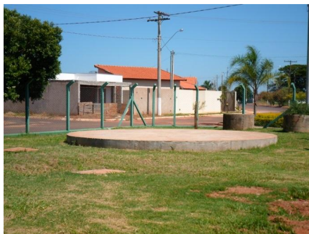
Foto 4.31 – Área do futuro reservatório do Poço da Av. da Saudade
