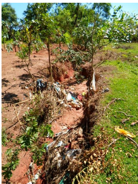
Foto 4.43 - Drenagem – Distrito Ibitiúva
