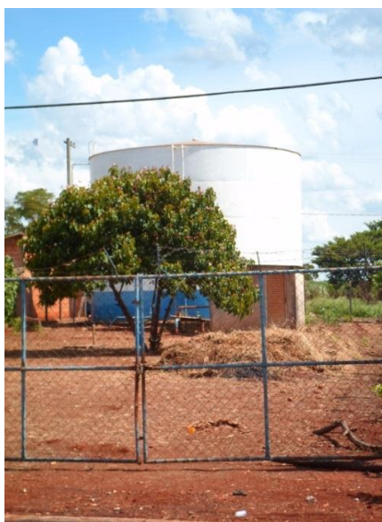
Foto 4.21 – RAP Jd. Bela Vista – Capacidade 500 m³
