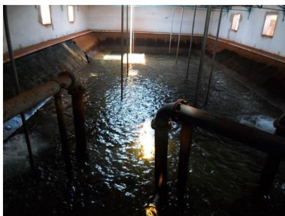
Foto 4.18 – Reservatório Semienterrado Centro – Capacidade 300 m³
