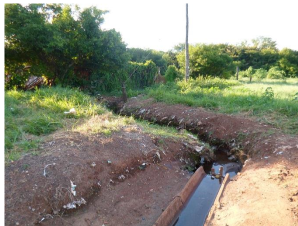
Foto 4.42 - Travessia de água pluvial – Pitangueiras
