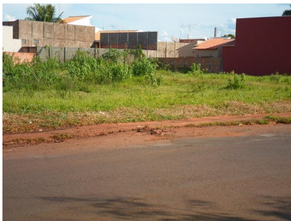
Foto 4.41 - Problemas de pavimentação – Pitangueiras
