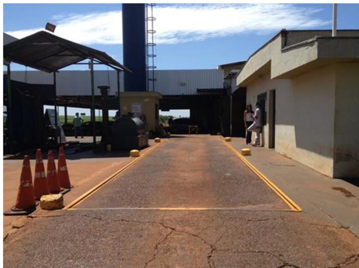
**Figura 10: Balança rodoviária (Copercana) utilizada pela empresa LUMA para aferição dos serviços.**
