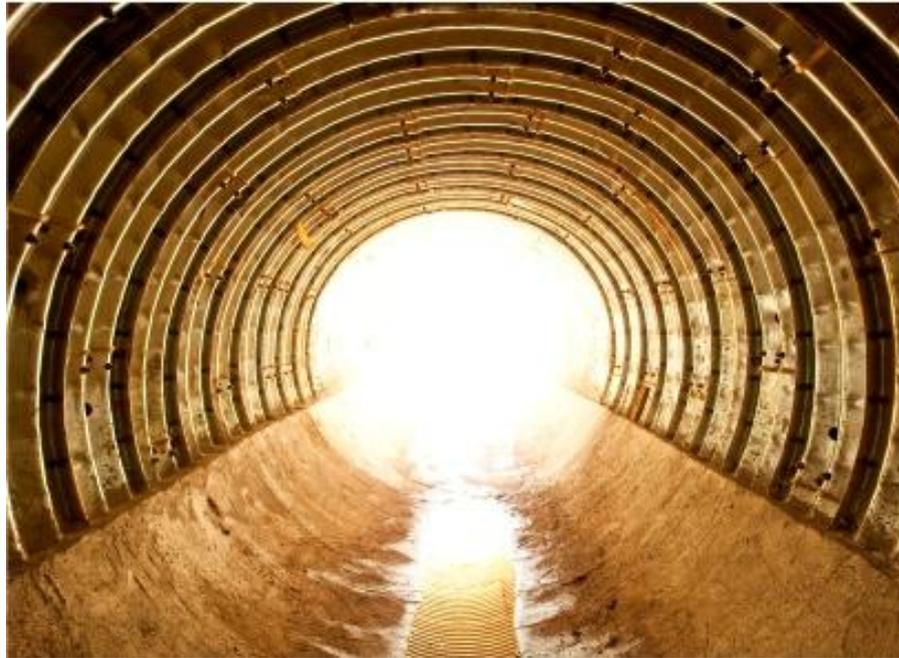
Ilustração 8.3 – BSTM construído por método não destrutivo (MND)
