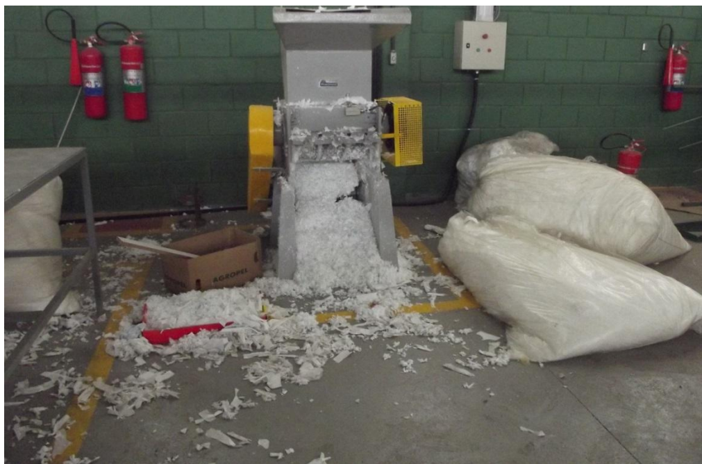
Figura 26 – Equipamento de beneficiamento de materiais, Julho/2014.
