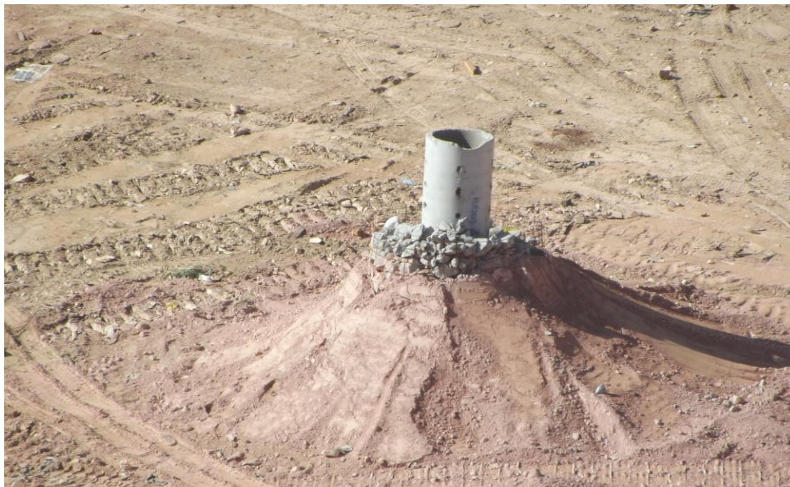
Figura 17 - Local de queima do excesso de gás oriundo da decomposição de matéria orgânica Julho/2014.
