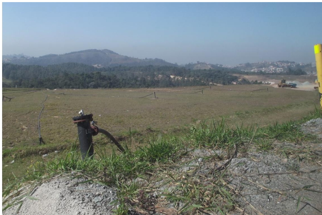
Figura 18 - Pontos de captação e drenagem do gás para estação de Biogás em Julho/2014.
