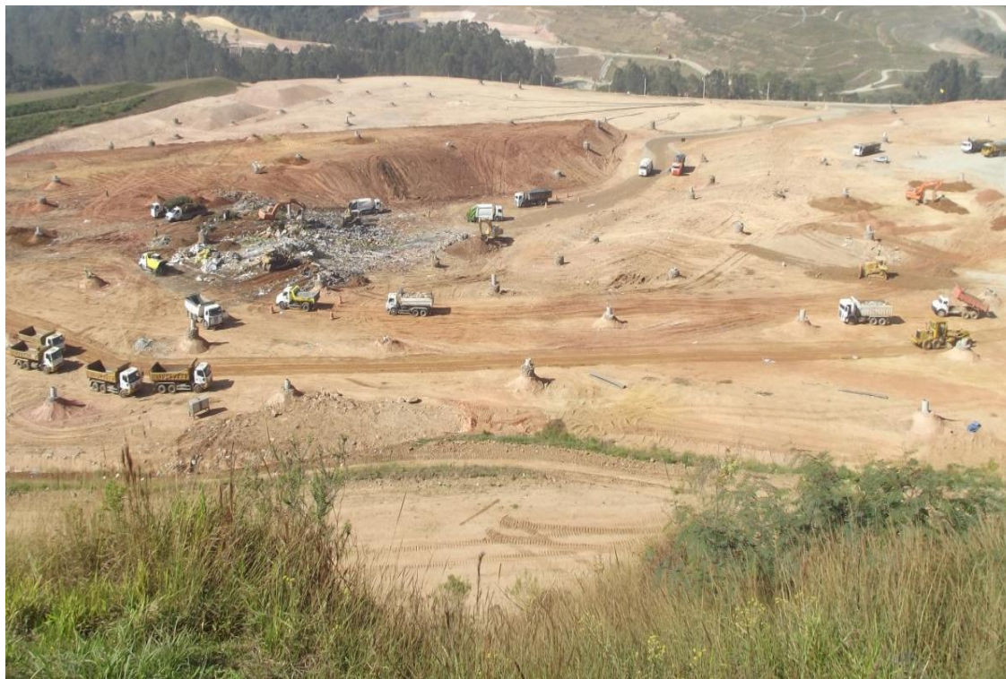
Figura 15 - Aterro sanitário CDR Pedreira em operação de descarga e aterro em Julho/2014.
