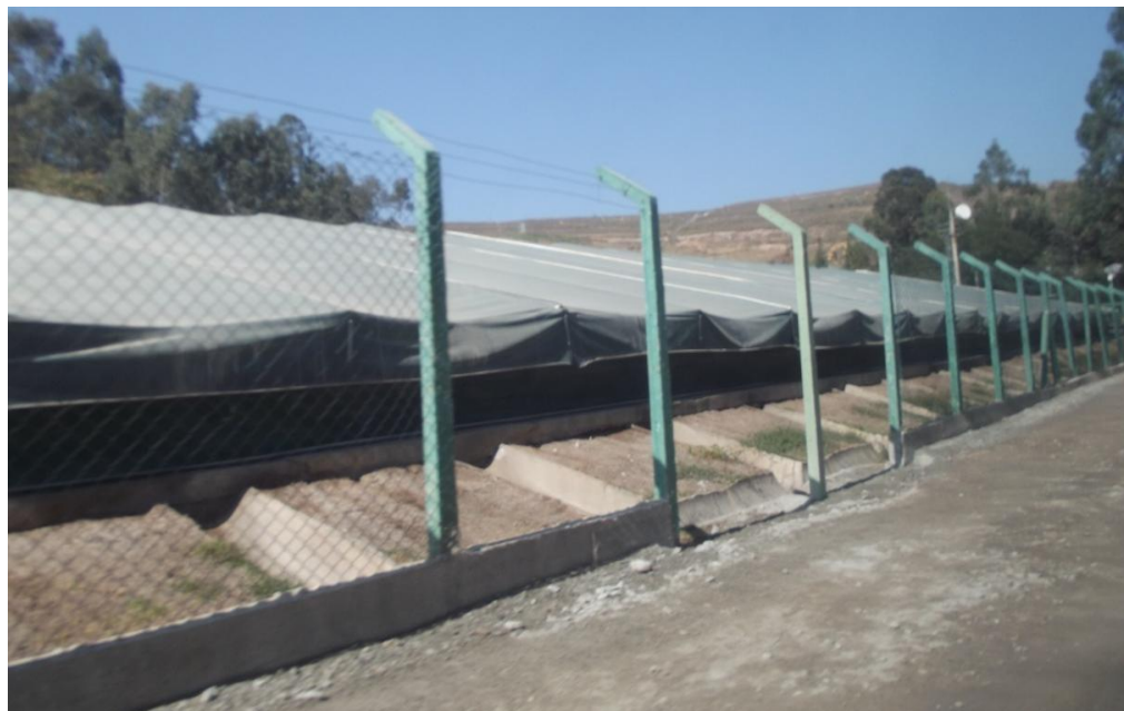
Figura 21 – Lagoa de retenção do chorume gerado no aterro sanitário CDR Pedreira.
