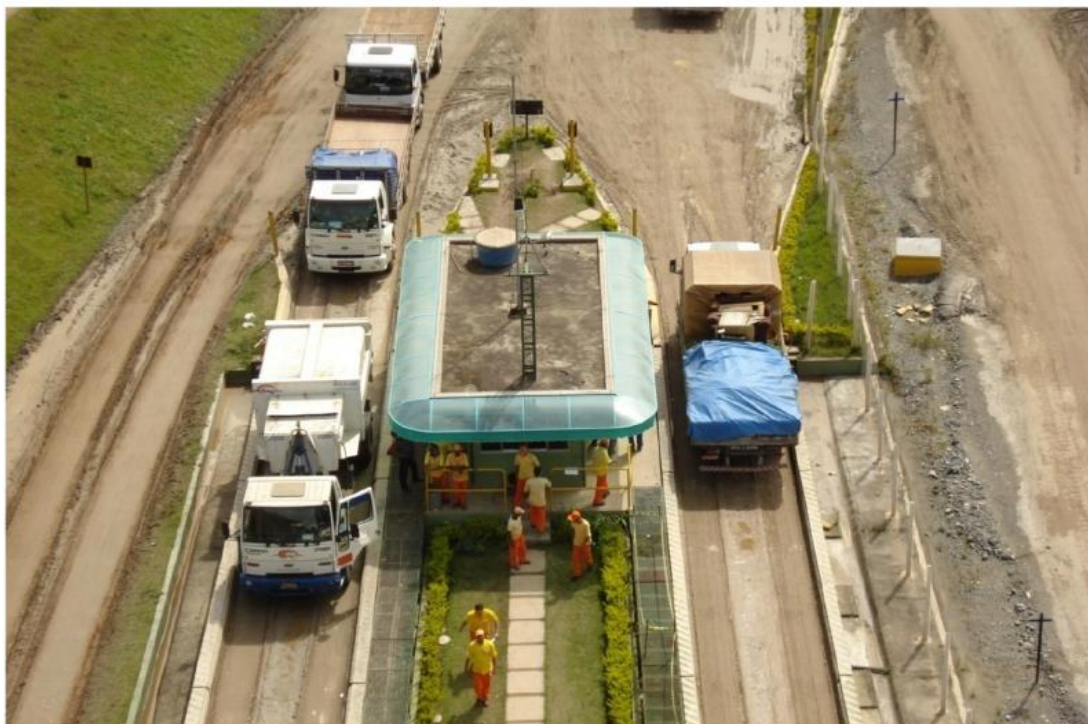
Figura 19 – Balança de controle e pesagem na entrada do aterro sanitário CDR Pedreira Fonte: Arquivo CDR.
