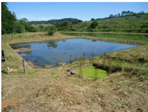
Foto 3.87 – Lagoa Anaeróbia – ETE Cury
