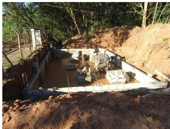
Foto 3.78 – Reforma – EEE Olmira Pereira
