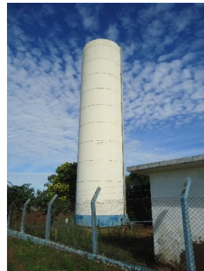
Foto 3.19 – Reservatório apoiado – Res. Boa Vista
