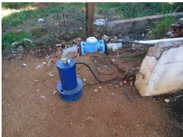
Foto 3.38 – Poço Portal dos Pássaros 01
