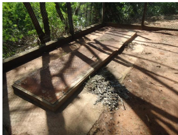
Foto 3.67 – Tratamento preliminar – EEE 1 – Vila Paulínea
