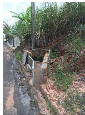
Foto 3.129 – Lançamento do escoamento superficial – Rua Francisco Colabono
