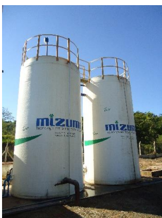
Foto 3.105 – Vista Geral – ETE Paulópolis
