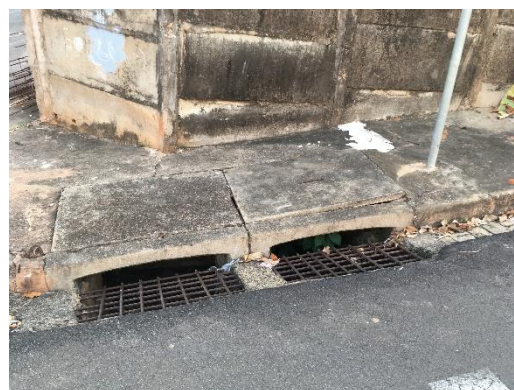
Foto 3.118 –Estrutura de drenagem – Rua Luiz Melgez
