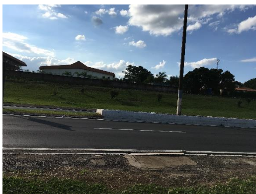
Foto 3.124 – Área que contribui para o alagamento
