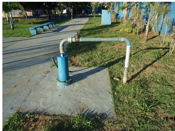
Foto 3.28 – Poço Mercado – JK I
