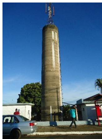
Foto 3.32 – Reservatório apoiado – JK II
