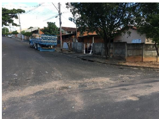
Foto 3.111 – Drenagem insuficiente – Rua Zanguetin
