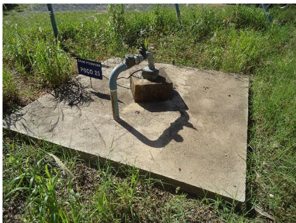
Foto 3.42 – Poço 25 – Rua Brasília
