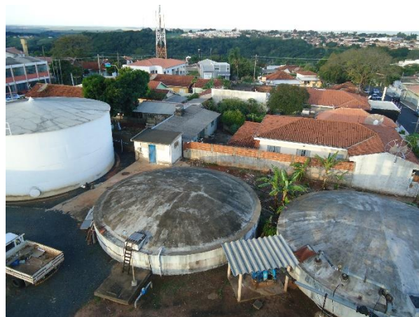
Foto 3.2 – Reservatórios sede municipal (R-01, R-02 e R-03)
