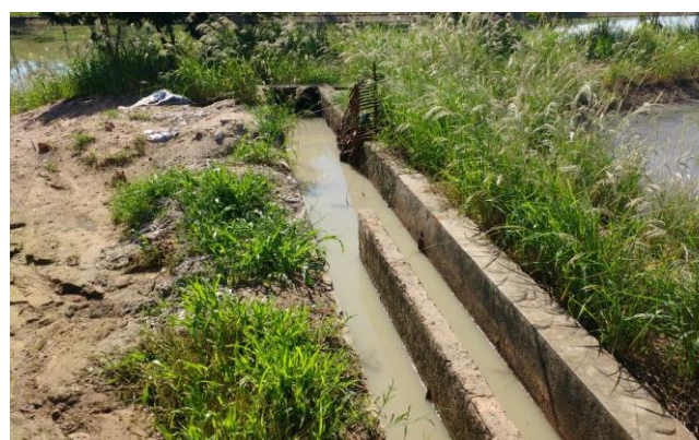
Foto 3.92 – Tratamento Preliminar – Caixa de Areia
