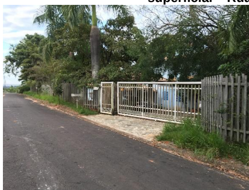
Foto 3.130 – Residências com soleiras negativas
