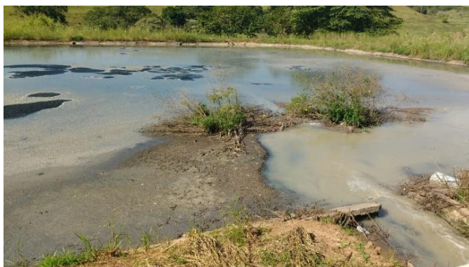
Foto 3.93 – Lagoa Anaeróbia – ETE Morro Azul
