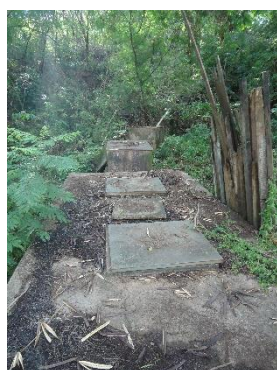
Foto 3.97 – Visão Geral – ETE Florentino Favoreto
