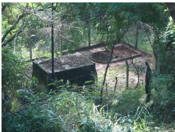
Foto 3.70 – Vista Geral – EEE 3 – Vila Paulínea
