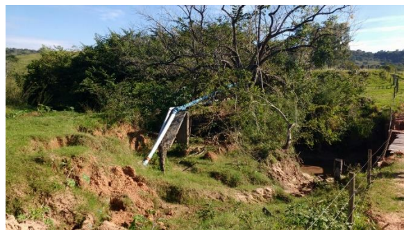
Foto 3.7 – Linha de recalque - Poço
