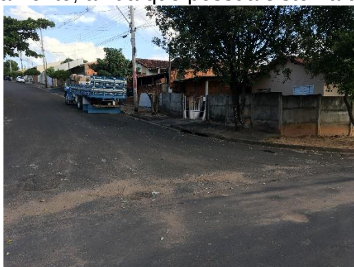
Foto 3.120 – Insuficiência de drenagem – Rua Zanguetin
