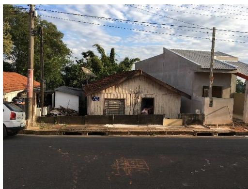
Foto 3.119 – Residência com soleiras negativas atingidas por alagamentos
