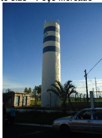
Foto 3.30 – Reservatório apoiado metálico – JK I
