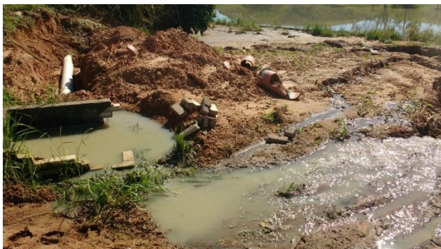
Foto 3.95 – Rompimento Caixa de Entrada – ETE Morro Azul
