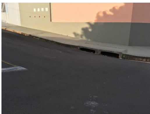
Foto 3.117 – Estrutura de drenagem – Rua Luiz Melgez
