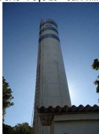
Foto 3.47 – Reservatório apoiado - Tufic
