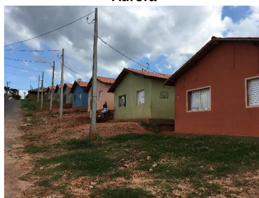
Foto 3.112 – Drenagem Insuficiente - CDHU
