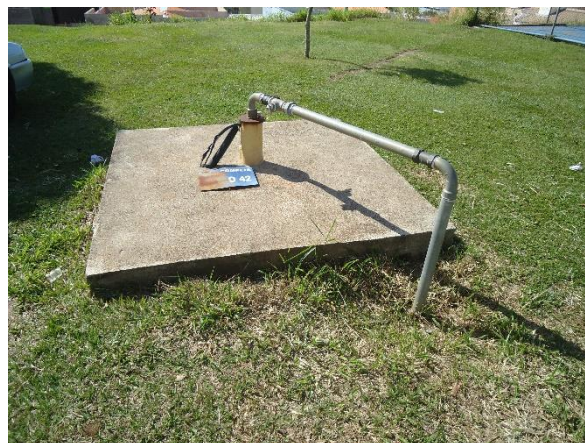
Foto 3.39 – Poço Portal dos Pássaros 02
