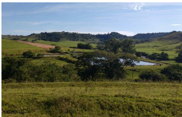
Foto 3.91 – Vista Geral – ETE Morro Azul
