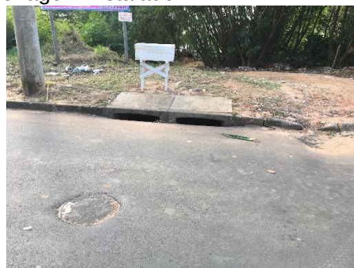
Foto 3.121 – Estrutura de drenagem – Rua Zanguetin
