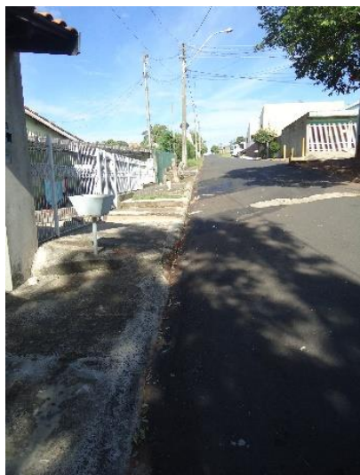
Foto 3.135 – R. Francisco Colabono – Via cujo escoamento contribui para a erosão
