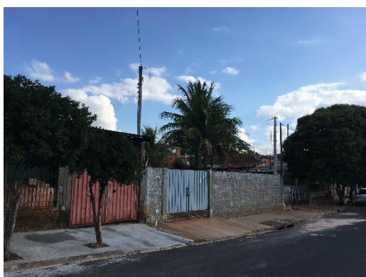
Foto 3.122 – Insuficiência de drenagem – Rua Zanguetin
