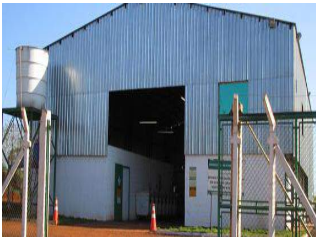
Foto 4.25 - Unidade de Tratamento NGA
