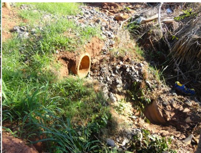
**Foto 3.11 – Ponto de lançamento de águas pluviais e erosão avançada – Próximo a rodovia Dr. Eliéser Montenegro Magalhães**
