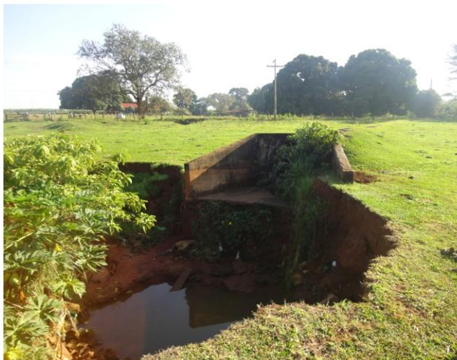
**Foto 3.6 – Lançamento da rede de drenagem – próximo a rua São Paulo, com erosão**
