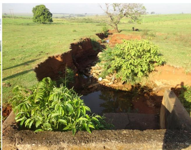
**Foto 3.7 – Lançamento da rede de drenagem – próximo a rua São Paulo, com erosão**
