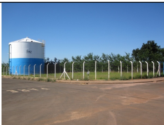
Foto 13 - Reservatório Joaquim Rodrigues Ribaldo.
