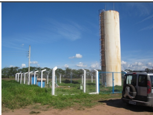
Foto 29 - Reservatório Águas Claras.
