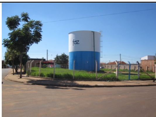
Foto 24 - Reservatório Porto Belo.
