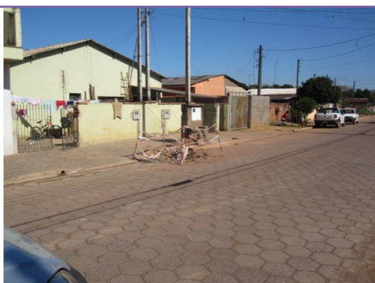
Foto 48 - Estação elevatória de esgotos EEE-6E (N. Sra. Aparecida 03), que será desativada.
