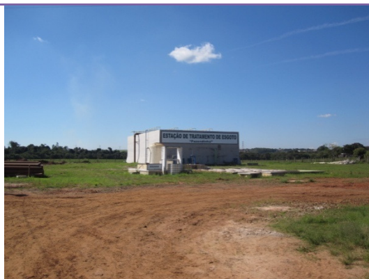
Foto 75 - Vista de um dos reatores UASB da ETE da Fazendinha, em implantação.
