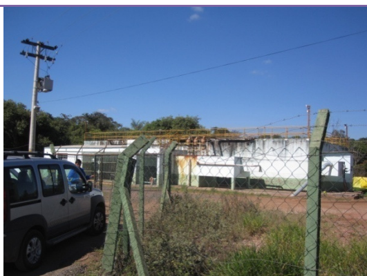
Foto 50 - Vista geral da ETE Santa Rosa.
