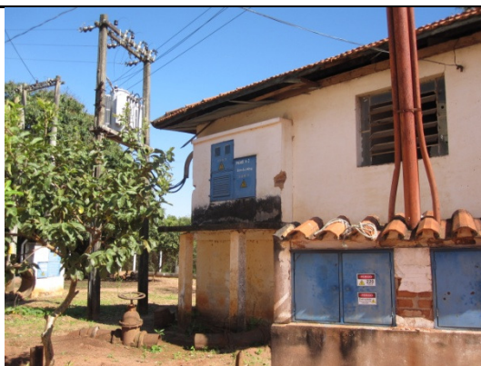
Foto 12 - Elevatória "antiga" da captação nº 1.
