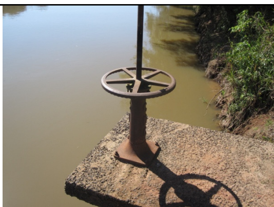
Foto 9 - Tomada de água da captação nº 1 localizada no rio Mogi Guaçu.
