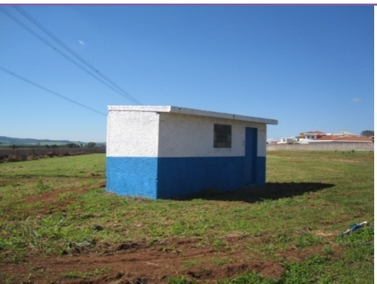
Foto 68 - EEE Las Palmas, unidade que será desativada.
