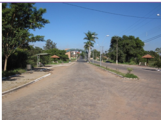
Foto 42 - Vista da Avenida Francisco Peripato, por onde seguirá a linha de recalque da EEE-4E reformada.
