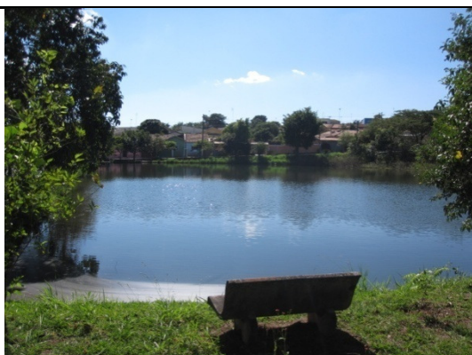
Foto 15 - Vista do lago da captação nº 2, junto à ETA 2.
