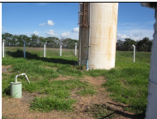
Foto 31 - Outra vista do reservatório Aguas Claras e do poço de captação de água subterrânea nº 2.
