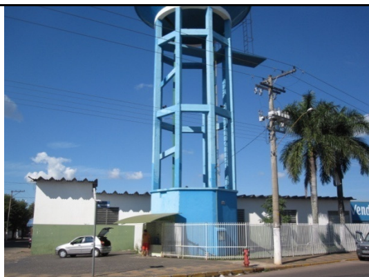
Foto 35 - Reservatório Jd. Primavera (vista da base).
