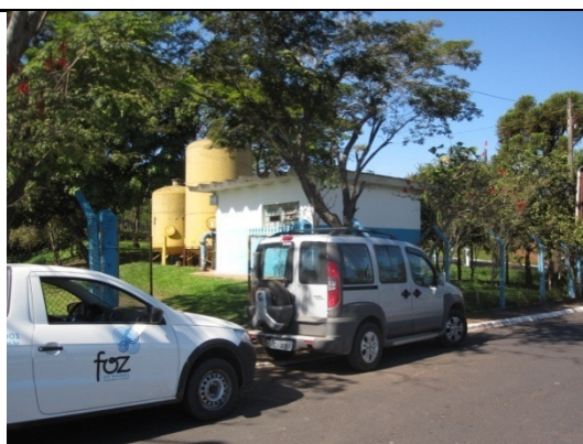
Foto 18 - Entrada da ETA 2
