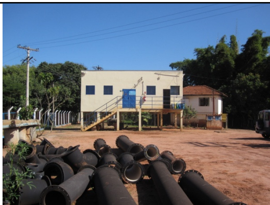
Foto 8 - Subestação de energia da captação nº 1.
