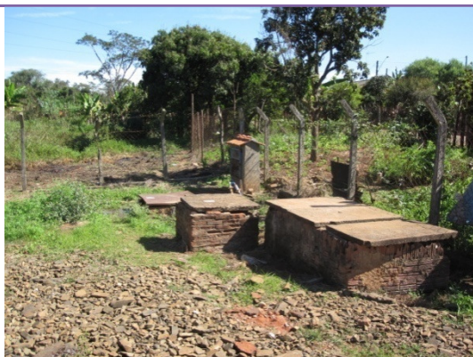
Foto 74 - Vista do quadro de comando da EEE Paschoal Salzano.
