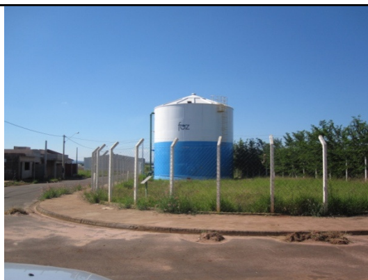
Foto 14 - Outra vista do reservatório Joaquim Rodrigues Ribaldo.
