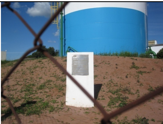
Foto 37 - Detalhe da base do reservatório Jd. Aeroporto.
