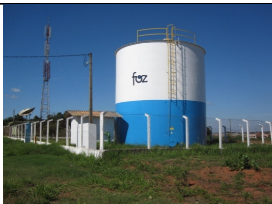
Foto 22 - Reservatório Vila Real.
