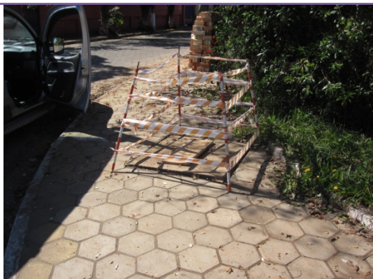
Foto 40 - Estação elevatória de esgotos EEE-4E (N. Sra. Aparecida 01), que será reformada.
