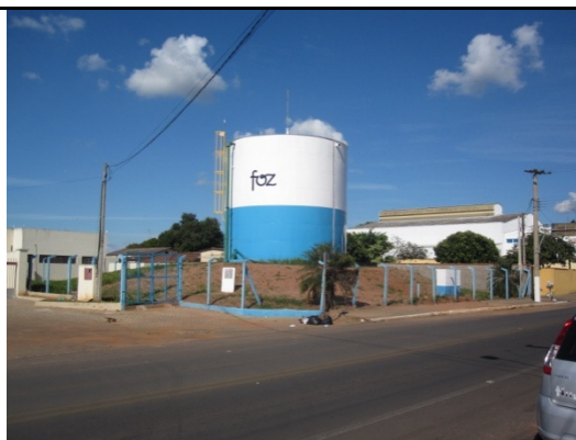
Foto 36 - Reservatório Jd. Aeroporto.
