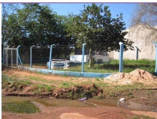
Foto 72 - Outra vista do fundo da EEE Porto Bello II.
