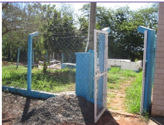
Foto 69 - Entrada da EEE Porto Bello II, unidade que será desativada.
