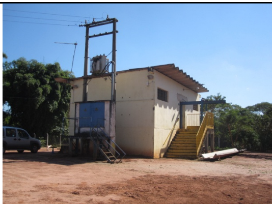
Foto 7 - Vista da edificação da elevatória "nova" da captação nº 1.
