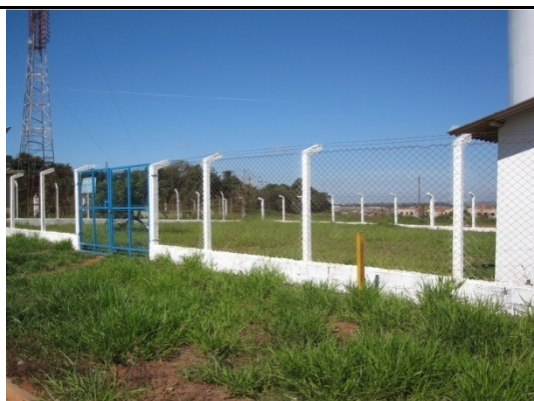
Foto 23 - Vista de área reservada junto ao reservatório Vila Real.
