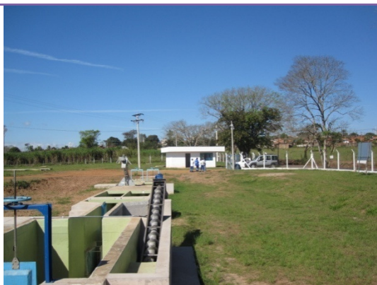
Foto 80 - Vista do tratamento preliminar, (em primeiro plano) e portaria da ETA da fazendinha (ao fundo).
