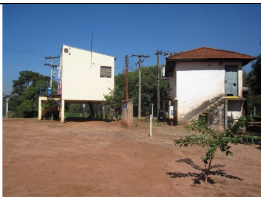
Foto 11 - Vista da subestação de energia (à esquerda) e elevatória antiga (à direita).
