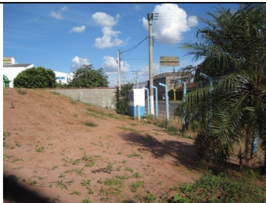
Foto 38 - Vista da área interna do reservatório Jd. Aeroporto.
