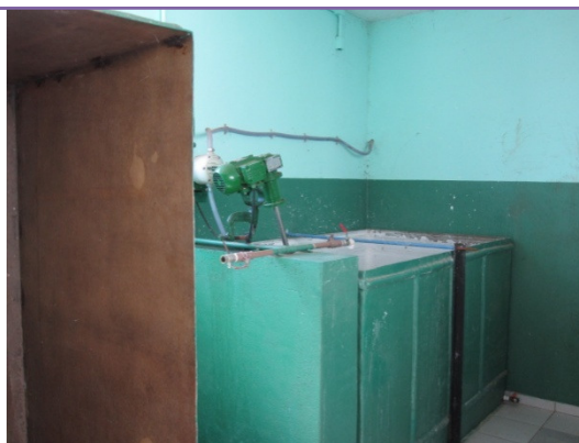
Foto 65 - Outra vista do tanque anterior.
