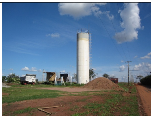
Foto 32 - Reservatório Areia Branca.
