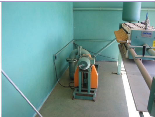
Foto 62 - Vista do filtro-prensa.
