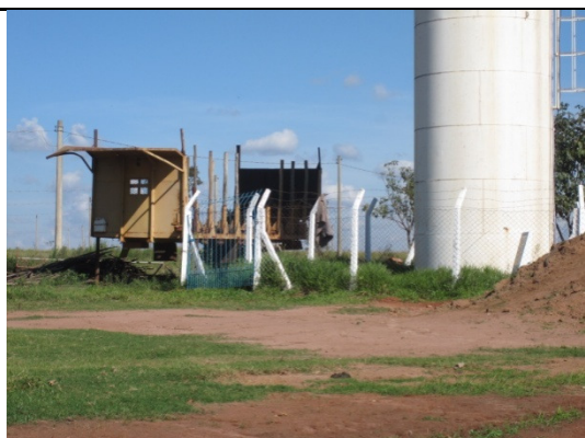
Foto 33 - Outra vista do reservatório Areia Branca.
