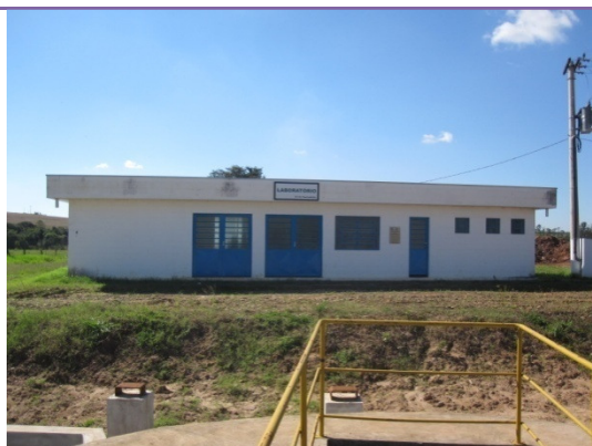
Foto 79 - Vista da casa de operação e laboratório da ETE da Fazendinha.
