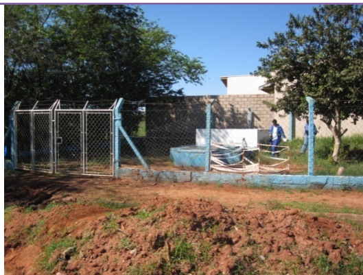
Foto 71 - Vista do fundo da EEE Porto Bello II.
