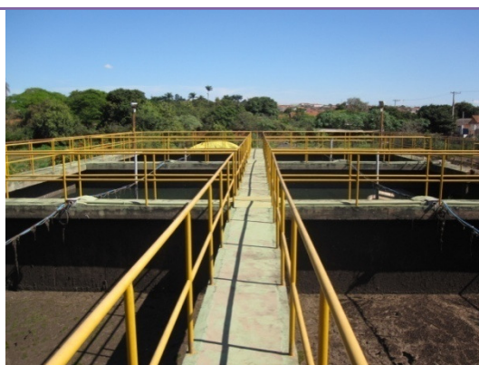
Foto 55 - Vista geral dos tanques de aeração.
