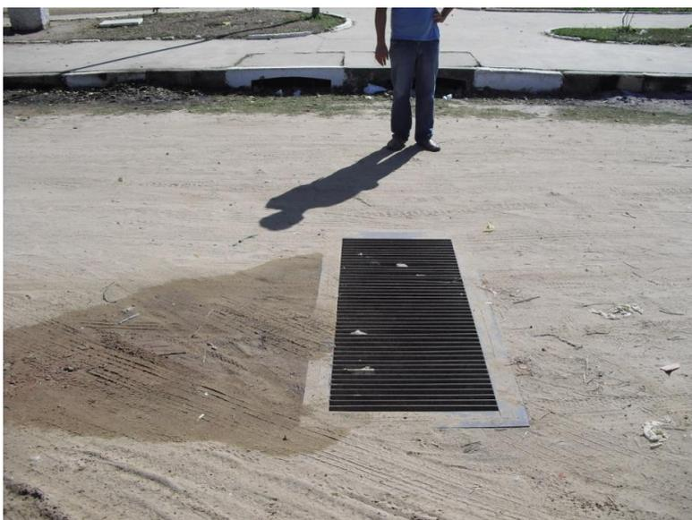
**Foto 13 – Estrutura com grelha para coleta das águas pluviais e boca de lobo dupla ao fundo.**
