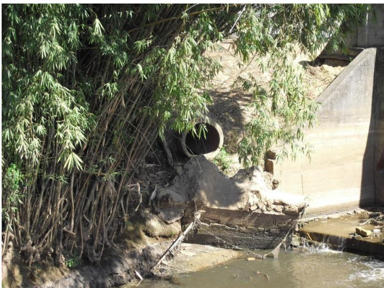
**Foto 12 – Lançamento de galeria de água pluvial no Ribeirão Potim.**
