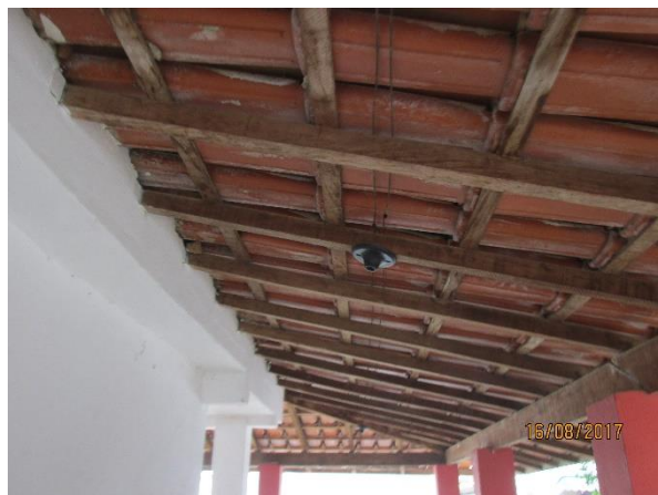
FIGURA 26 - ARMAZENAMENTO IRREGULAR DE RSS NO ESF-E (EXTENSÃO)
