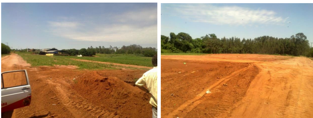
Figura 47 - Valas do aterro sanitário de Potirendaba - SP.
