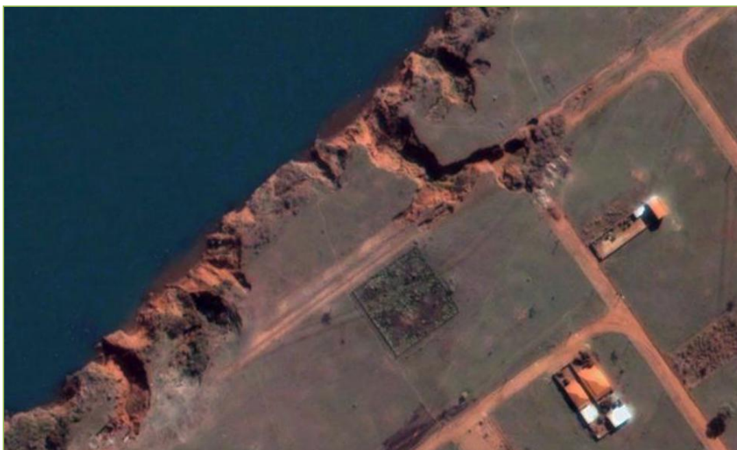
Imagem 09: Erosões nas encostas do Village Lagoinha.
