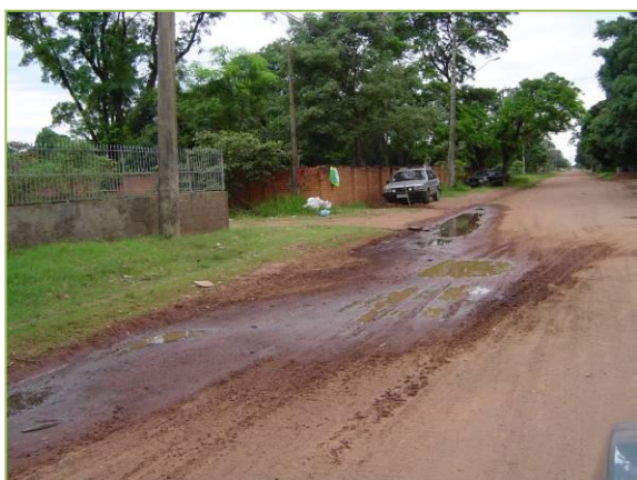
Foto 87. Área de Alagamento
