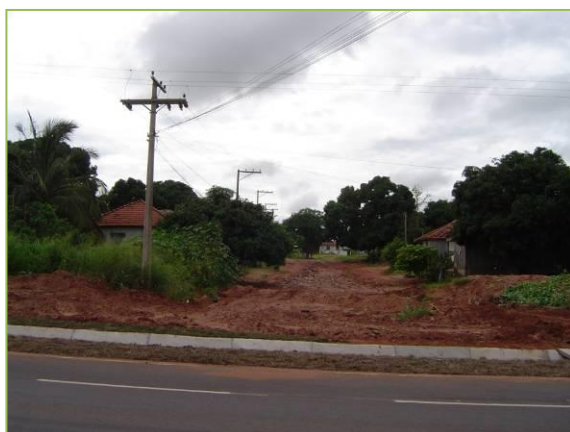
Foto 81. Canal de escoamento
