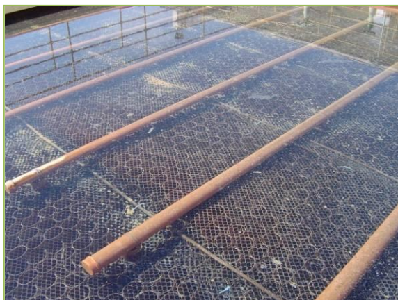
Fotos 08 e 09 – Decantadores e seus vertedouros
