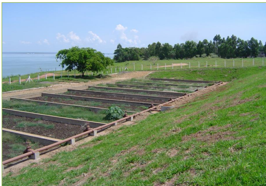
Foto 38: Caixas de Contenção para secagem do lodo
