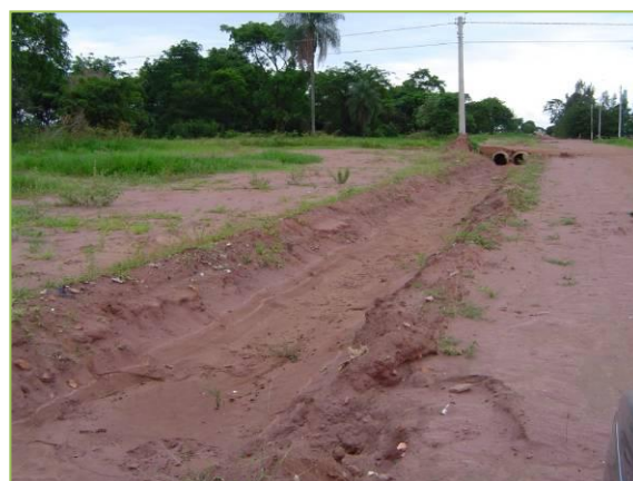
Foto 97. Canal de escoamento
