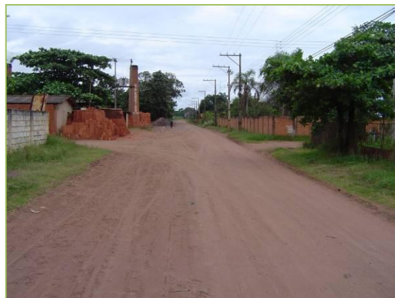
Foto 86. Área de Alagamento
