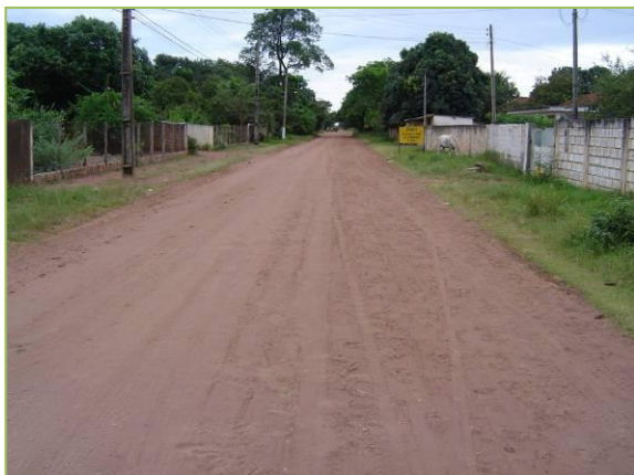
Foto 85. Área de alagamento
