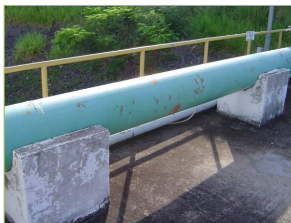
Foto 02: Tubulação de ferro fundido.
