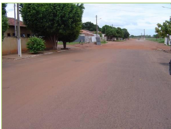
Foto 82. Ponto de alagamento
