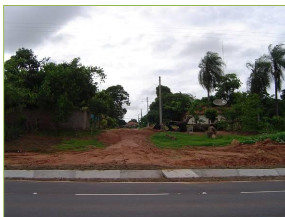
Foto 80. Canal de escoamento
