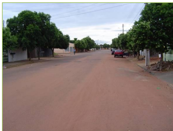
Foto 83. Ponto de alagamento
