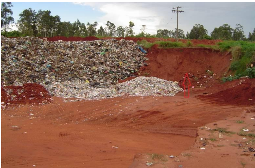
Foto 43: Dimensões da "vala" de aterramento.
