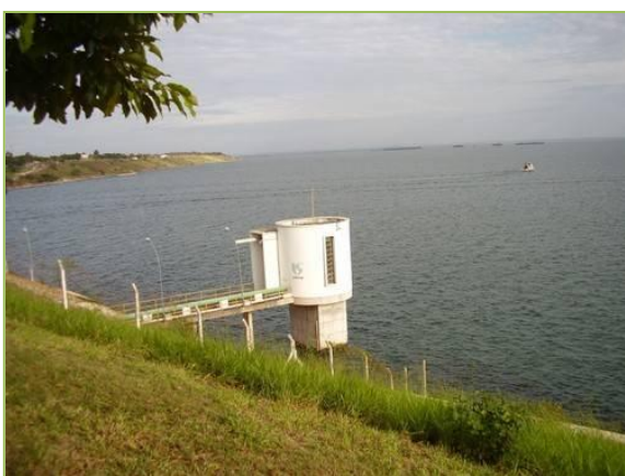
Foto 01: Estrutura de Captação Augusto Muniz
