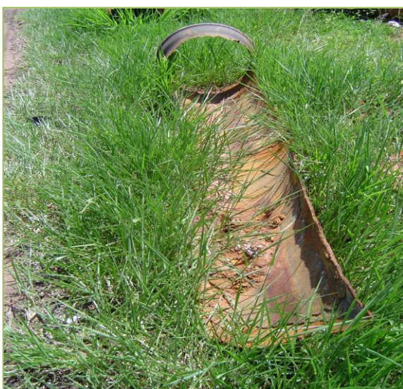
Fotos 39 e 40- Deterioração das tubulações
