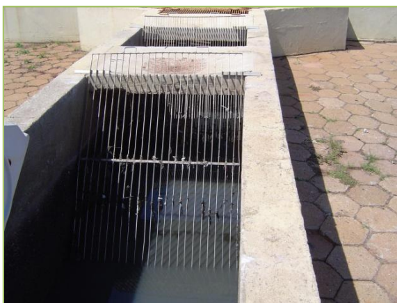
Foto 31 e 32 – Processo de Gradeamento e Leitos de Secagem de Lodo
