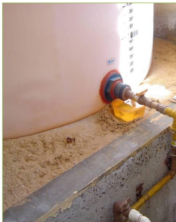
Fotos 10 e 11 - Vista do bocal de saída de Hipoclorito de Sódio, com vazamento
