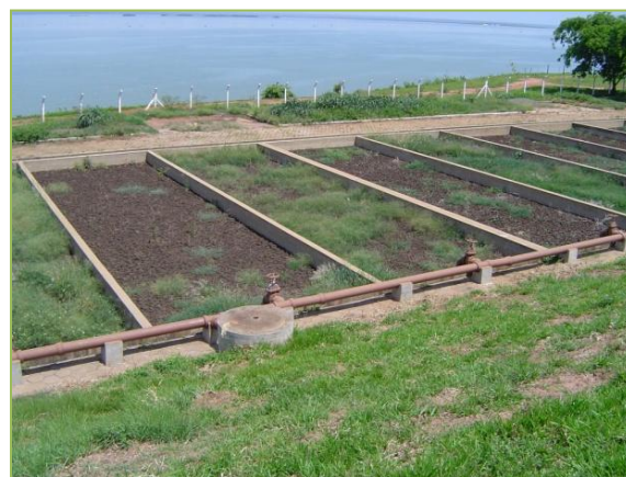
Foto 31 e 32 – Processo de Gradeamento e Leitos de Secagem de Lodo
