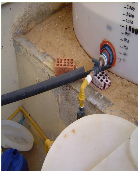
Fotos 10 e 11 - Vista do bocal de saída de Hipoclorito de Sódio, com vazamento
