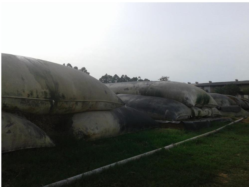
**Figura 45 - Sistema de drenagem e secagem do lodo proveniente da ETE.**
