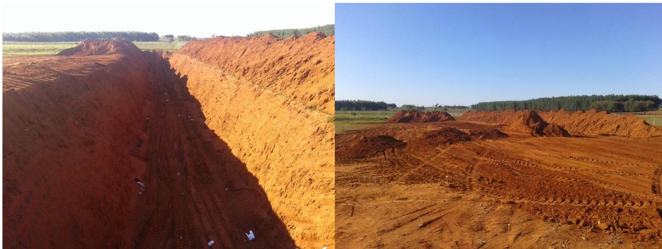
**Figura 24 - Visão Geral da primeira trincheira do Aterro Sanitário nº 03.**
