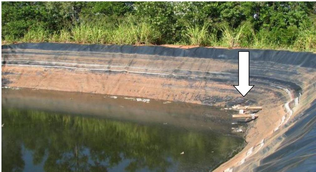
**Figura 23 - Lagoa de chorume, destaque para tubulação de lançamento.**
