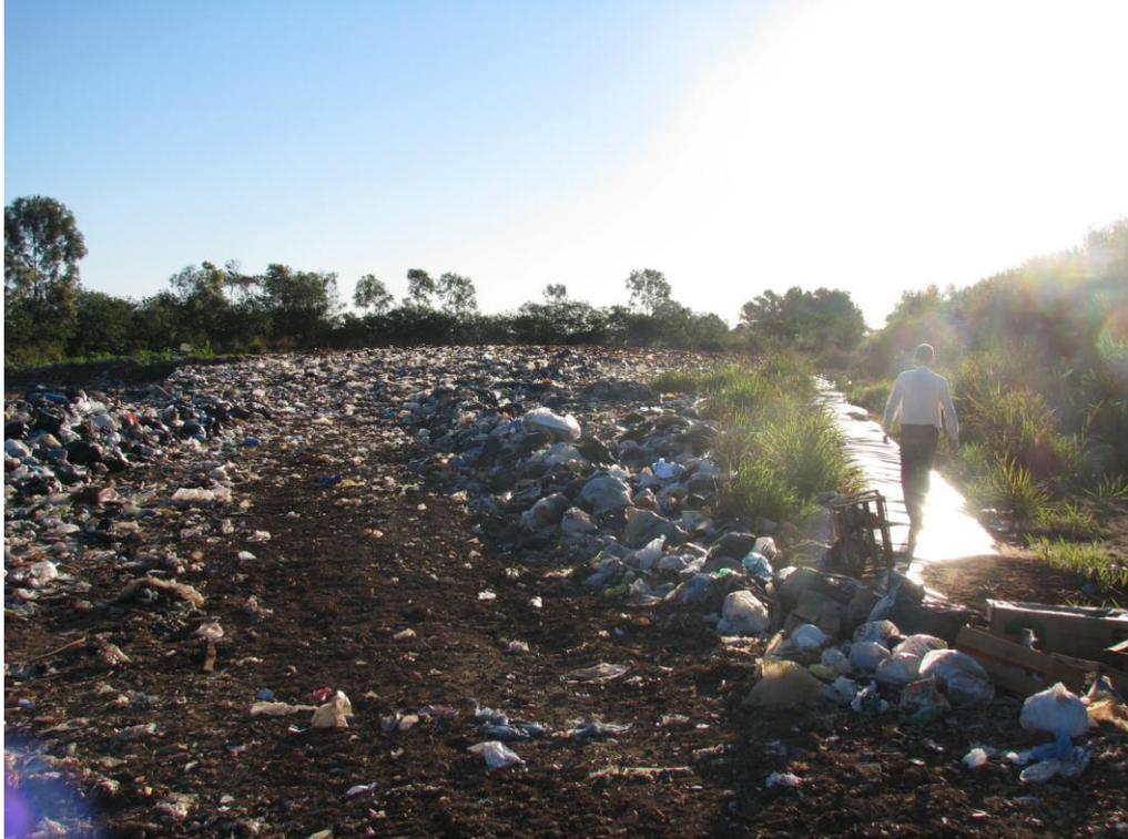
**Figura 19 - Área do Aterro Sanitário destaque para o lixo sem cobertura na trincheira e acima da capacidade máxima da vala.**
