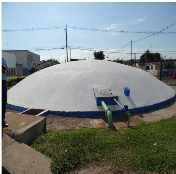
Figura 47 – reservatório semi enterrado na ETA
