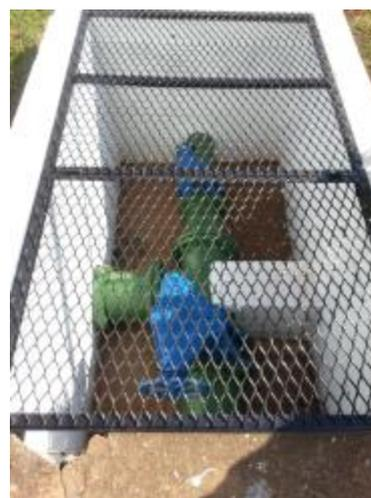
**Figura 38 – Distribuição da água bruta para as ETAs 1 e 2**
