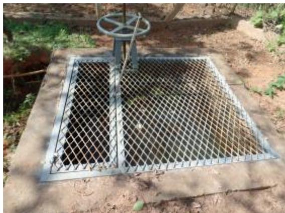
Figura 30 - BayPass – caixa de retenção de areia
