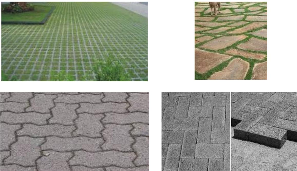
**Figura 96 a 99 - Pavimentos Permeáveis (Blocos vazados Gramados, Concreto poroso e tipo Paver).**Fonte das imagens: Associação Brasileira de Cimento Portland – ABCP/SP (2014).
