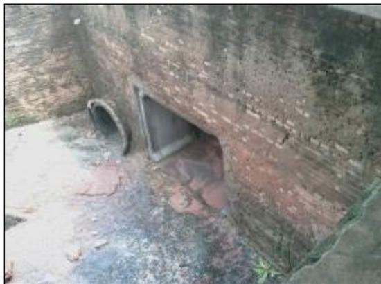
Figura 94 – Caixa de acumulação junto à ferrovia
