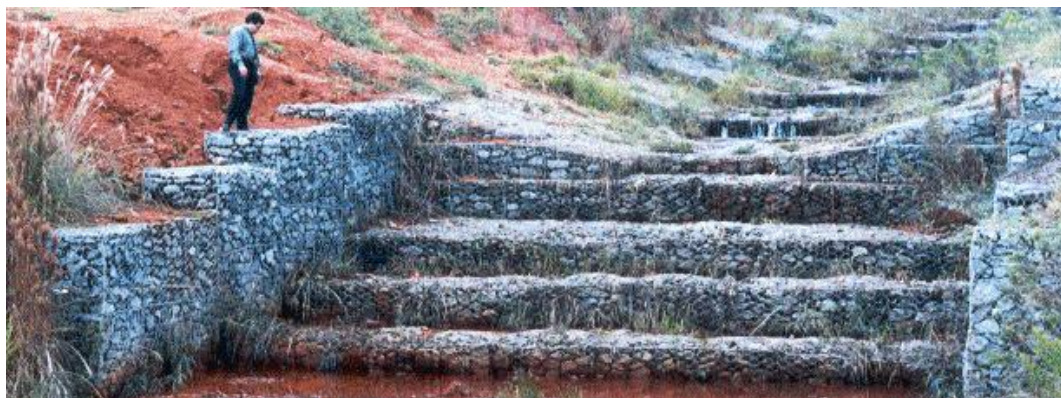
Ilustração 8.10 – Dispositivo de amortecimento em degraus de gabião
