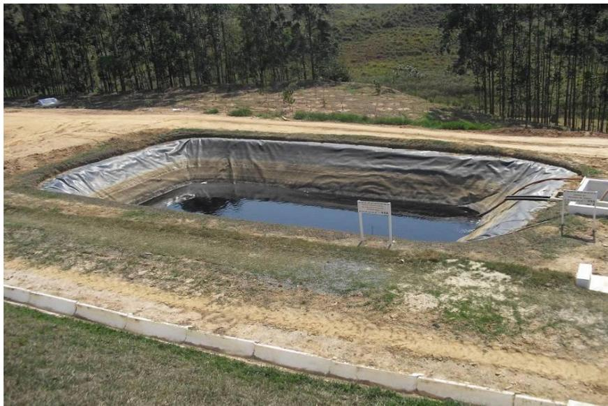
Foto 16 - Tanque Reservatório de Líquido Percolado – Chorume.
