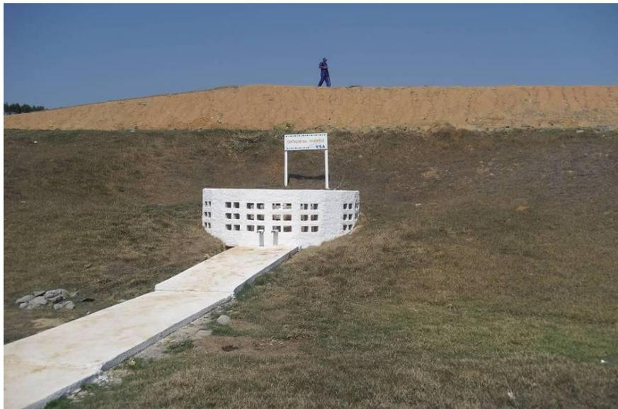
**Foto 15 - Poço de Captação de Líquido Percolado – Chorume.**
