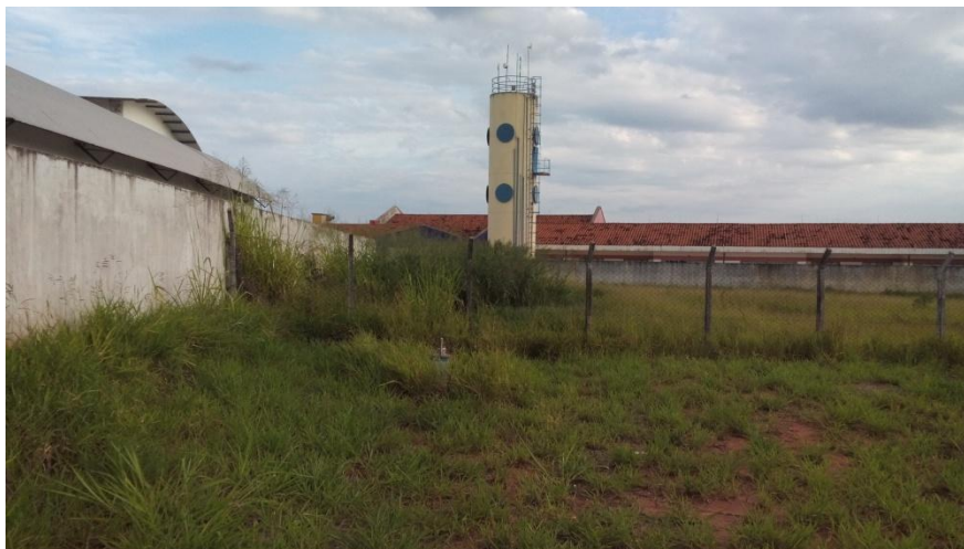
Foto 3.11 – Poço Profundo – PP-17
