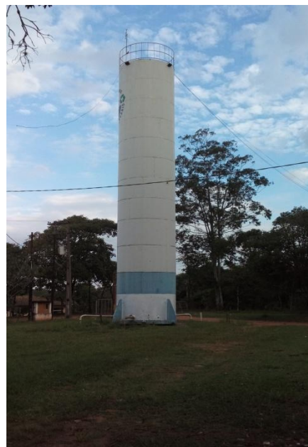
Foto 3.29 – Detalhe do Reservatório do Balneário
