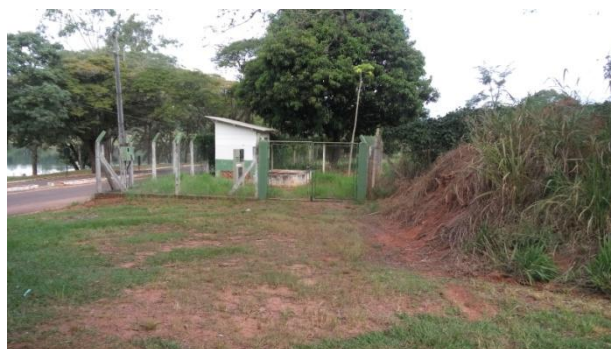
Foto 3.51 – Vista da EEE Final
