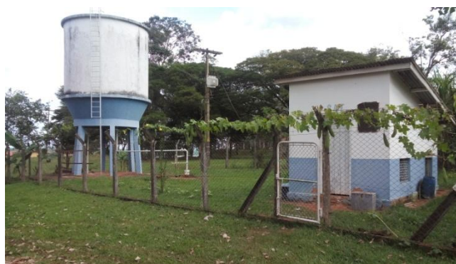
Foto 3.27 – Vista do Centro de Reservação de Gardênia
