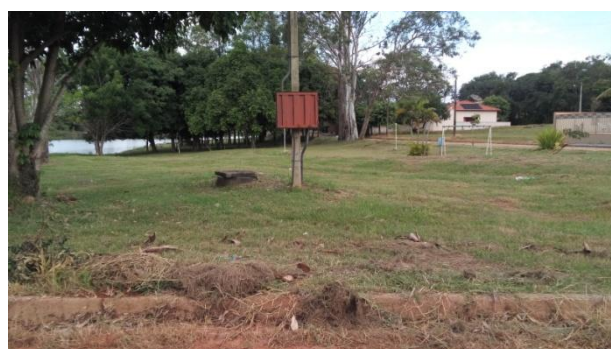
Foto 3.49 – Vista da EEE 04
