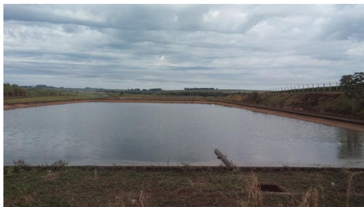
Foto 3.45 – Vista da ETE Gardênia
