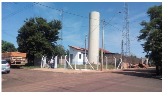
Foto 3.21 – Vista do Centro de Reservação
