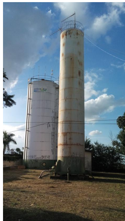
Foto 3.18 – Vista dos reservatórios apoiados do Jardim Europa I
