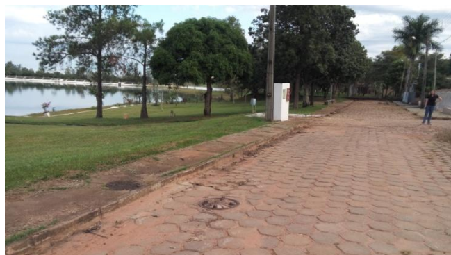
Foto 3.46 – Vista da EEE 01
