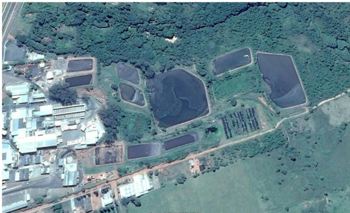
Foto 3.32 – Vista aérea da ETE Rancharia
