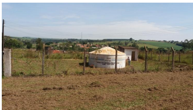
Foto 3.24 – Vista do Centro de Reservação 02
