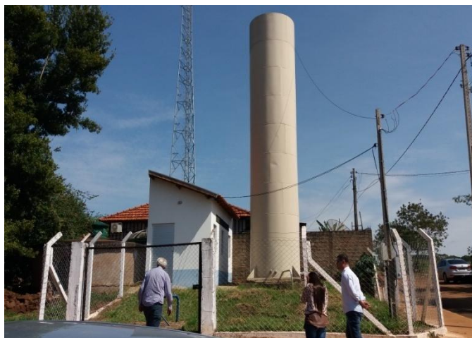
Foto 3.23 – Vista do Reservatório
