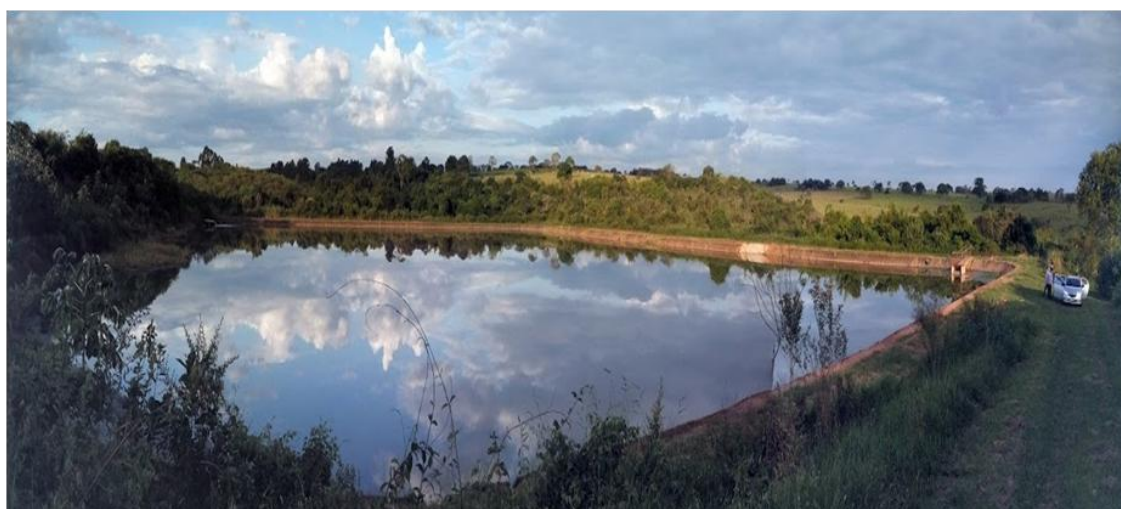
Foto 3.33 – Vista parcial da ETE Rancharia
