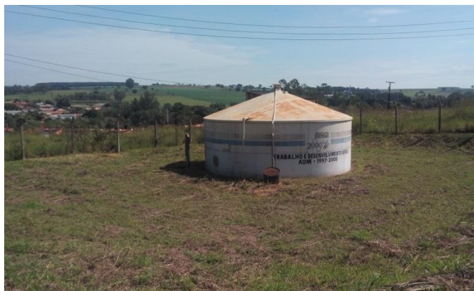
Foto 3.26 – Vista do Reservatório
