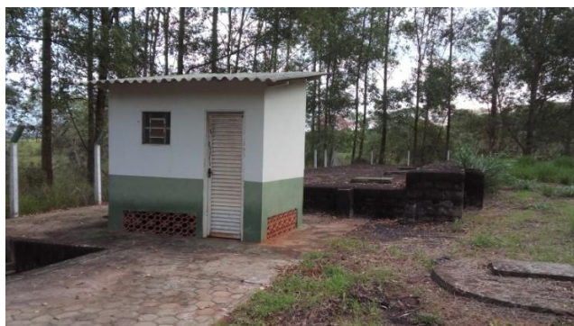
Foto 3.52 – Vista da Casa de Química da ETE Balneário
