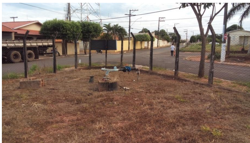
Foto 3.7 – Poço Profundo – PP 13
