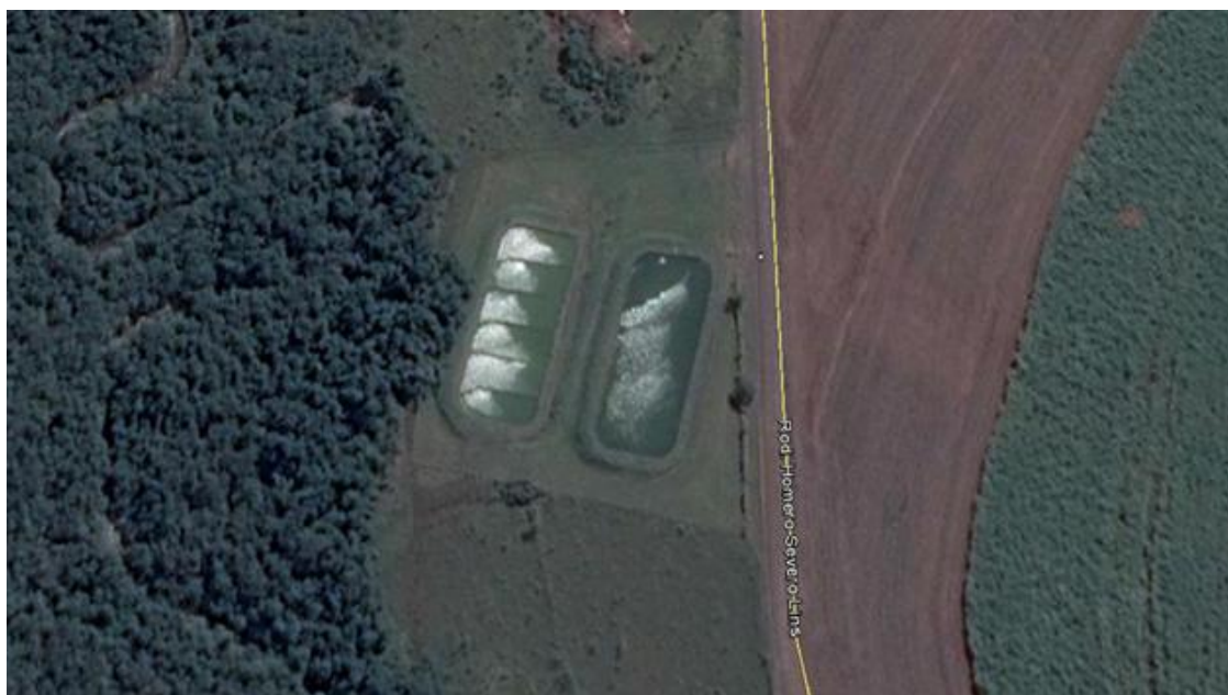
Foto 6.41 – Vista Aérea da ETE Agissê
