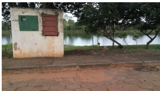
Foto 3.48 – Vista da EEE 03
