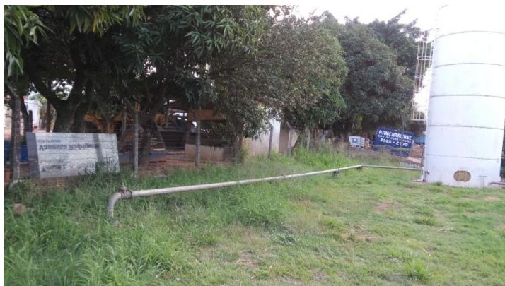
Foto 3.6 – Poço Profundo – PP-12
