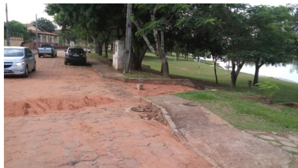
Foto 3.47 – Vista da EEE 02
