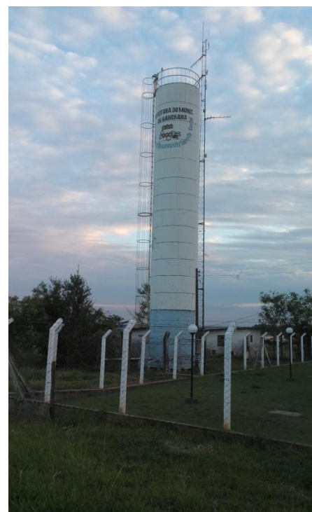
Foto 3.16 – Vista do reservatório apoiado do Jardim Novo Cruzado
